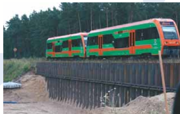
Autostrada A-1 - obiekt WA81 - ścianka szczelna wciskana, zabezpieczająca torowisko, posadowienie obiektu na palach prefabrykowanych wbijanych
