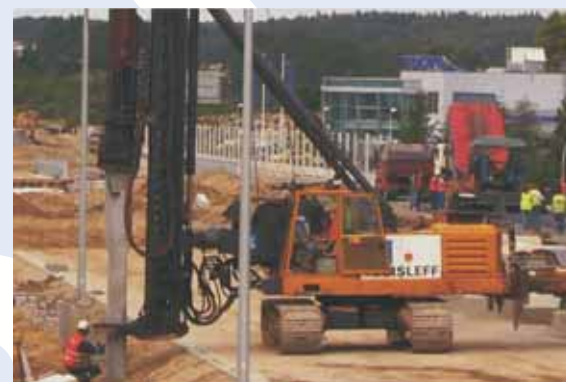
Gdańsk - Trasa W-Z - ekrany akustyczne posadowione na palach prefabrykowanych wbijanych
