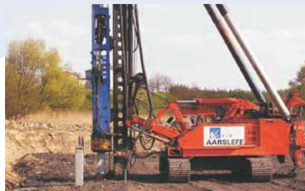
Autostrada A-1 - odcinek Świerklany-Gorzyczki - posadowienie na palach prefabrykowanych wbijanych
