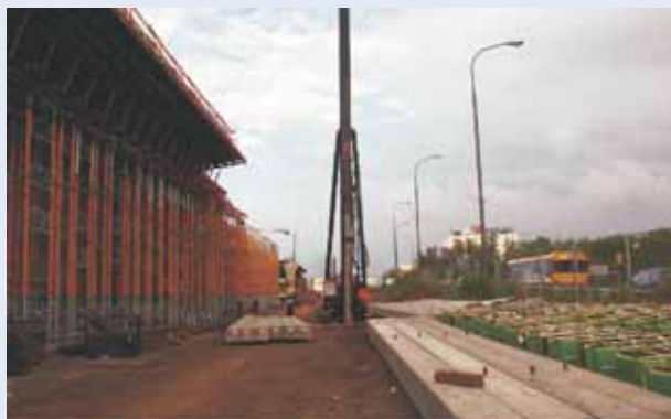
Trasa Siekierkowska - Warszawa - posadowienie estakad na palach prefabrykowanych wbijanych
