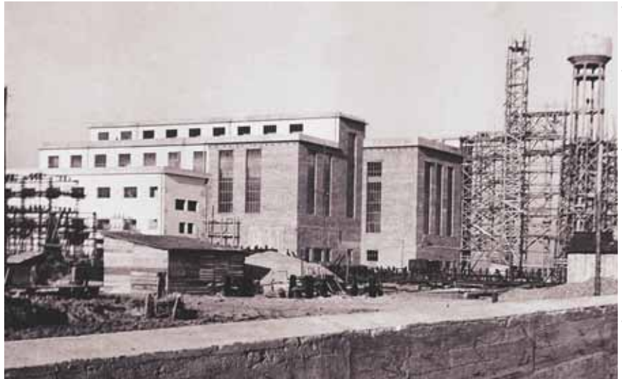
Stalowa Wola. Budowa elektrowni.
