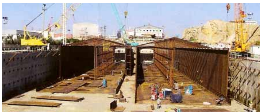
Fot. 3. Prefabrykacja elementów w suchym doku
