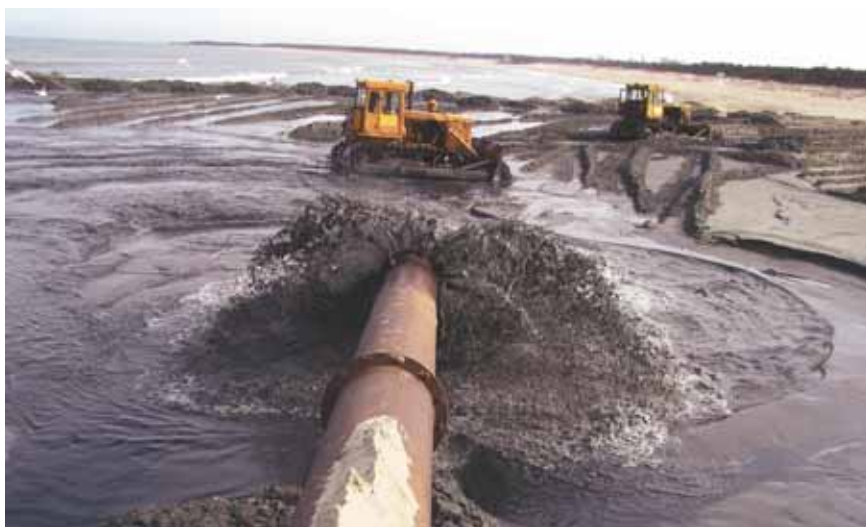
Fot. Prace refulacyjne (zbiory Hochtief)
