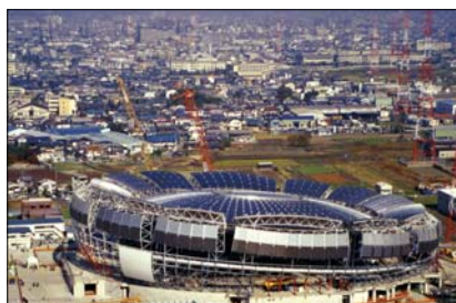
Fot. 37a. Pierwszy etap montażu dachu nad krytą halą Namihaja Dome, Japonia
