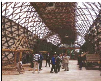
Fot. 24. Konstrukcja hali wystawowej skansenu-muzeum; podwójne, krzyżujące się pręty drewniane, usztywnione cięgnami stalowymi, Anglia
