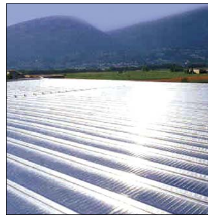
Fot. 9a. Dach płaski wykonany z blach fałdowych firmy River Clack
