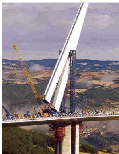
Fot. 35. Montaż pylonu pomostu wiaduktu Millau, Francja
