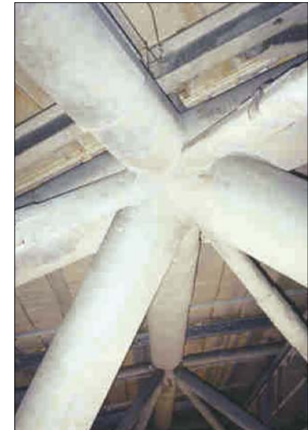
Fot. 10. Szczegóły wnętrza dachu hali wielofunkcyjnej Indoor Stadium w Singapurze – widoczne węzły spawane
