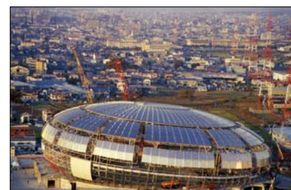
Fot. 37b. Dach nad krytą halą Namihaja Dome, Japonia, po podniesieniu – widoczne linie przegubów
