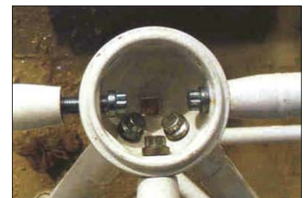
Fot. 11. Widok węzła (bez przykrywki) systemu Spherobat – S. du Chateau
