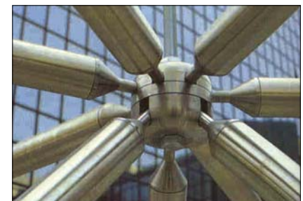
Fot. 12. Węzeł systemu Vestrut – możliwe ustawienie krzyżulców pod zmiennym kątem
