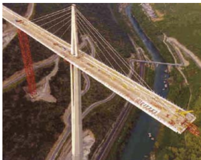
Fot. 34. Montaż pomostu wiaduktu Millau, Francja
