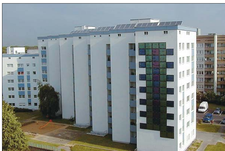
Fot. Instalacja solarna termiczna oraz ogniwa fotowoltaiczne na budynkach spółdzielni ASG przy Georg-Kaiser-Strasse
