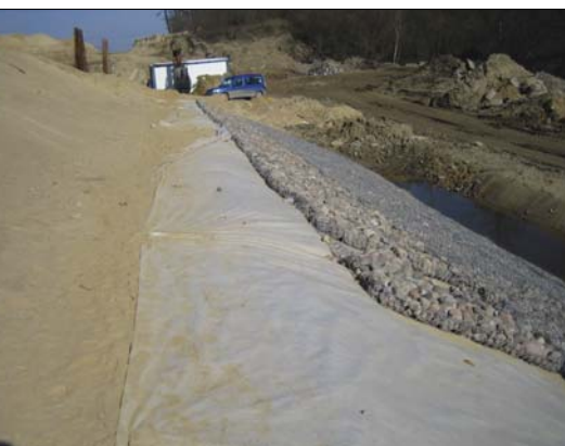
Fot. 2. Separacyjna funkcja geowłókniny o trudnym uzasadnieniu zastosowania; fot. autor
