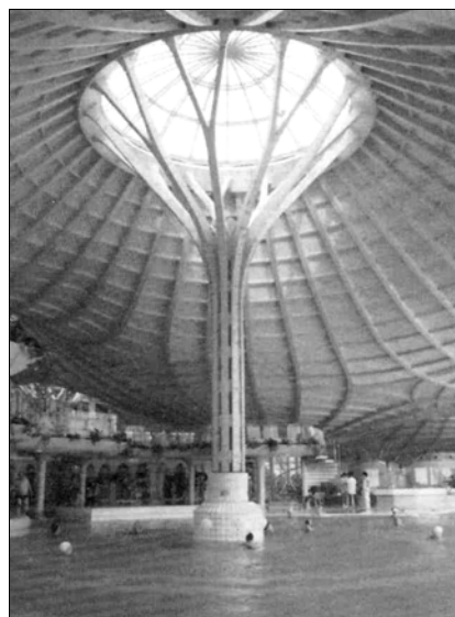
Fot. 30. Podpora wielopunktowa powłoki drewnianej – wszystko drewno klejone
