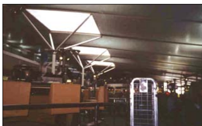
Fot. 29. Podpory wielopunktowe (koźłowe) na lotnisku Hithrow w Londynie
