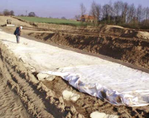
Fot. 1. Geowłóknina w poddrożu lub podtorzu, na niwelecie budowli ziemnej, w podłożu nawierzchni drogowej lub szynowej, w układzie planarnym [8]
