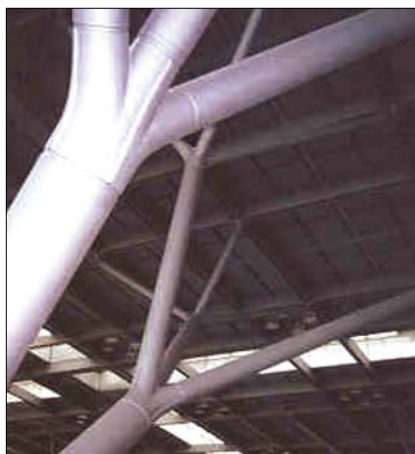
Fot. 27. Podpory wielopunktowe (arboralne) na dworcu lotniczym w Stuttgarcie
