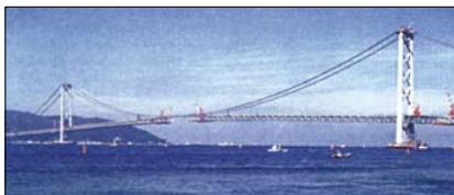
Fot. 33. Most Akashi-Kaikyo, montaż pomostu, Japonia, 1996
