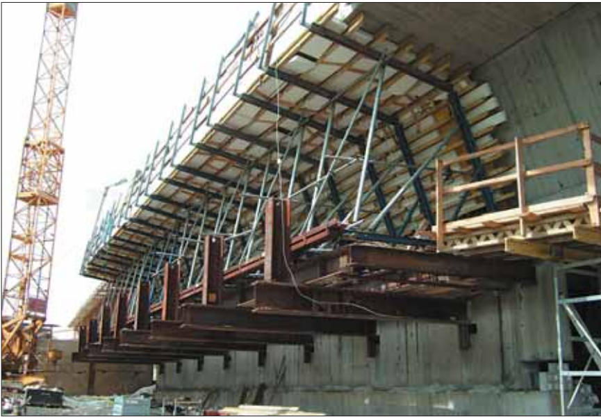
Fot. 1. Szalunek zewnętrzny
