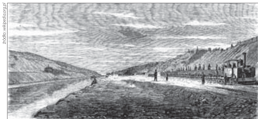
Budowa Kanału Sueskiego
