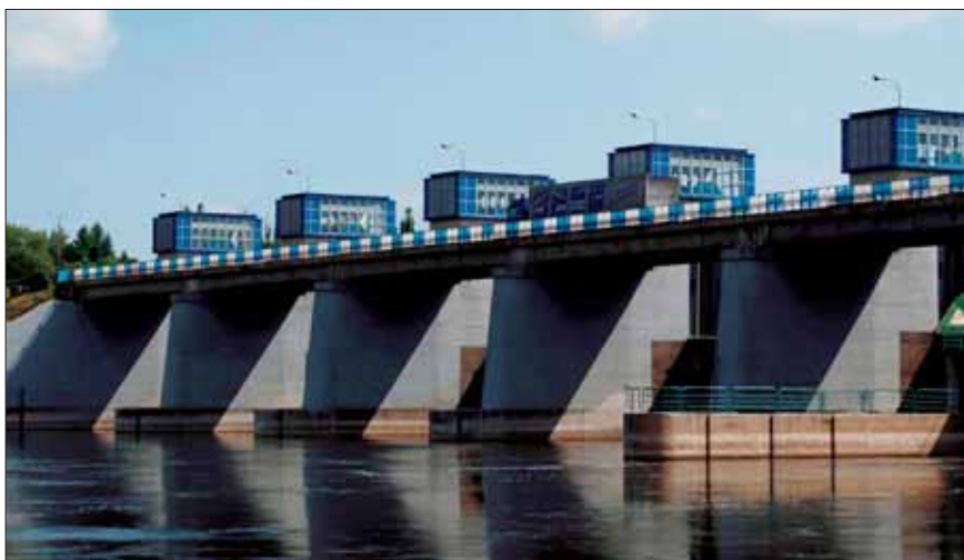
Stożek wodny Dębe na Narwi – fragment zapory ziemnej, jaz i elektrownia wodna (fot. W. Kryński)
