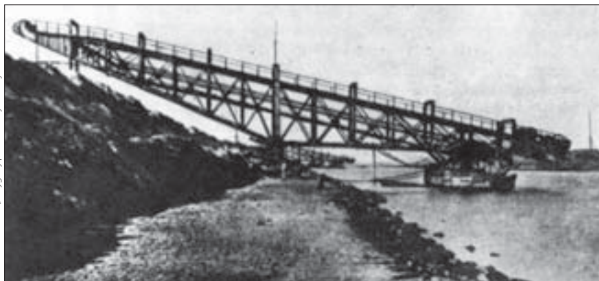
Mechaniczny transporter ziemi i mułu zastosowany przy budowie Kanału Sueskiego
