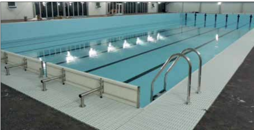
Fot. 8. Gotowa niecka basenu w modułowej konstrukcji Blue Spring napelniana wodą (materiały firmy SPM Swimming Pools)
