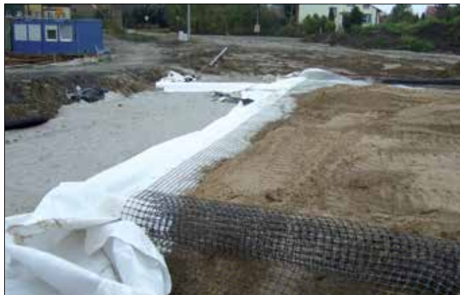
Fot. 8. Wzmocnienie podłoża konstrukcji drogowej z dodatkowym pasmem geowłókniny jako separatora pod geosiatką i obsypką z piasku/pospółki
