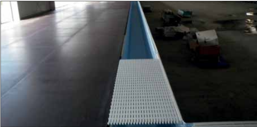
Fot. 7. Montaż folii i rusztu w modułowej konstrukcji Blue Spring (materiały firmy SPM Swimming Pools)
