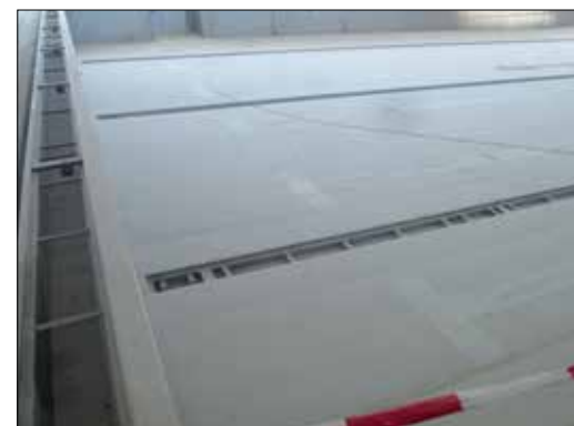
Fot. 9. Konstrukcja niecki basenu rekreacyjnego ze stali nierdzewnej
