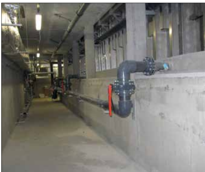
Fot. 10. Widok podbasenia, konstrukcja niecki basenu ze stali nierdzewnej
