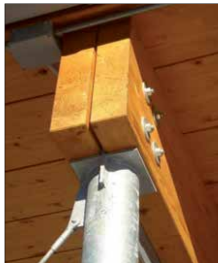
Fot. 1. Węzeł podporowy przekrycia z blachą węzłową (Pejo-Włochy)
