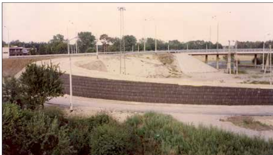
Fot. 4. Pierwsza konstrukcja muru oporowego z gruntu zbrojonego geotkaninami – węzeł Struga k. Warszawy
