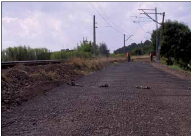
Fot. 7. Wzmocnienie warstwy podtorzowej torowiska kolejowego
