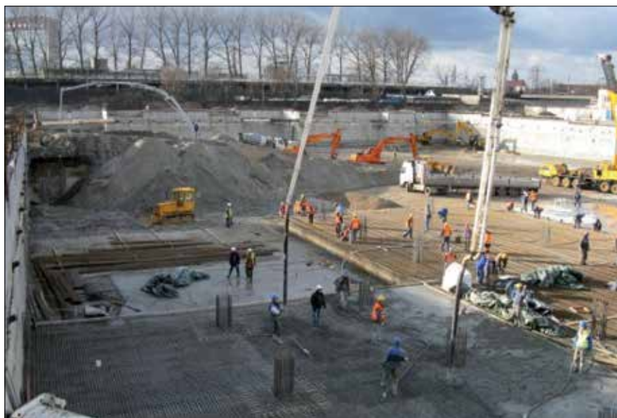
Fot. 2. Prace hydroizolacyjne z użyciem Hydrostopu
