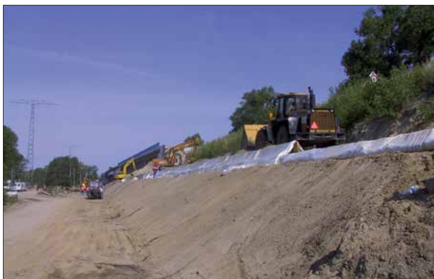
Fot. 5. Zbrojenie wysokich skarp na dojazdach do przeprawy przez rz. Odrę w Szczecinie
