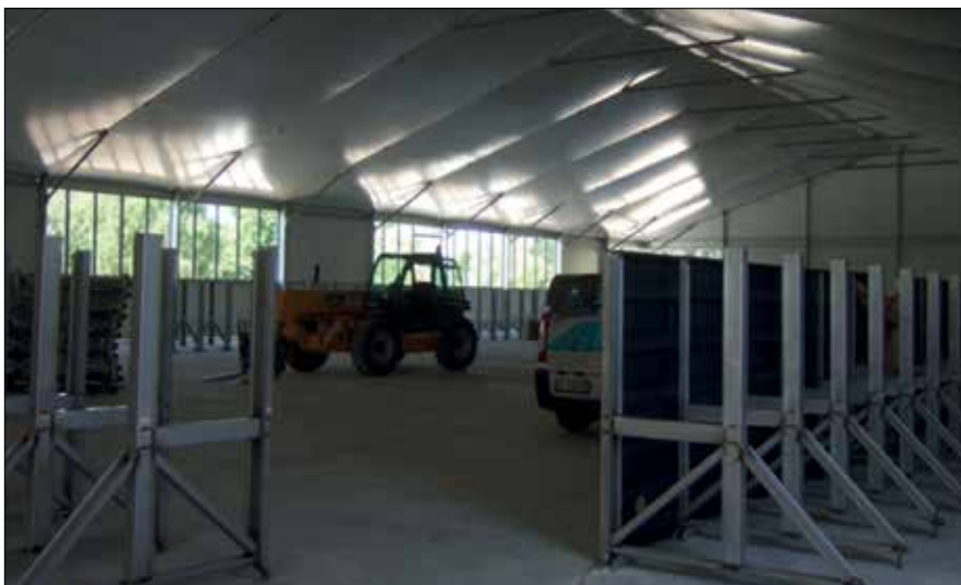
Fot. 6. Montaż modułowej konstrukcji Blue Spring w hali na wylewce betonowej (materiały firmy SPM Swimming Pools)
