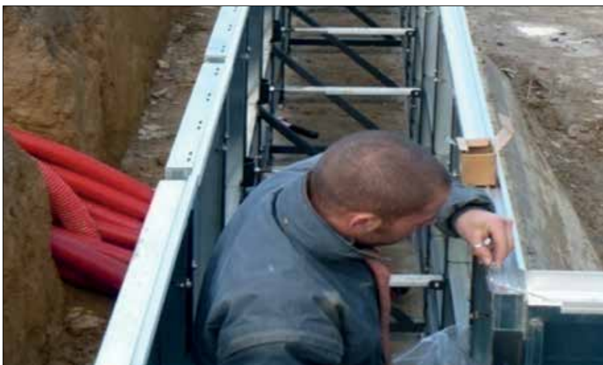
Fot. 5. Montaż modułowej konstrukcji Blue Spring w gruncie (materiały firmy SPM Swimming Pools)
