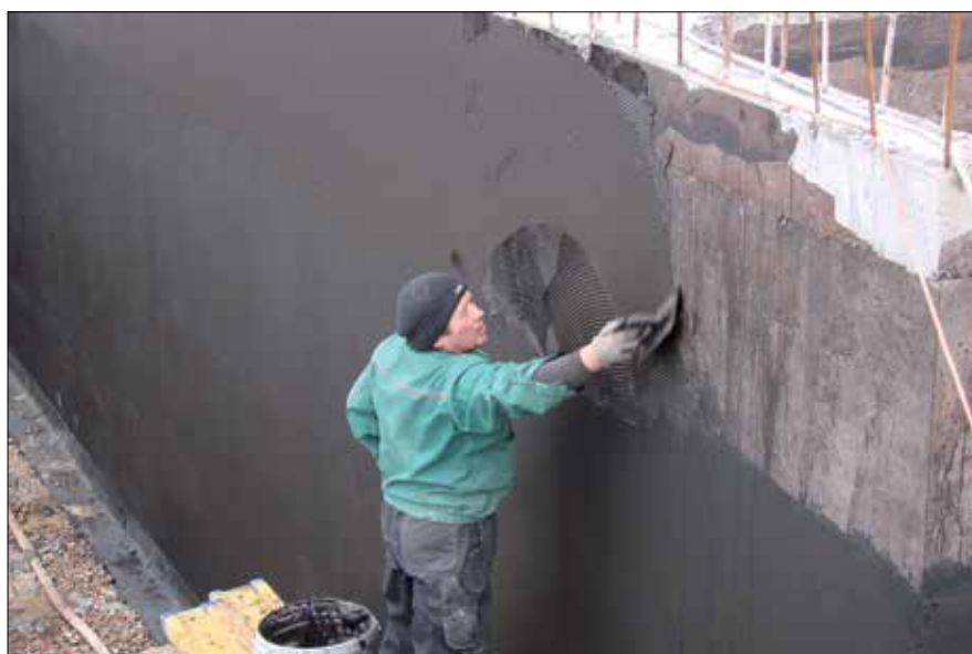
Fot. 2. Nakładanie masy KMB w warunkach obniżonej temperatury [5]
