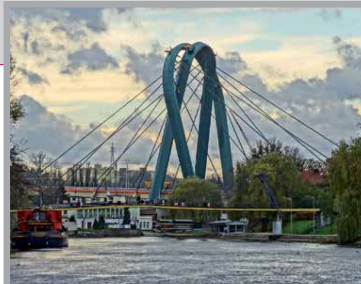
Pylon Trasy Uniwersyteckiej nad Brdą w Bydgoszczy (fot. Pit1233, Wikipedia)
