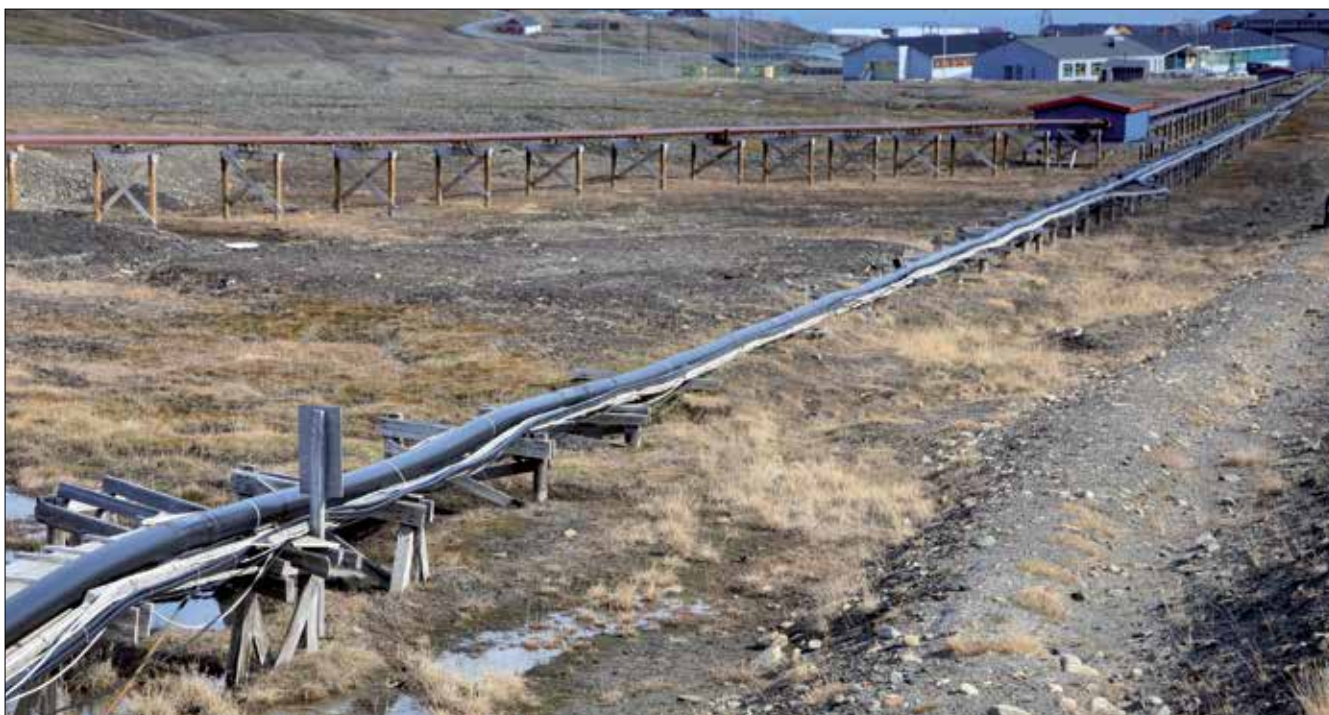
Fot. 3. Longyearbyen, linie kablowe prowadzone w rurach ochronnych
