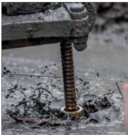
Wykonywanie mikropali żerdzią systemu samowierzącego
