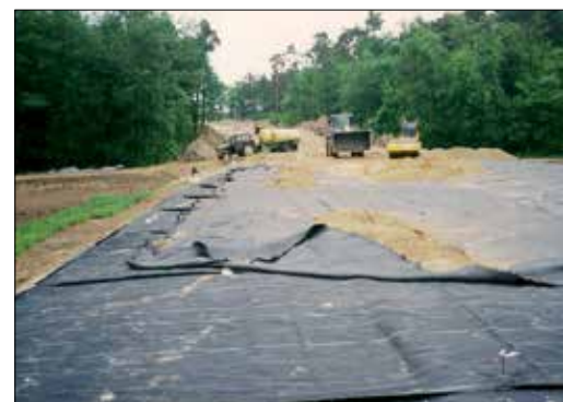
Fot. 3. Posadowienie na bagnie wysokich nasypów z wykorzystaniem wysokowytrzymałego zbrojenia geotkaninami na obejściu wsi Ognica
