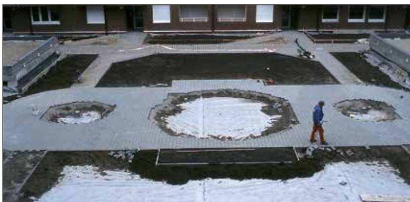
Fot. 8 | Wykonywanie nawierzchni na stropodachu garaży
