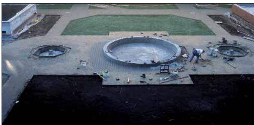
Fot. 9 | Żelbetowa konstrukcja piaskownicy posadowiona jest powyżej warstwy drenażowej
