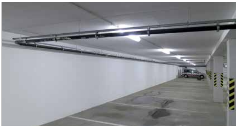
Fot. 5 | Kolektory prowadzone bezspadkowo mają tendencję do zapychania się błotem z nawierzchni komunikacyjnych
