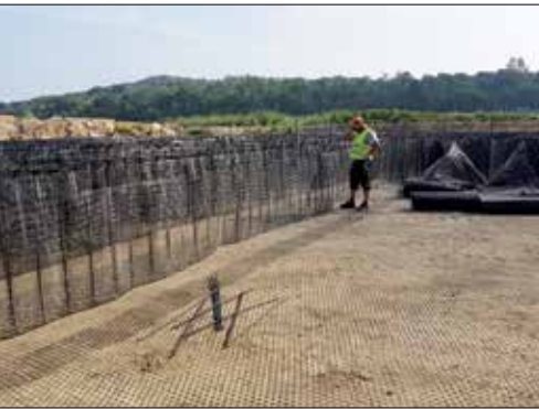
Fot. 1 | Etapy montażu materaca TensarTech® Stratum®
