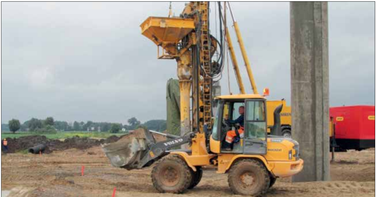
Fot. 5 | Platforma robocza na budowie liniowej (fot. P. Rychlewski)
