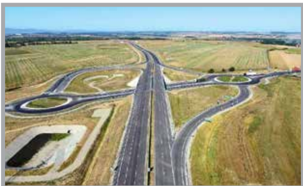
Budowa obwodnicy, luty 2017 r. (fot. GDDKiA, Oddział Opole)
