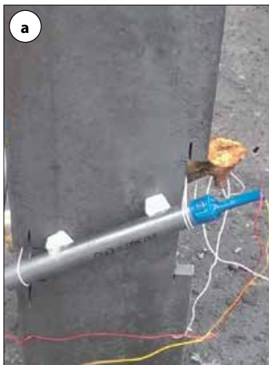
Fot. 4 | a) Uzbrojony słup konstrukcji, b) efekt cięcia
