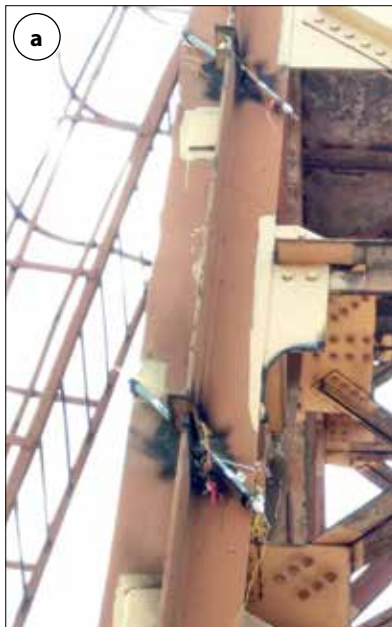
Fot. 3 | a) Uzbrojony słup konstrukcji, b) efekt cięcia
