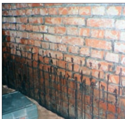
Fot. 1. Otwory wywiercone w cegle.
