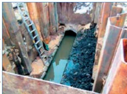
Fot. 1. Miejsca pracy, w których występuje ekstremalne zagrożenie porażeniowe a) głęboki wykop zabezpieczony metalową konstrukcją; b) kanał.
