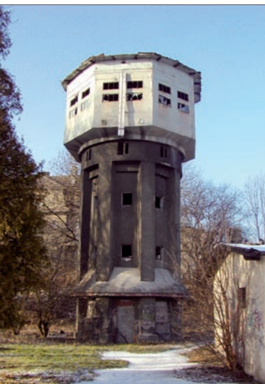
Fot 1. Wodzisław Śląski – wieża ciśnień
