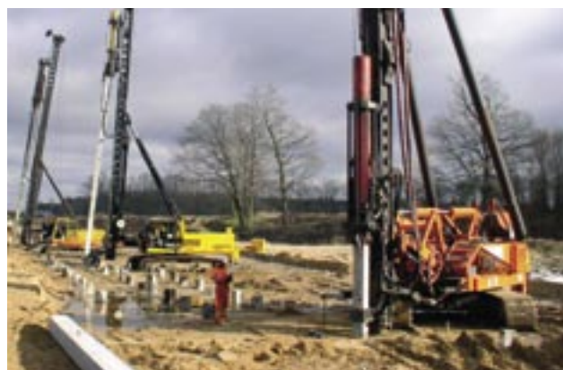
Fot. 3. Palownice w trakcie wykonywania wzmocnienia podłoża pod nasyp autostrady
