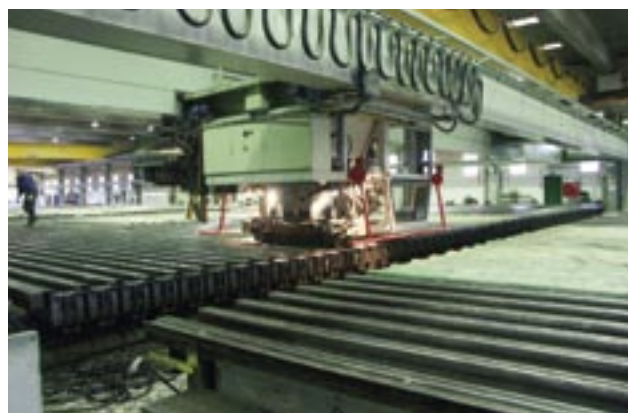
Fot. 2. Wytwórnia pali prefabrykowanych
