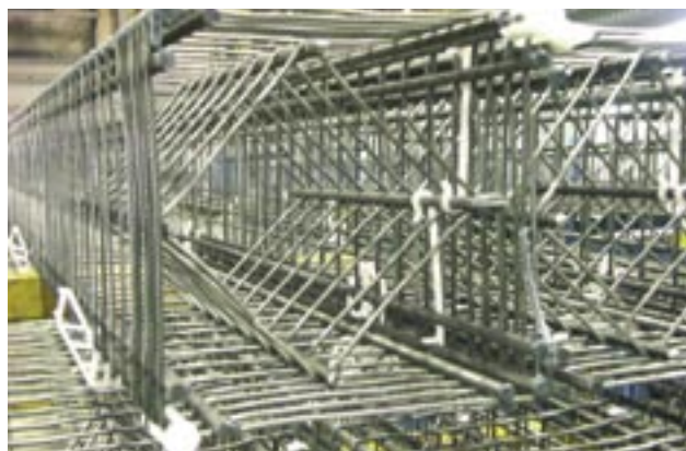
Fot. 1. Przykładowe zbrojenie pala
