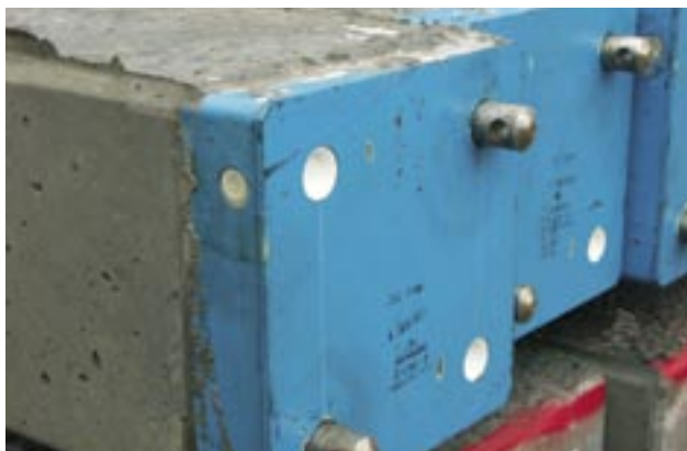
Fot. 4. Typowa złączka pala prefabrykowanego
