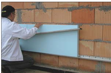
Fot. 2 | Ocieplanie płytami XPS (archiwum firmy Weber)
