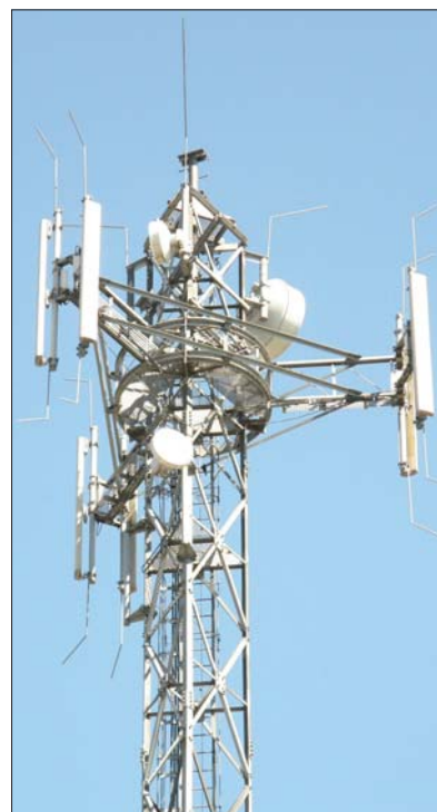
Fot. 5 | Stalowa wieża kratowa typu Dawidowicz
