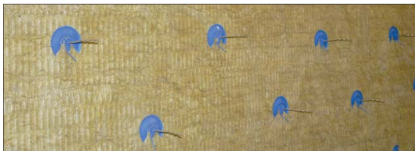
Fot. 3 | Ocieplanie wełną mineralną
