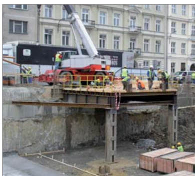
Fot. 5 | Platforma stalowa do wywozu urobku – Wolf Marszałkowska
