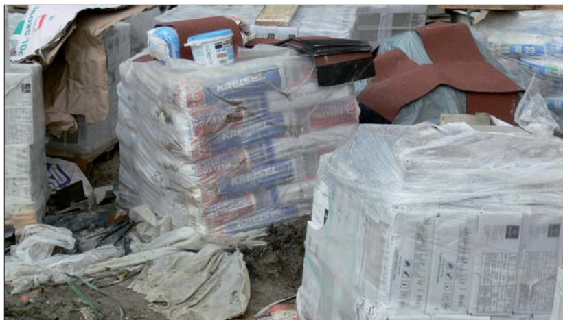
Fot. 3 | Przykład nieodpowiedniego składowania materiałów budowlanych, w tym tynków
