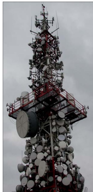
Fot. 3 | Wieża telekomunikacyjna na dachu hotelu Marriott w Warszawie
