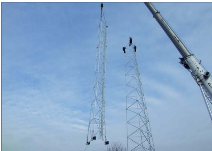
Fot. 1 | Montaż pionowy wieży typu Eitel
