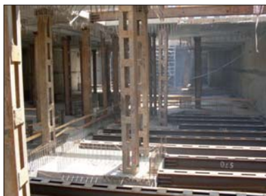
Fot. 2 | Słupy tymczasowe i rozporzy przed demontażem – Wolf Bracka
