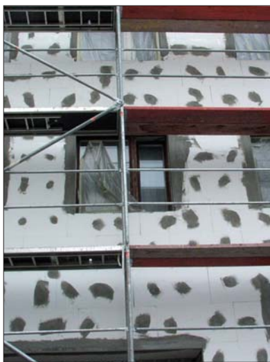
Fot. 1 | Ocieplanie płytami ze styropianu (fot. K. Wiśniewska)
