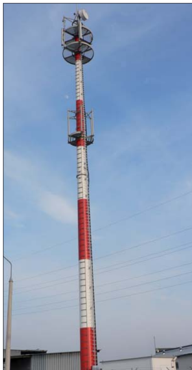
Fot. 4 | Wieża strunobetonowa z oznakowaniem przeszkodowym
