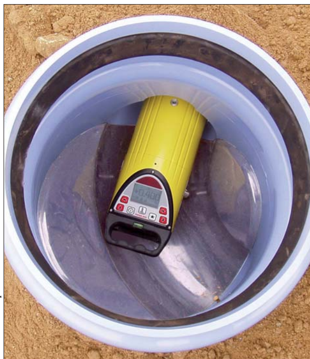
Laser liniowy wstawiony w studziencie kierunkowej
