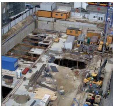
Fot. 3 | Widok na strop -1 – Wolf Bracka
