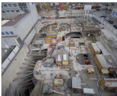
Fot. 6 | Widok na plac budowy – Wolf Marszałkowska
