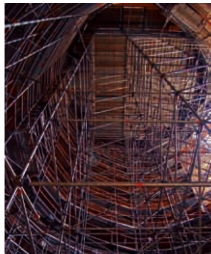
Fot. 3. Widok konstrukcji rusztowania wewnątrz absorbera
