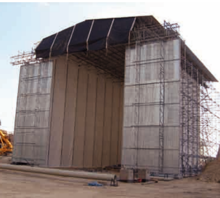
Fot. 2. Widok hali od strony bramy rozsuwanej
