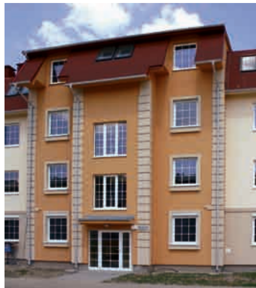
Fot. Bonie na elewacjach współczesnych budynków mieszkalnych
