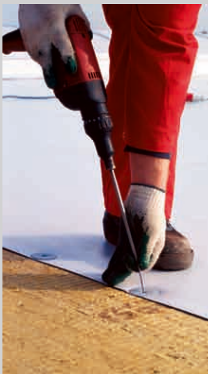
Mocowanie łącznikami folii PVC
