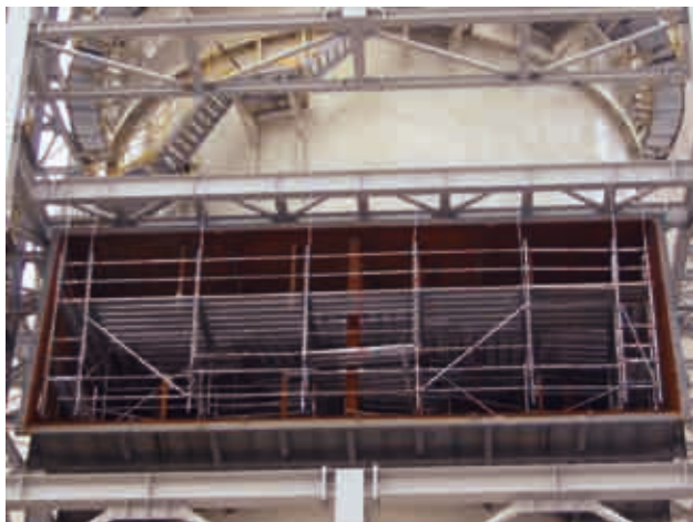
Fot. 4. Podwieszenie rusztowania na łańcuchach, przy wlocie spalin na wysokości 24 m
