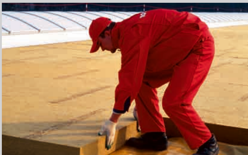
Układanie płyt ze skalnej wełny Rockwool na blasze trapezowej
