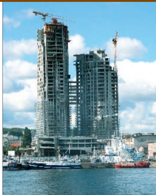
Sea Towers, kompleks mieszkaniowo-usługowy w Gdyni przy skwerze Kościuszki, widziany od strony morza Fot. A. Filipowski
