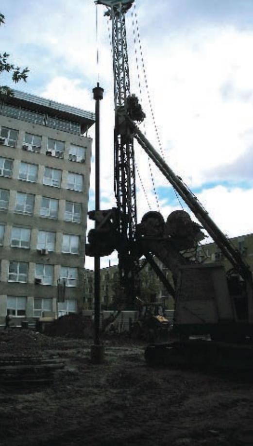
Fot. 4. Prace palowe na sąsiedniej działce
