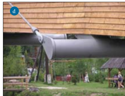
Fot. 3. Szczegóły konstrukcyjne: a) widok na podparcie pomostu na pylonie, b) łożysko, c) i d) zakotwienia want w przyczółku i poprzecznikach przęsłowych
