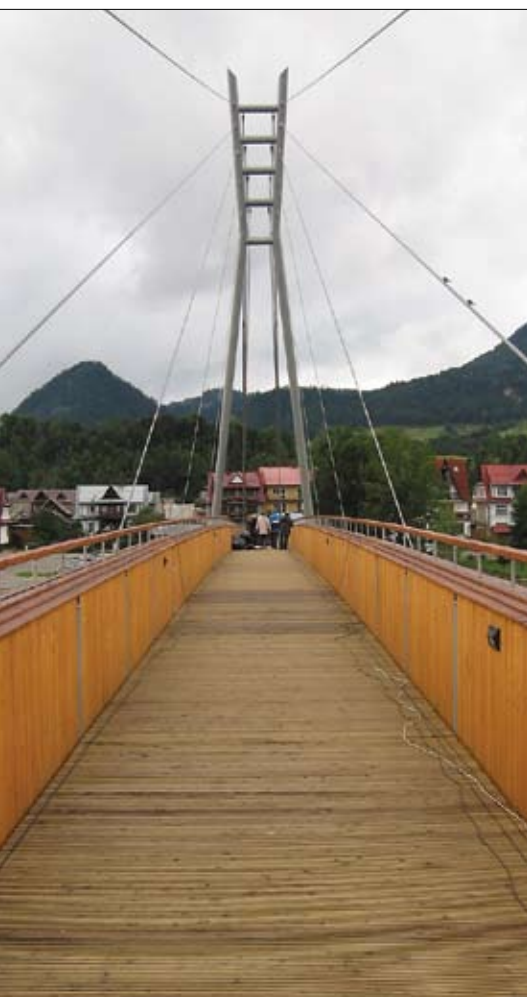
Fot. 4. Ogólny widok pomostu i detali
