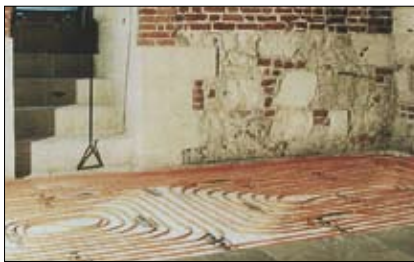
Rys. 4. Zamek Królewski na Wawelu – w trakcie prac
