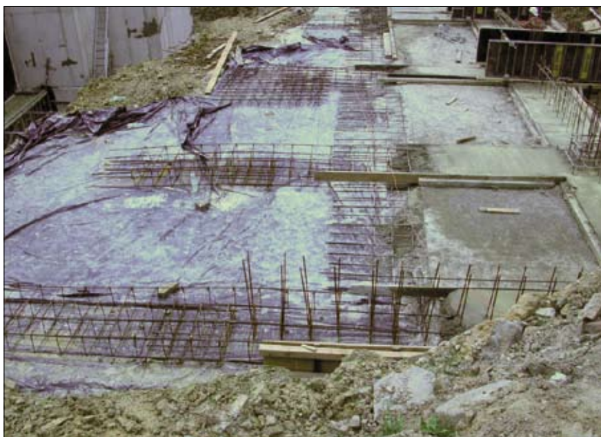
Fot. 1. Konstrukcja ścian i słupów części usługowej budynku
