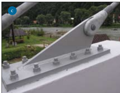
Fot. 3. Szczegóły konstrukcyjne: a) widok na podparcie pomostu na pylonie, b) łożysko, c) i d) zakotwienia want w przyczółku i poprzecznikach przęsłowych
