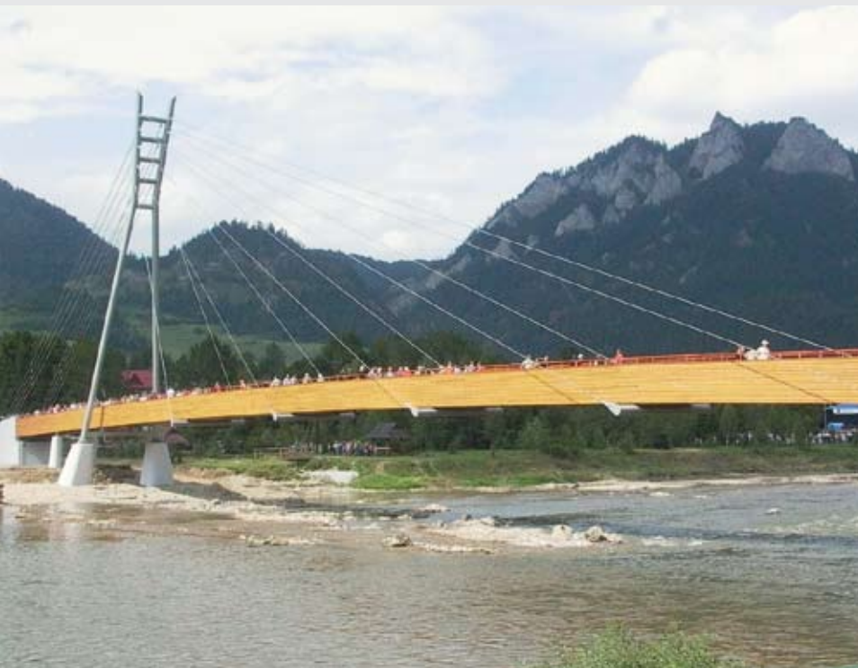
Fot. 2. Widok gotowego obiektu
