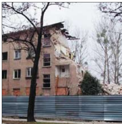
Fot. 2, 3. Roboty rozbiórkowe
