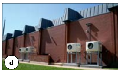
Rys. 5 | Pośredni wymiennik wyparny z obiegiem Maisotsenki: a) schemat wymiennika (1 – powietrze dostarczane do użytkowników systemu, 2 i 3 – powietrze pomocnicze odpowiednio w suchym i mokrym kanale); b) wygląd zewnętrzny wymiennika; c) przykład zastosowania: urządzenie typu rooftop wyposażone w wymiennik z M-obiegiem; d) przykład wykorzystania autonomicznych jednostek z M-obiegiem – budynek kina Denver; e) i f) autonomiczne jednostki z M-obiegiem jako źródło chłodu dla serwerowni Centrum Monitorowania Pokrywy Śnieżnej i Lodowej NASA o mocy 120 kW, Boulder, Colorado, USA
