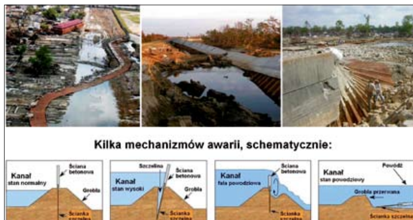
Rys. 1 | Typowe awarie grobli kanałów żeglugowych. Na szerokich odcinkach woda wtargnęła do miasta. W miejscach przerwanym grobli fala powodziowa (na fot. już po cofnięciu się) zmyła zabudowania do samych fundamentów. Nieco dalej niektóre budynki, choć jeszcze stoją, nadają się tylko do rozbiórki. Wzniesiona na szczycie grobli betonowa ściana piętrząca leży zniszczona w dużych odległościach od swego miejsca. Ściana ta, wieńcząca ściankę szczelną z grodzic stalowych, stanowiła przed Katrina rozwiązanie typowe. Kilka mechanizmów awarii grobli z taką ścianką pokazano schematycznie w dolnej części ilustracji.
