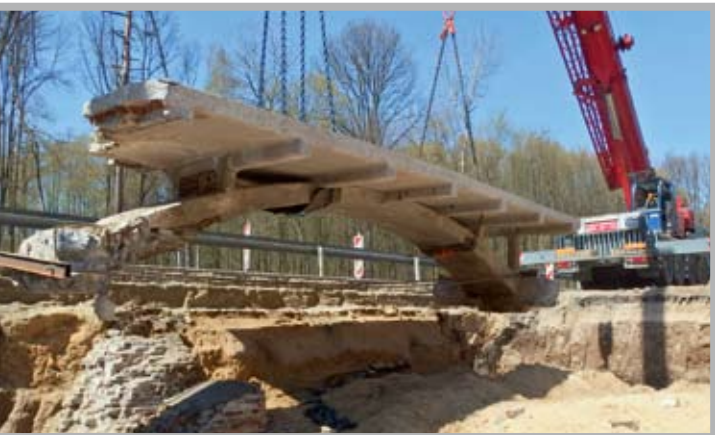
Fot. Załadunek elementów obiektu
