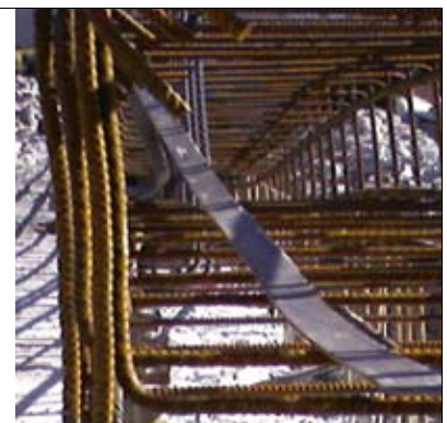
Rys. 1 | Zalecane wykonanie uziomu fundamentowego z wykorzystaniem taśmy stalowej (archiwum firmy RST)
