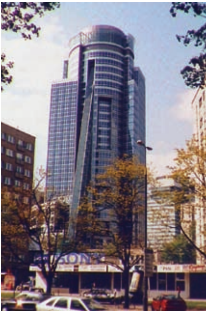
Biurowiec TP SA W Warszawie. Ściany szczelinowe reprofilowane i uszczelniane Hydrostopem
