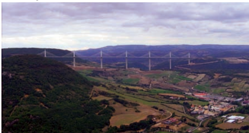
Fot. 4. Grand Viadue de Millau, architektura Norman Foster, konstrukcja Michel Virlogeux
