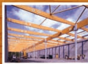
Rys. 8. Dźwigar gięty o stałym lub zmiennym przekroju (typu „hokej”), tworzący dach dwuspadowy z zachowaniem łukowej formy wewnątrz budynku. Maksymalny spadek dachu praktycznie bez ograniczeń, dzięki układowi trójprzegubowemu złożonemu z dwóch elementów możliwe do uzyskania olbrzymie rozpiętości.
