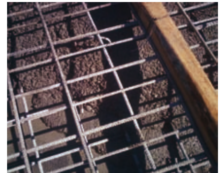
Fot. 1. Posypka uszczelniająca zalewana betonem
