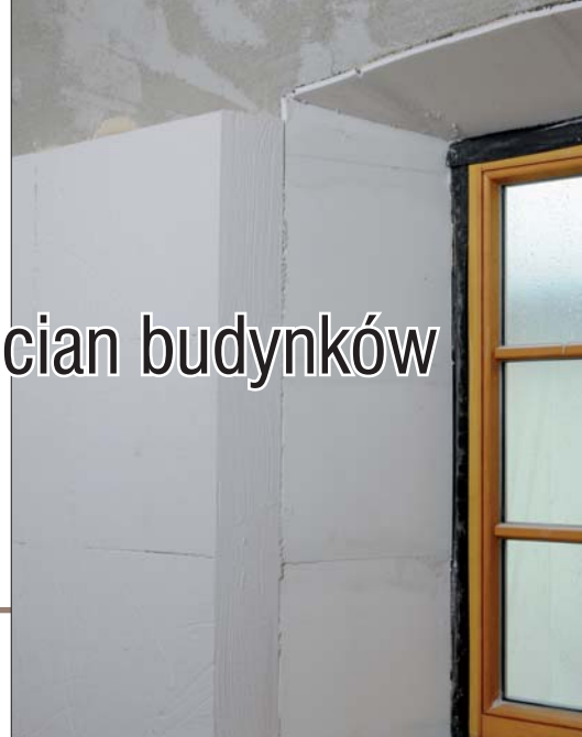
Fot. 3 Płyty Aevero stanowią doskonale uzupełnienie ocieplenia StoTherm In Comfort w miejscach, w których nie mieści się etatowa płyta systemu, na przykład w ościeżach otworów lub za grzejnikami
