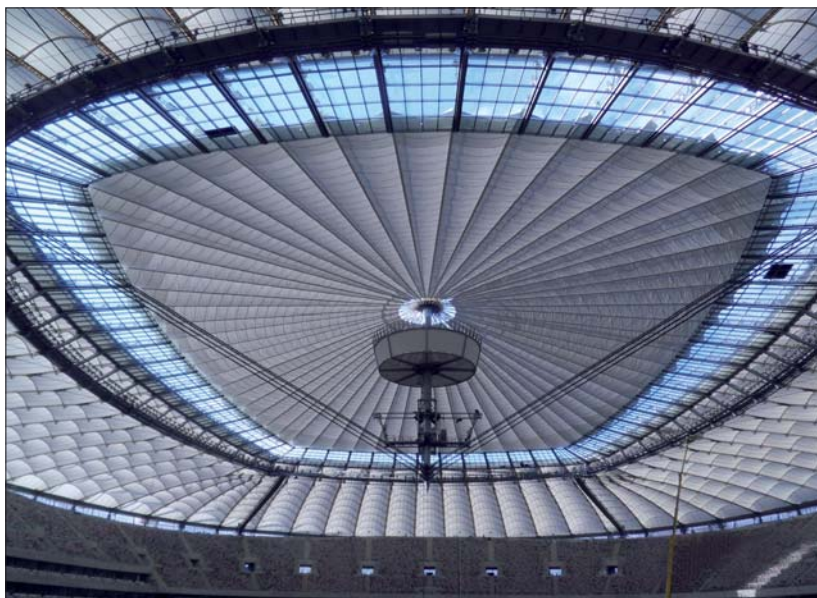
Fot. 2 | Dach wewnętrzny zamknięty
