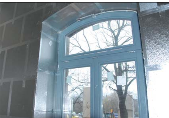
Fot. 1 System StoTherm In Aquaresisist umożliwia ocieplenie powierzchni opisanych na łuku lub powierzchni odbiegających od płaszczyzny
