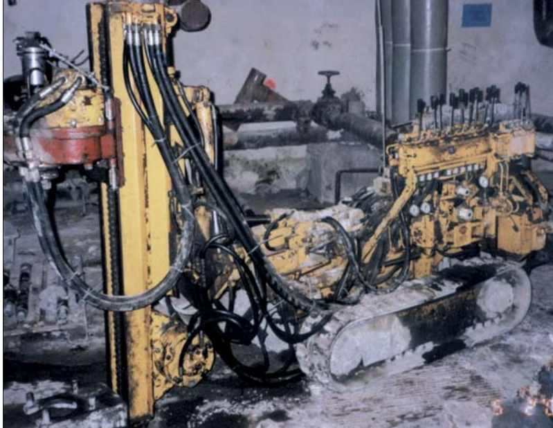
Fot. 3 | Maszyna wykonująca kolumny w pomieszczeniu piwnicy
