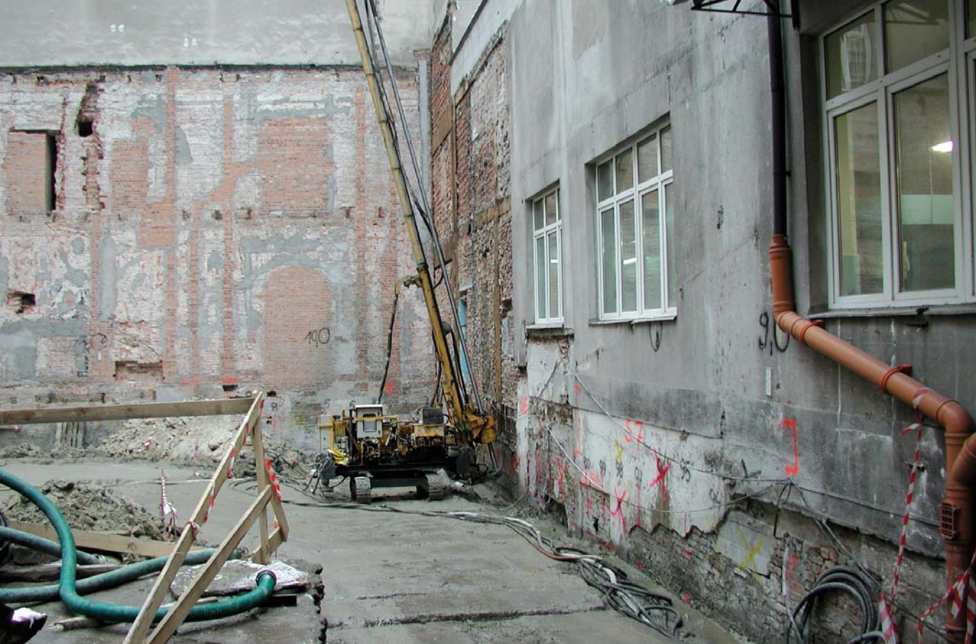
Fot. 5 | Wykonywanie palisady z kolumn jet grouting w czasie remontu Hotelu Polonia w Warszawie
