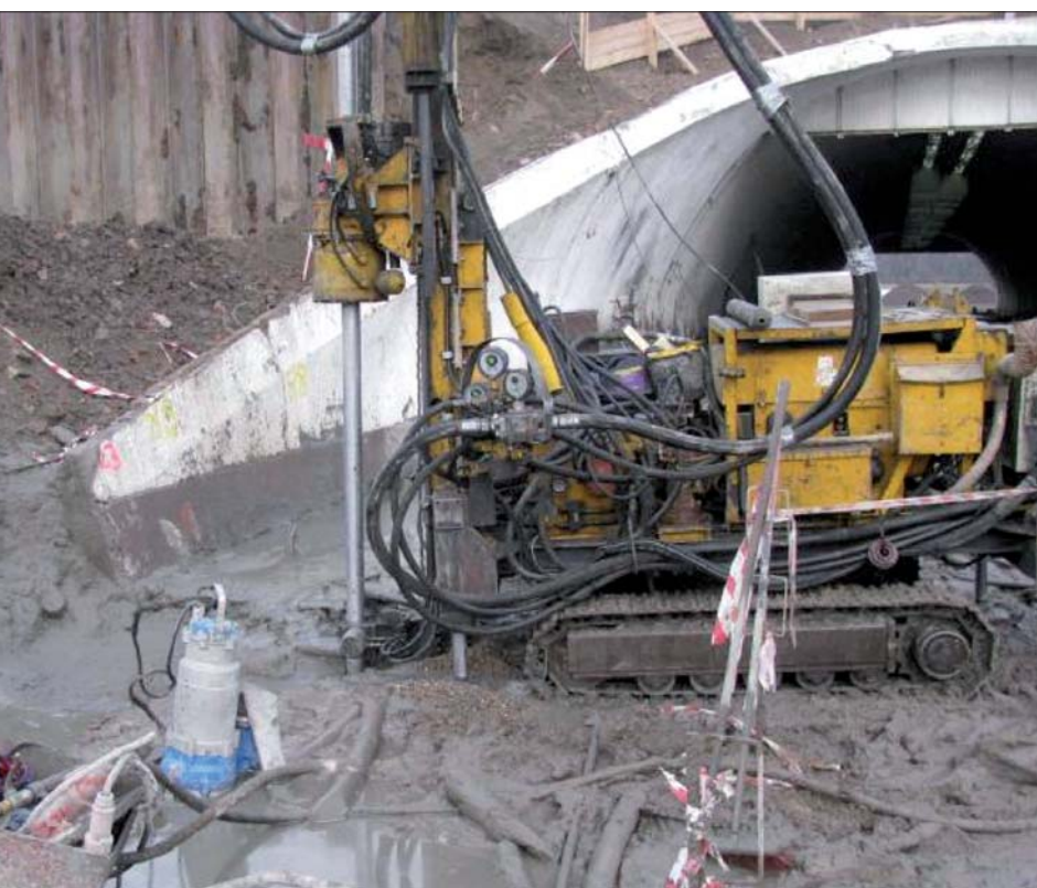
Fot. 6 | Kolumny jet grouting w tunelu wjazdowym na stadion w czasie budowy Stadionu Narodowego w Warszawie
