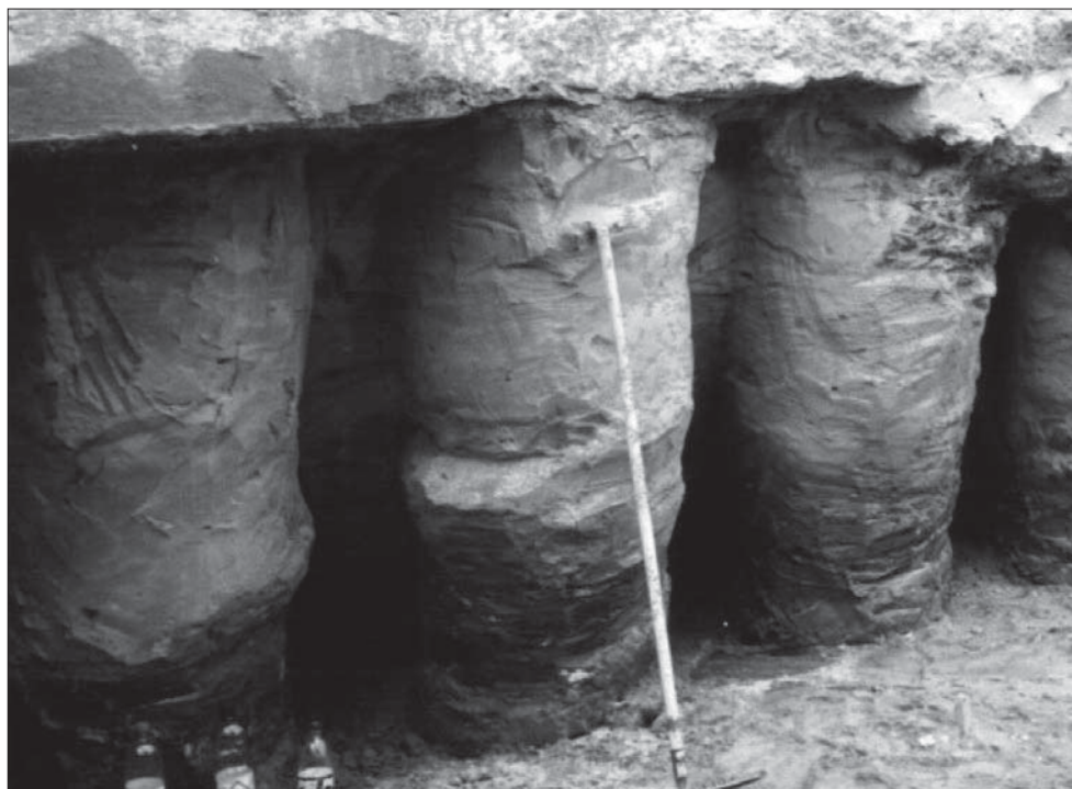
Fot. 1 | Fundamenty budynku oparte na kolumnach jet grouting w czasie wykonywania głębszego wykopu
