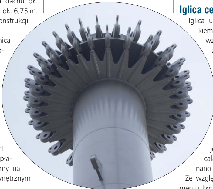
Fot. 3 | Wzłaz kotwiący liny dachu wewnętrznego
