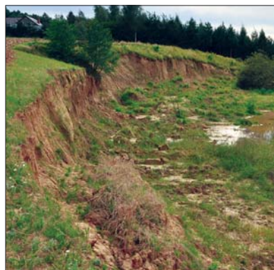
Fot. 3 | Początek osuwiska – skarpa o wysokości do 14 m
