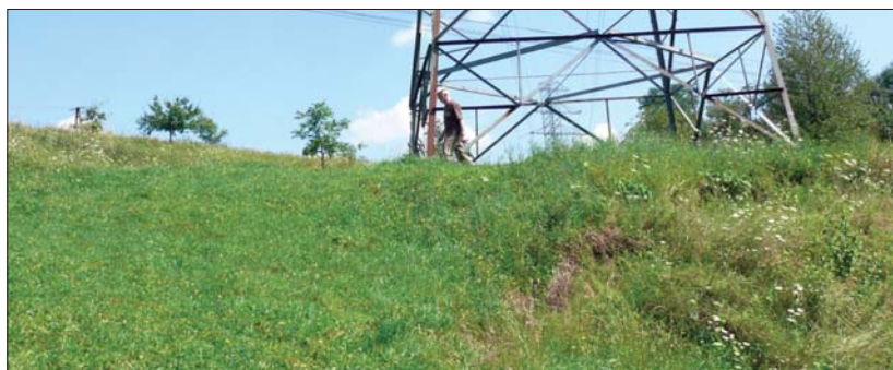
Fot. 4 | Słup z początkami zjawisk osuwiskowych
