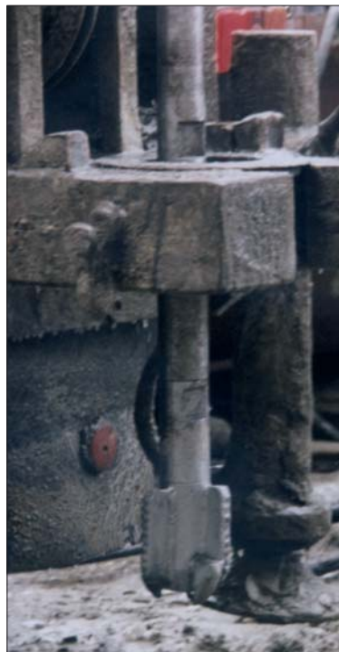
Fot. 4 | Końcówka żerdzi iniekcyjnej
