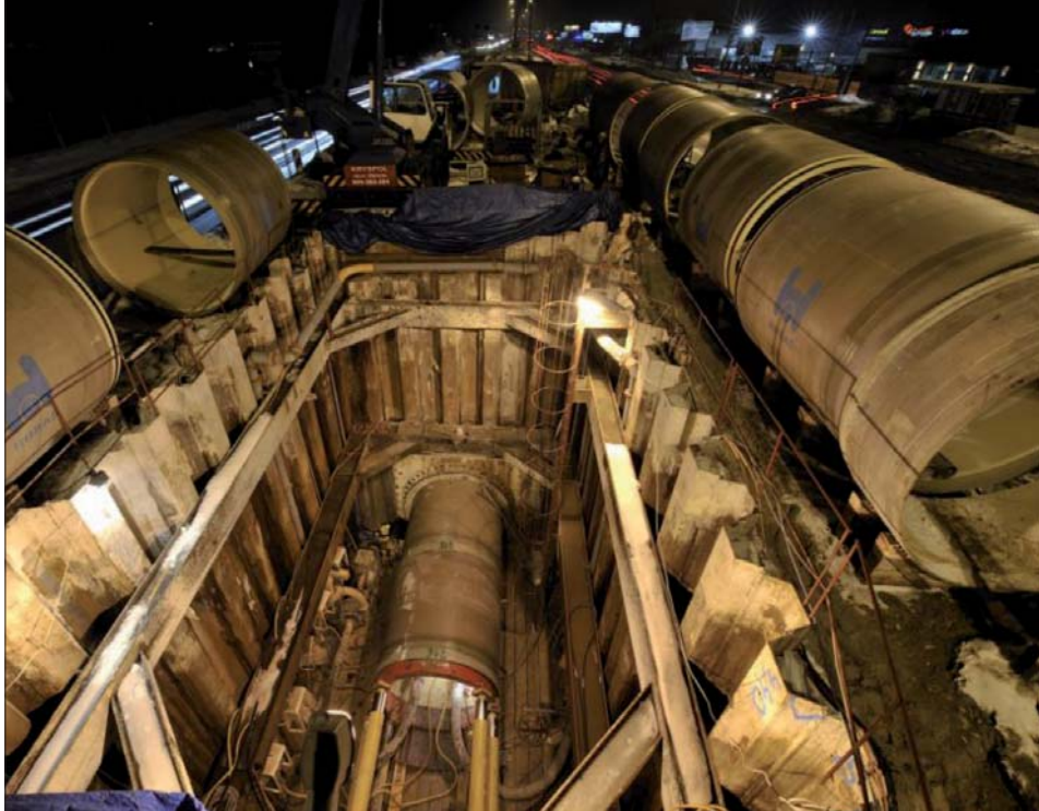
Fot. 1 | Komora robocza mikrotunelu zlokalizowana w pasie rozdzielu jezdni
