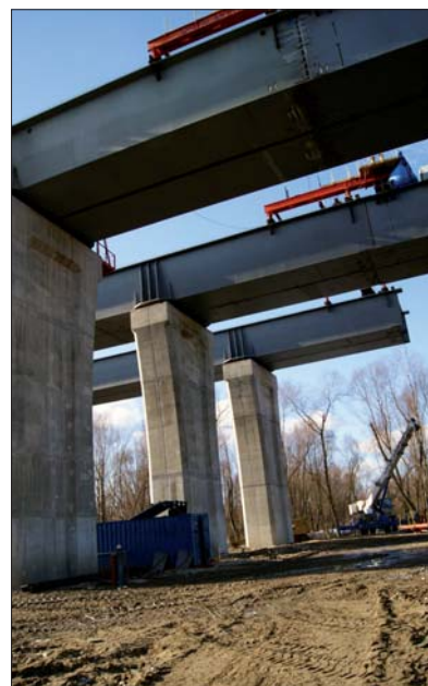
Fot. 1 | Podpory lewobrzeżnej (białołęckiej) części mostu
