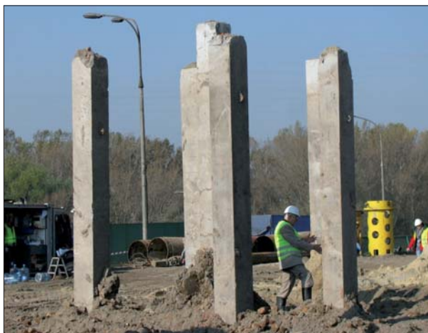
Fot. 3 | Odkopane pale testowe na budowie Stadionu Narodowego w Warszawie
