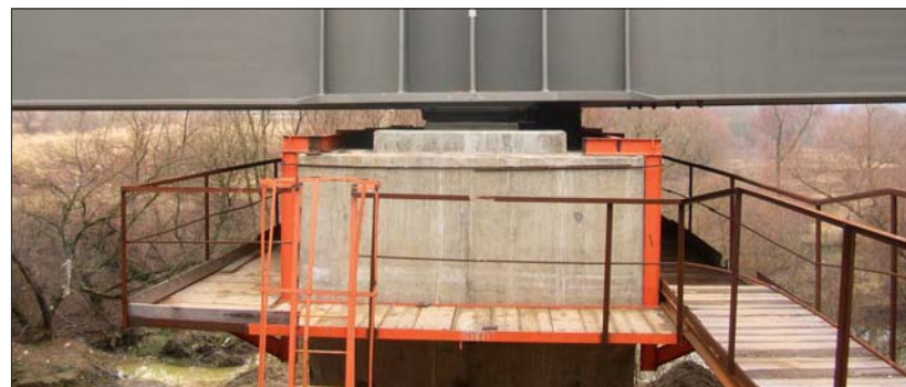
Fot. 2 | Podpory lewoobrzeżnej (białańskiej) części mostu
