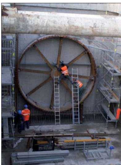
Fot. 3 | Komora robocza dla tunelu pod Wisłą
