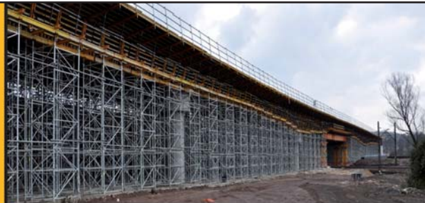
Wiadukt w ciągu DK79 w Krzeszowicach ▶
