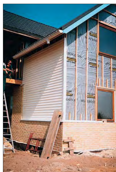
Fot. 3 | Montaż na listwach w przypadku braku dodatkowej izolacji cieplnej
