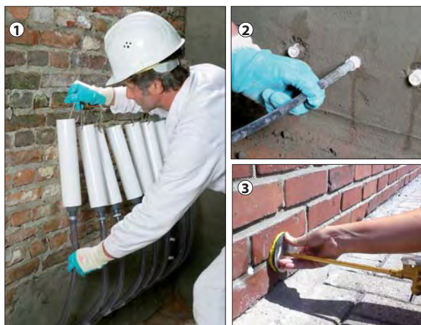
Fot. 1–3 | Zabezpieczanie fundamentów przed wilgocią: iniekcja bezciśnieniowa z zastosowaniem zasobników (1), iniekcja ciśnieniowa przez pakery z tworzywa sztucznego (2), iniekcja kremu Injektionscreme (3).
