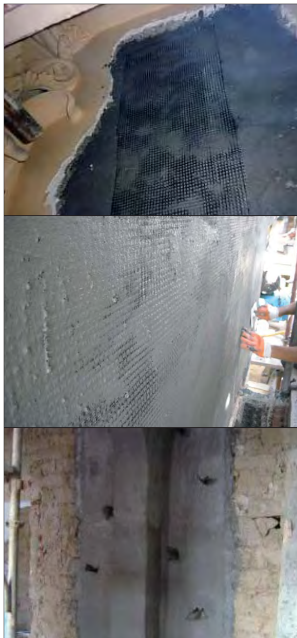
Fot. 2 | Przykład wzmacniania/naprawy wybranych fragmentów ścian (fot. Ruredil)
