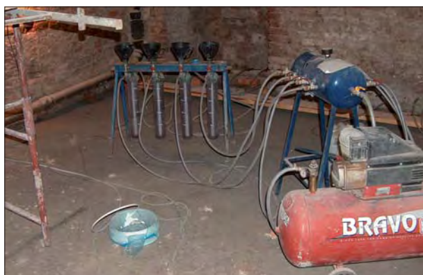
Fot. 4 | Wykonywanie iniekcji ciśnieniowej (fot. Izoserwiss)
