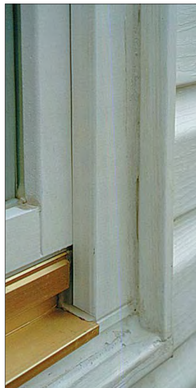
Fot. 4 | Klejenie na stykach
