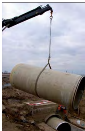
Fot. 3 | Renowacja metodą reliningu
