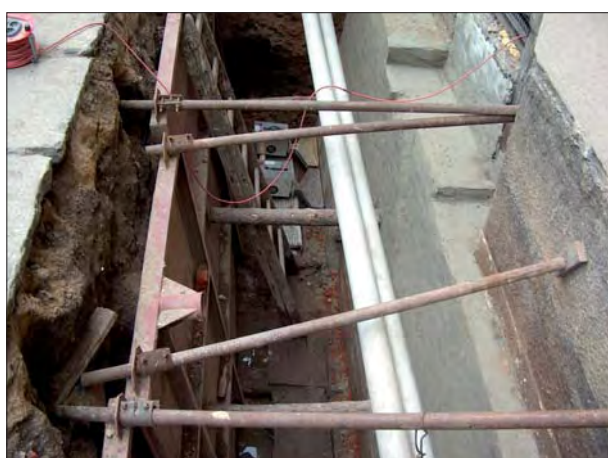
Fot. 5 | Kompleksowe odtwarzanie hydroizolacji w budynku popowodziowym – w wykopie widoczne generatory mikrofalowe osuszające strefę iniekcji (fot. Izoserwiss)
