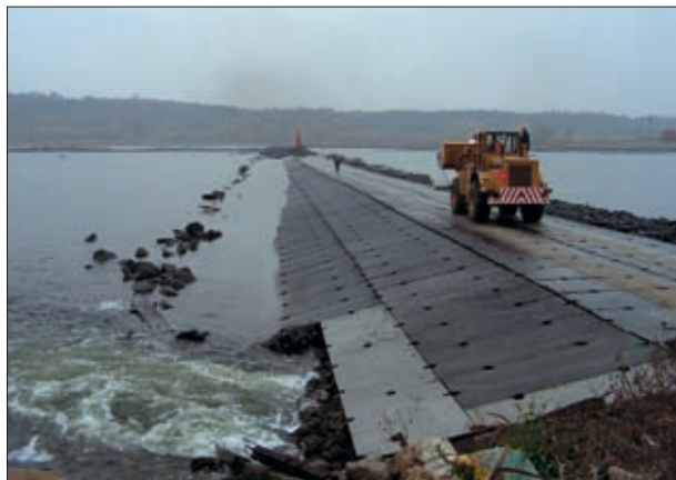
Fot. 2 | Próg podpierający stopień w trakcie modernizacji
