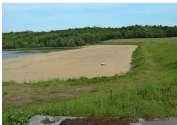
Fot. 3 | Podparcie dolnej skarpy zapory ziemnej nasypem ziemnym
