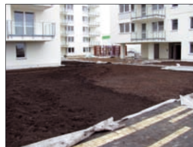
Fot. 2 | Taras uszczelniony Hydrostopem, po nałożeniu kolejnych warstw, Warszawa
