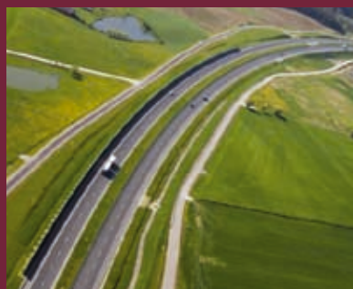
Autostrada A1 Rusocin — Nowe Marzy (Fot. MI)
