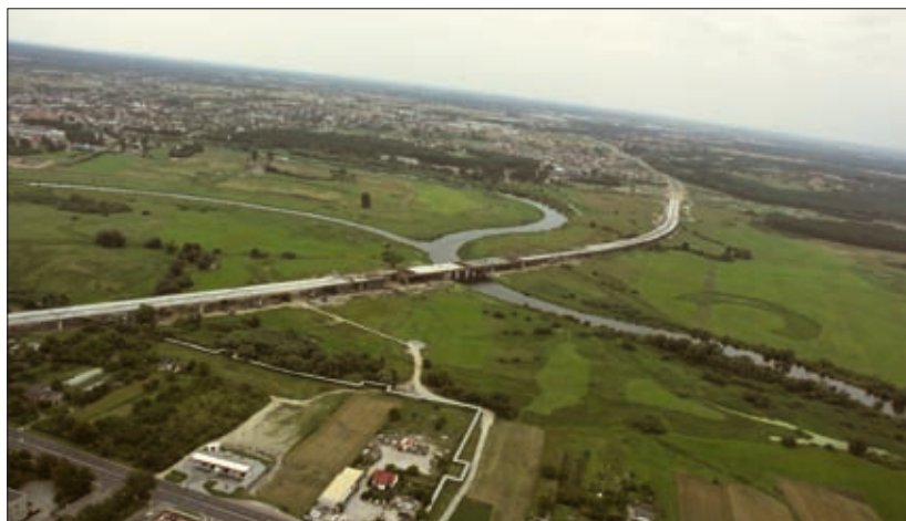
Fot. 1 | Widok mostu w końcowej fazie budowy (fot. UM w Koninie)
