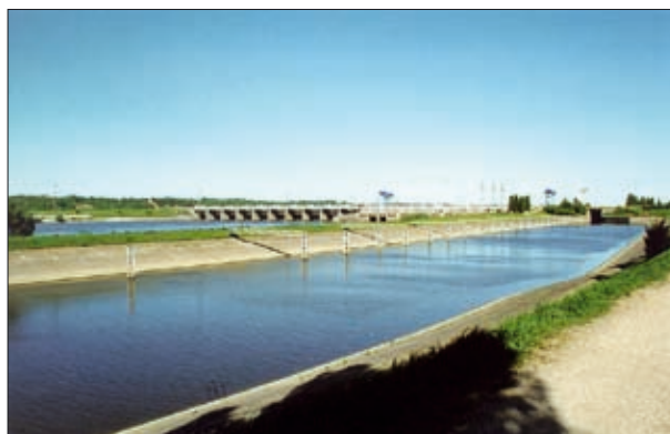
Fot. 1 | Widok stopnia od strony dolnego awanportu
