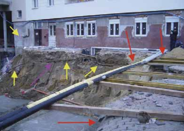
Fot. 1. Widok wykopu pod obiekt i uszkodzonego przyłącza gazowego
