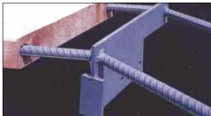
Fot. 2. Węzeł kalenicowy konstrukcji dachu drewnianego, zbrojonego
