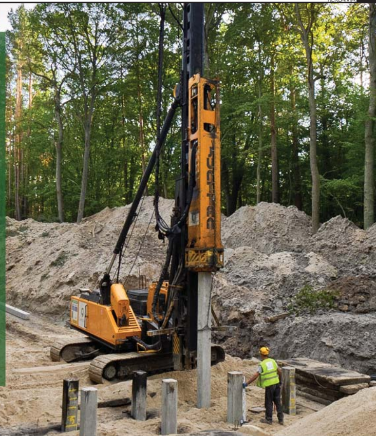
Fot. 4 Pale rurowe jako tymczasowy fundament rusztu do wykonania deskowań mostu autostradowego. Na pierwszym planie widoczne pale wykonane z profili walcowanych
