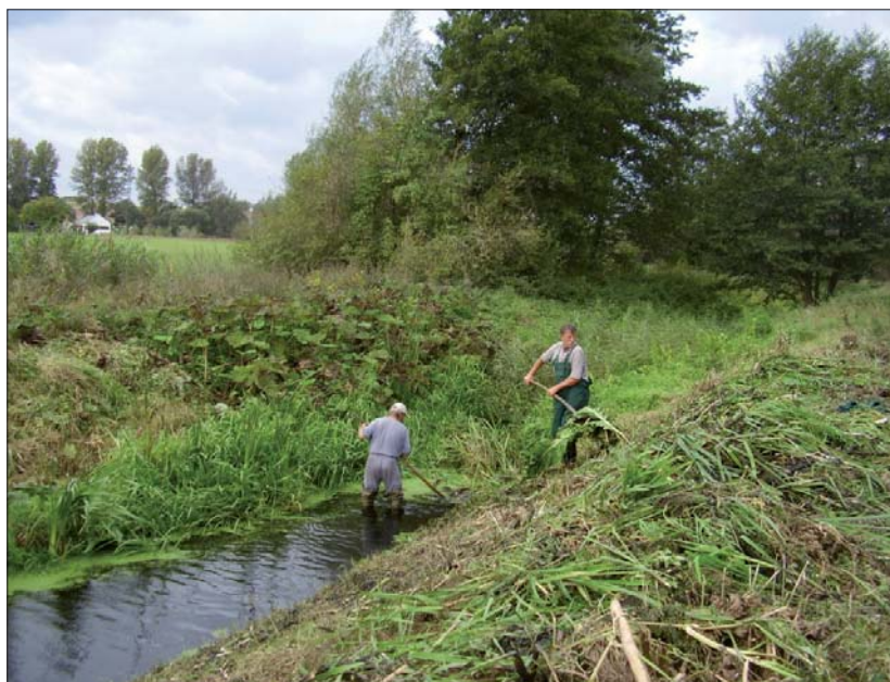
Fot. 3 | Ręczne roboty konserwacyjne – Samica Leszczyńska
