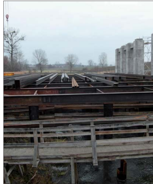
Fot. 4 Pale rurowe jako tymczasowy fundament rusztu do wykonania deskowań mostu autostradowego. Na pierwszym planie widoczne pale wykonane z profili walcowanych
