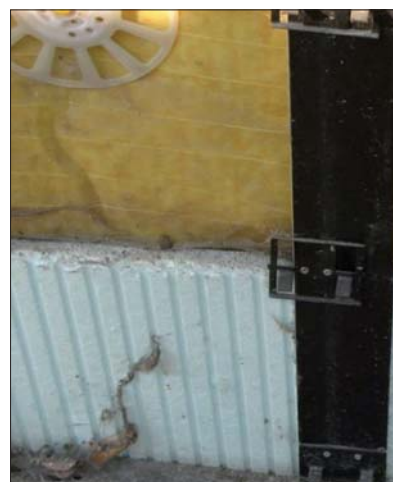
Fot. 10 | Wykonanie termoizolacji w pasie cokolowym
