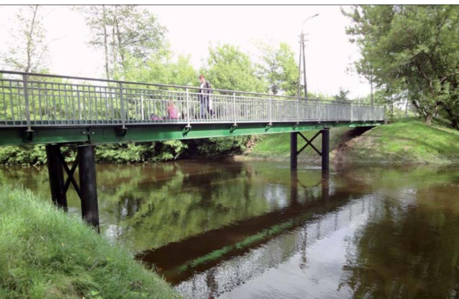
Fot. 2 | Podpora kładki dla pieszych wykonana z wbitych rur stalowych wypełnionych betonem
