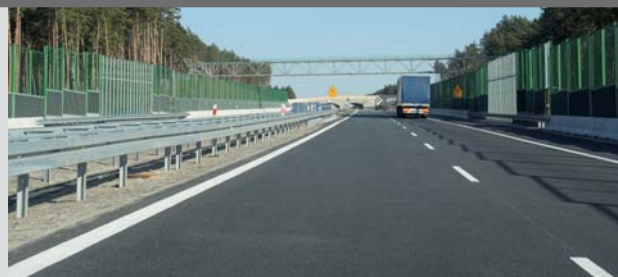
Bramownica dla nietoperzy nad autostradą A2 na odcinku Nowy Tomyśl – Świecko
