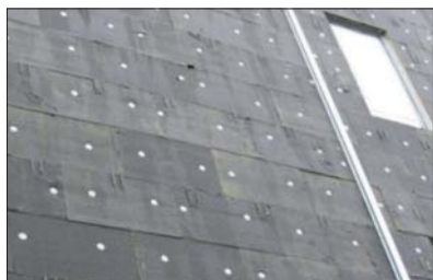
Fot. 11 | Widok zgłoszonej do kontroli międzyopieracyjnej warstwy termoizolacyjnej
