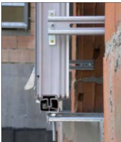
Fot. 3. Montaż okna wywieszonego w strefie izolacji zewnętrznej muru
