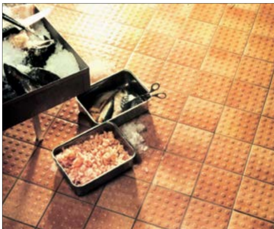
Fot. 2. Ceramiczna posadzka antypoślizgowa w zakładzie przetwórstwa spożywczego [2]
