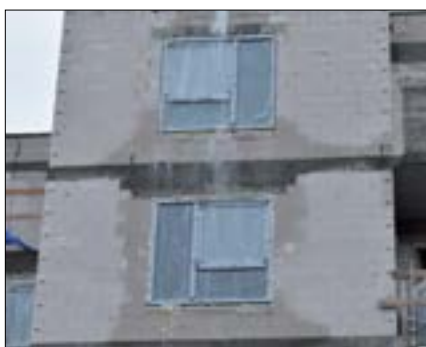
Fot. 5. Widok montażu okien, w projekcie przewidziano montaż w warstwie izolacji
