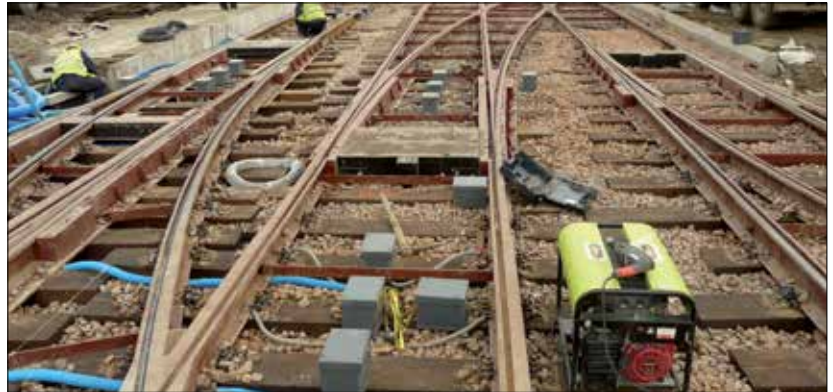
Fot. 2 | Nowe torowisko tramwajowe (rozjazdy) o konstrukcji podsypkowej w trakcie wyposażania w instalację i urządzenia sterowania zwrotnicami
