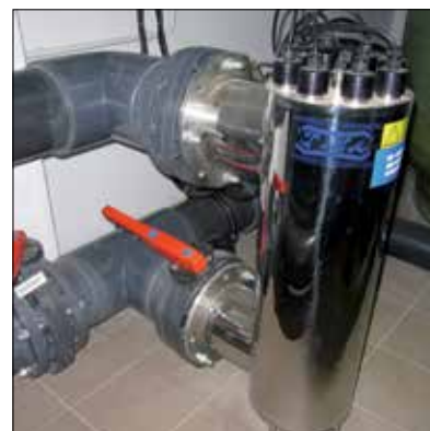
Fot. 21 | Przykład zastosowania lampy UV na basenie po remoncie
