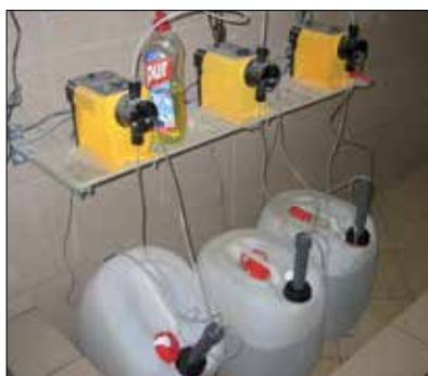
Fot. 19 | Pomieszczenie do dozowania środków chemicznych na basenie po remoncie
