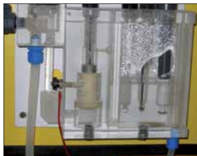
Fot. 15 | Zespół cel i elektrod do pomiaru chloru wolnego, chloru związanego, pH, redox na basenie po remoncie
