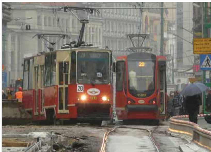
Fot. 1 | Ruch tramwajowy dwukierunkowy po jednym torze podczas budowy toru sąsiedniego. Ulica 3 Maja w Katowicach dostępna tylko dla ruchu pieszoego na czas prowadzenia robót
