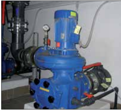
Fot. 6 | Pompa obiegowa wody w podbaseniu po remoncie
