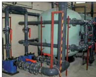
Fot. 18 | Hala pomp i filtrów z systemem na basenie po remoncie
