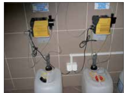
Fot. 14 | Zespół membranowych pomp dozujących korektor pH na basenie po remoncie
