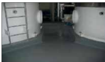
Fot. 6 | Przykłady zastosowania powłoki polimocznikowej w zakładach chemicznych
