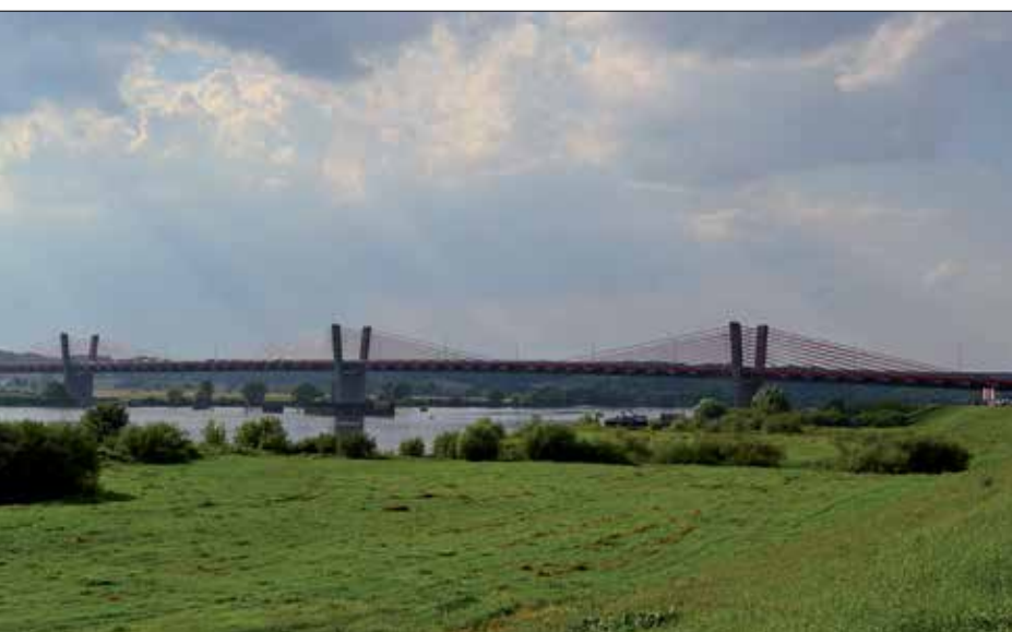
Fot. 3 | Most extradosed przez Wisłę pod Kwidzynom [5]
