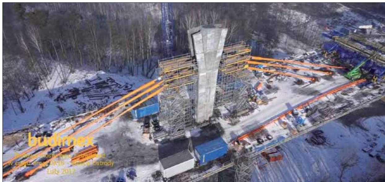
Fot. 4 | Budowa mostu w ciągu S7 w okolicach Ostródy [5]
