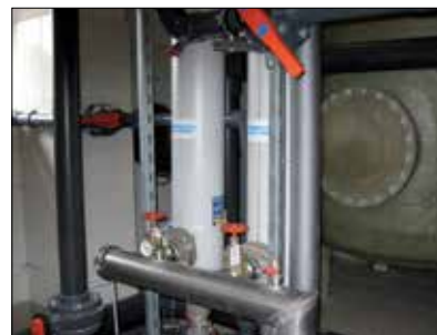
Fot. 10 | Zespół do podgrzewania wody za pomocą wymienników typu JAD po remoncie
