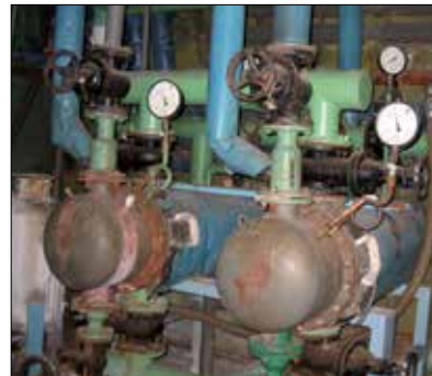
Fot. 9 | Wymienniki ciepła w instalacji wody basenowej przed remontem
