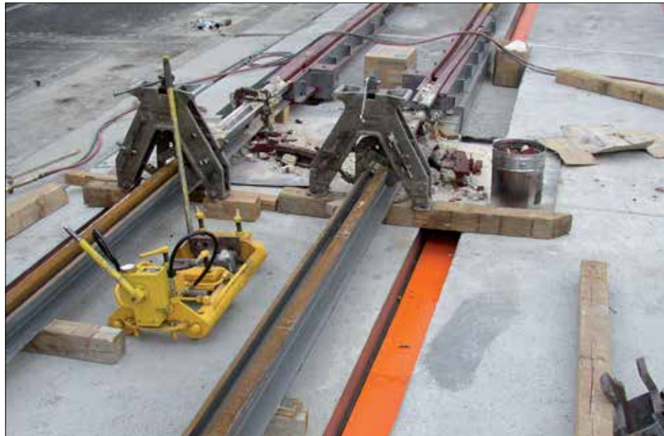
Fot. 4 | Spawanie szyn i przyrządów wyrównawczych poza kanałami szynowymi z ułożonymi podkładkami sprężystymi w kanałach (pomarańczowe elementy)
