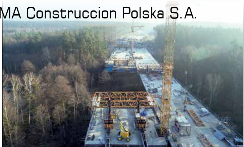
Budowa mostu MS-30.1 przy użyciu wózków formowania nawisowego CVS
