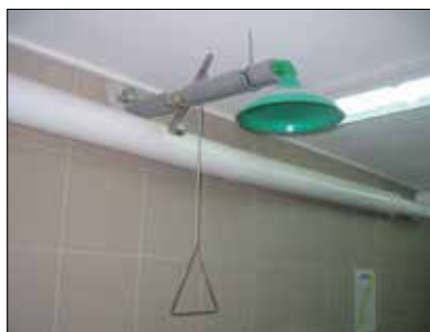
Fot. 20 | Natrysk bezpieczeństwa w pomieszczeniu środków chemicznych na basenie po remoncie
