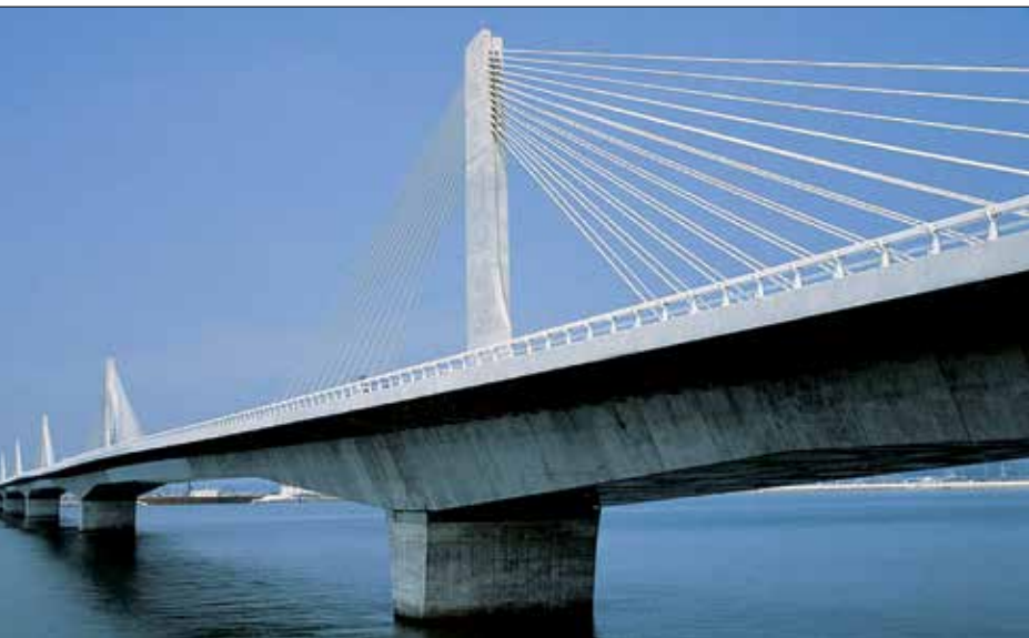
Fot. 2 | Japoński most Ibi – spektakularny przykład systemu extradosed [6]
