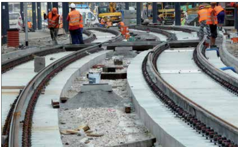
Fot. 3 | Podbudowa i nawierzchnia torowa – tory kotwione (przed wykonaniem podlewu z masy żywicznej)
