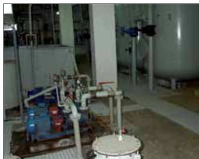
Fot. 17 | Hala filtrów z systemem na basenie przed remontem
