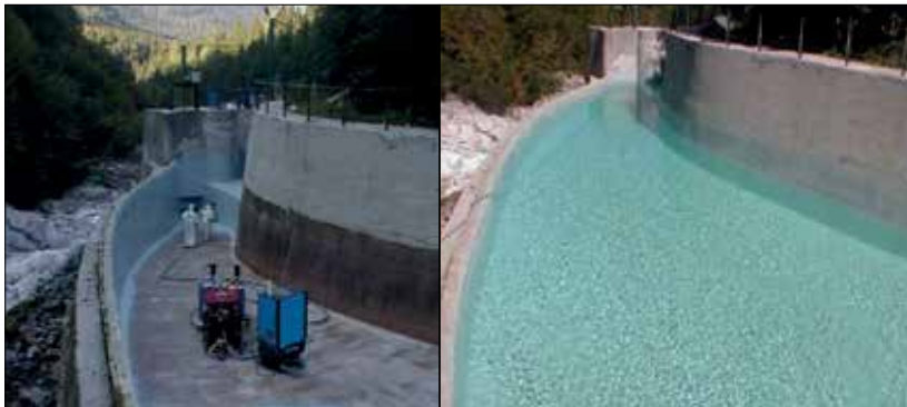
Fot. 3 | Zastosowanie powłoki polimocznikowej jako izolacji wodoszczelnej
