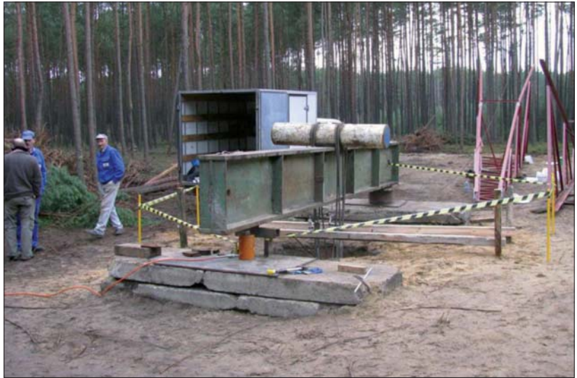
Fot. 2 | Konstrukcja do przeprowadzenia próbnego obciążenia na wyciąganie
