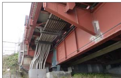
Fot. 10 | Widok południowego przyczółka części dojazdowej. Widoczny nowy sposób oparcia antysejsmicznego dźwigarów na ciosie podłożyskowym
