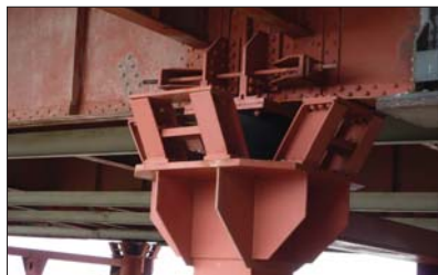
Fot. 8 | Szczegół podparcia konstrukcji nośnej na podporze za pomocą neoprenowych elementów tłumiących. Widoczne ściągi stalowe zabezpieczające konstrukcję w czasie ewentualnych trzęsień ziemi
