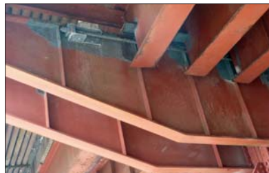
Fot. 9 | Widok poprzecznic w obrębie wspornika. Widoczne wzmocnienie górnej części poprzecznic poprzez zastosowanie odpowiednich ściągow
