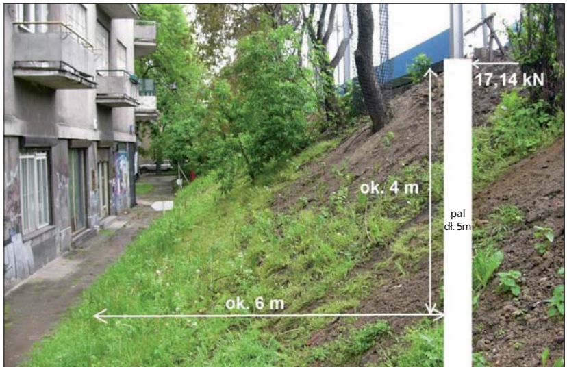
Fot. 3 | Przykład próbnego obciążenia na siły poziome pali ekranów akustycznych na skarpie
