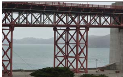
Fot. 6 | Widok na w pełni przebudowane podpory w obrębie Forth Point
