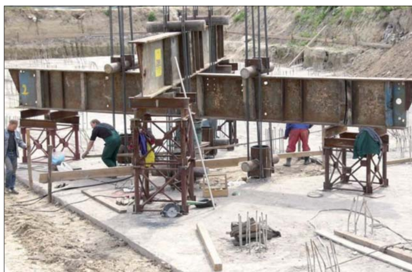
Fot. 1 | Konstrukcja do próbnego obciążenia na wciskanie
