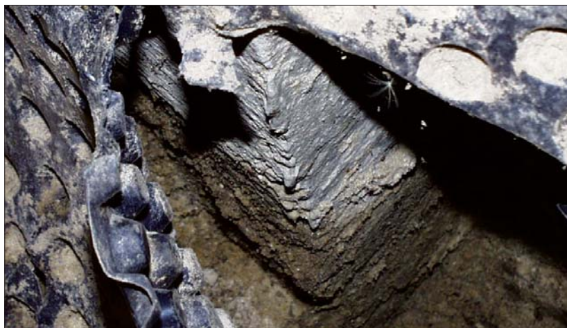
Fot. | Membran kubelkowych nie wolno stosować na hydroizolację fundamentów, nie są one kompatybilne (nie da się ich szczelnie połączyć) ani ze sobą, ani z innymi materiałami
