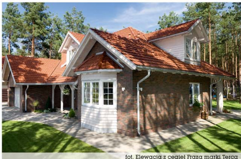
fot. Elewacja z cegiel Fraza marki Terca
