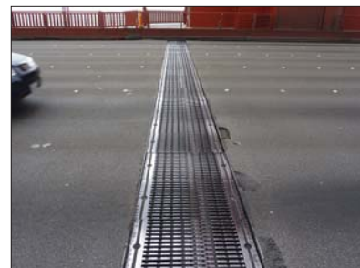
Fot. 2 | Widok urządzenia dylatacyjnego w obrębie pylonu południowego
