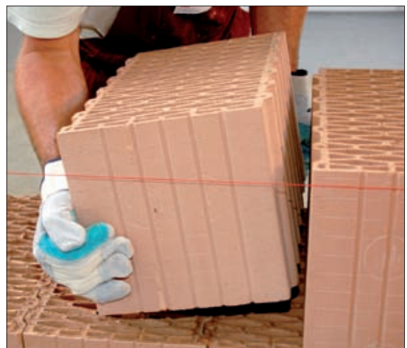
Fot. 7 | Układanie kolejnych warstw pustaków Porotherm Profi
