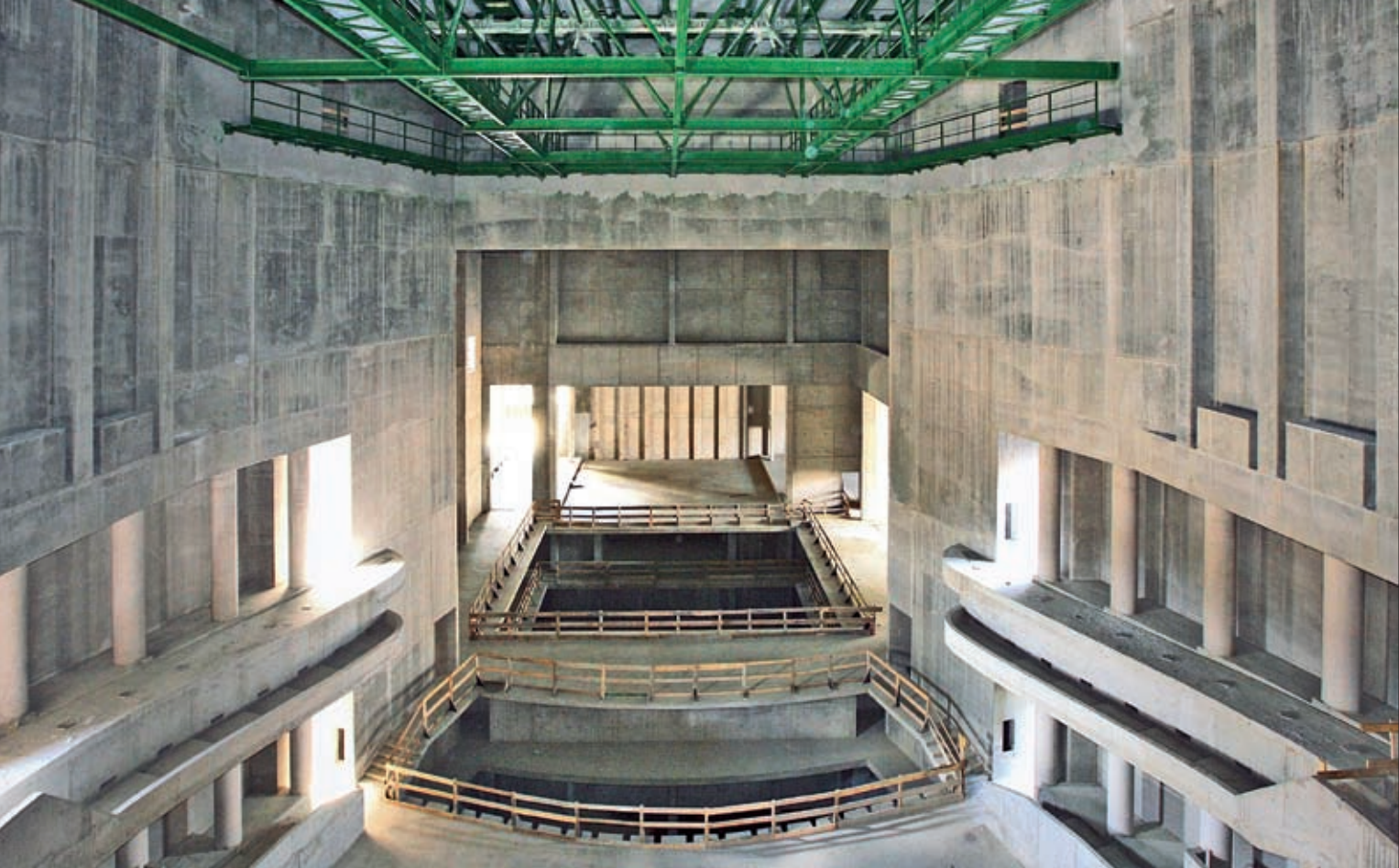
Fot. 1 | Wnętrze opery – widok na salę główną, scenę i podscenie
