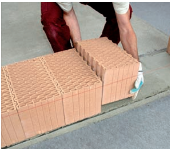
Fot. 4 | Układanie pierwszej warstwy cegieł
