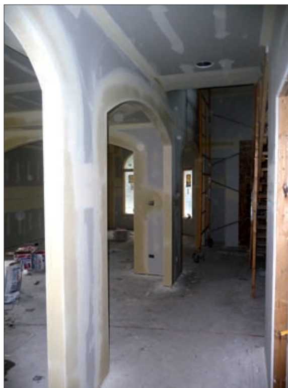
Fot. 2 | Wnętrze budowanego domu
