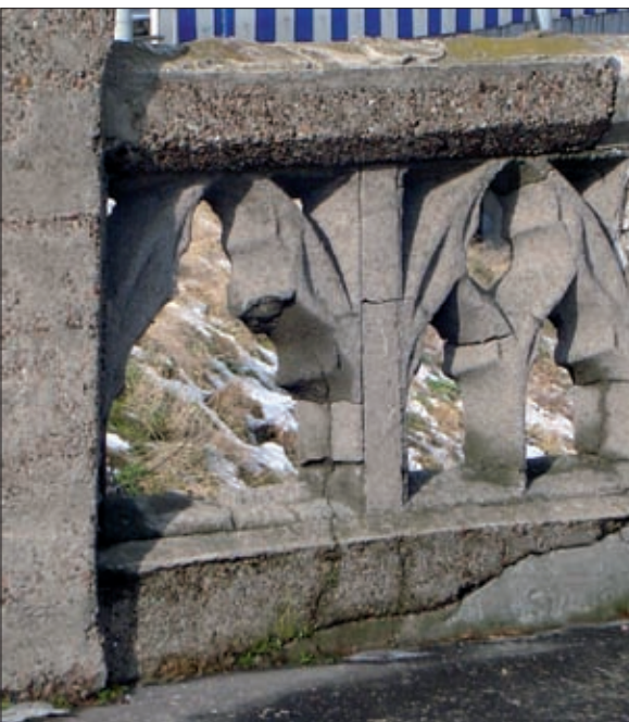
Fot. 6 | Neogotycka prefabrykowana bariera mostu
