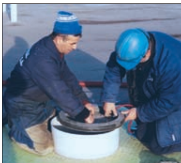
Fot. 2 | Montaż stalowej zaślepki we włazie do komory dachowej
