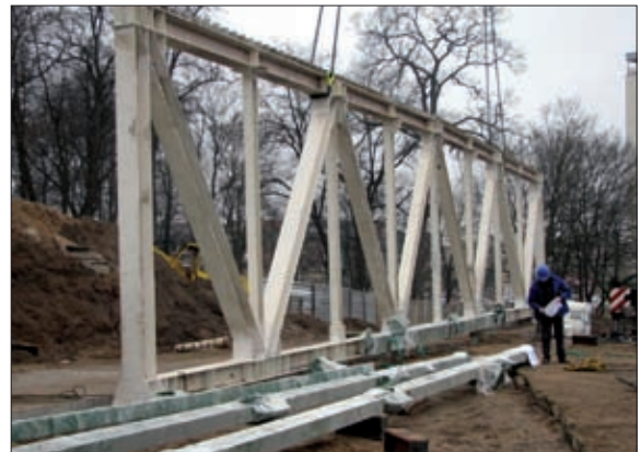
Fot. 3 | Jeden z dźwigarów kratowych, montowanych na szczycie opery
