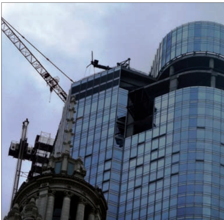
Fot. 3 | Trump International Hotel & Tower w Chicago – budowa najwyższych kondygnacji
