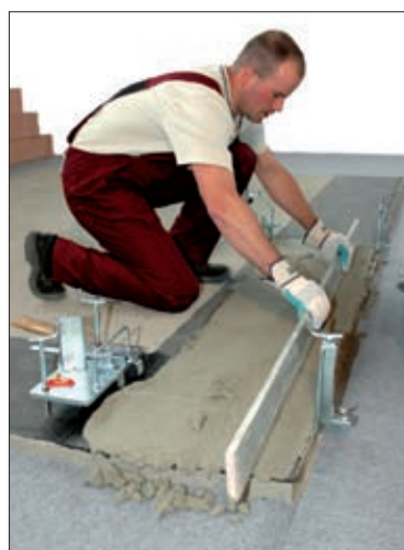
Fot. 3 | Wyrównanie podłoża pod pierwszą warstwę cegieł
