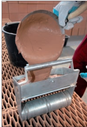
Fot. 5 | Napełnianie wałka zaprawą do cienkich spoin
