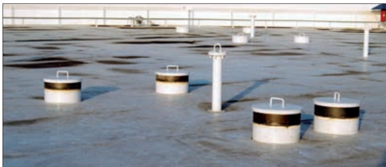
Fot. 3 | Podwyższone króćce włazów do komór dachu pływającego
