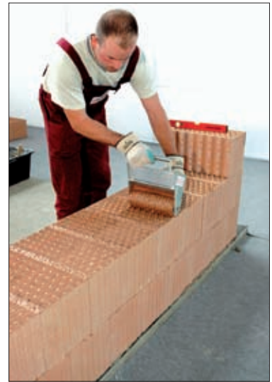
Fot. 6 | Nanoszenie zaprawy za pomocą wałka
