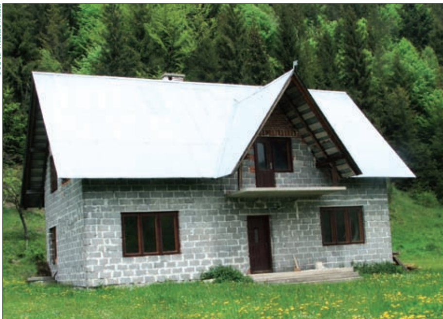
Budowa domu jednorodzinnego w Ochojnicy
