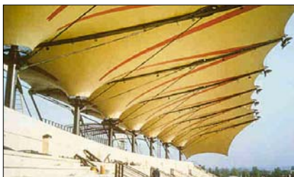
Fot. 15. Zadaszenie trybun wykonane z membran firmy Ferrari
