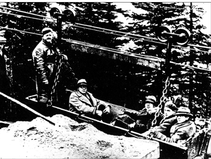
Fot. 1. Linowa kolejka robocza z Myślenickich Turni na Kasprowy Wierch: źródło: E. Raabe „Kolejki linowe”, Warszawa 1936
