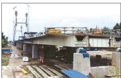
Fot. 30a. Most Siekierski w Warszawie podczas budowy, strona śródmiejska
