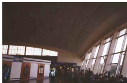
Fot. 2. Powłoka żelbetowa nad halą lotniska w Kijowie, Rosja
