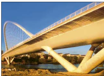
Fot. 26. Przykład mostu łukowego
