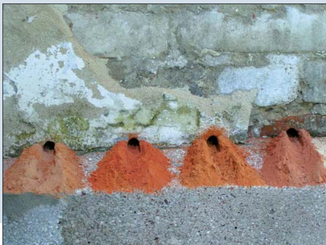
Fot. Rząd otworów przygotowanych do iniekcji
