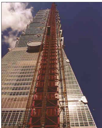
Fot. 22b. Taipei 101 widok z dołu na tymczasową roboczą windę towarowo-osobową
