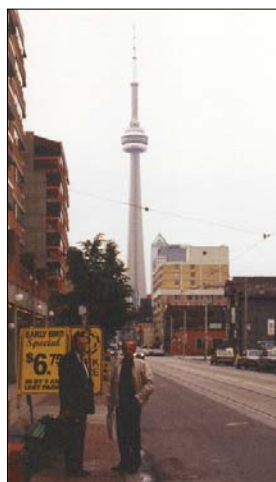
Fot. 33. Żelbetowa wieża telewizyjna w Toronto (553 m) ze stalową iglicą na szczycie
