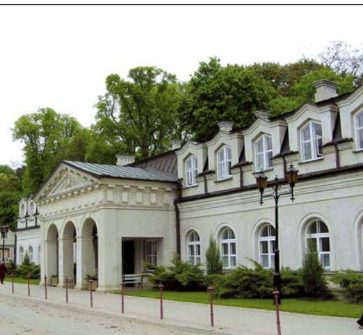
Fot. Uzdrawisko Nałęczów. Wyremontowana elewacja frontowa budynku Starych Łazienek
