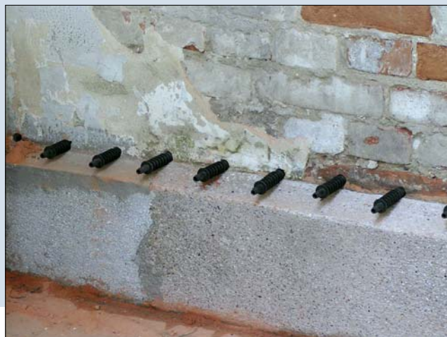
Fot. Iniektory przygotowane do wprowadzenia preparatu w przegrodę
