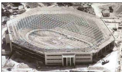
Fot. 5. Konstrukcja kopuły prętowej nad stadionem wykonanej w systemie Orona
