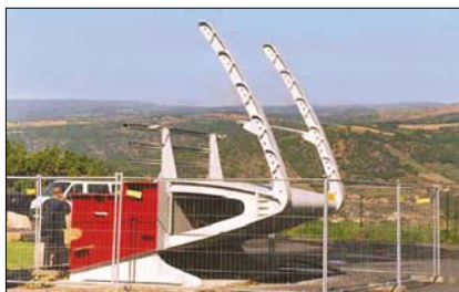
Fot. 28b. Typowy segment boczny cienkościennego stalowego pomostu wiaduktu Millau
