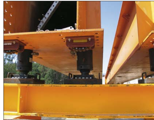
Fot. 2. Blachownice oparto na siłownikach hydraulicznych o nośności 1000 kN każdy
