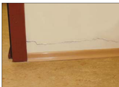
Fot. 5. Przykład zarysowania ścianek działowych spowodowanego ugięciem stropu
