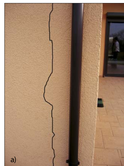
Fot. 2. Zarysowanie na styku części wyższej i części niższej budynku
