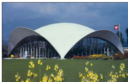
Fot. 1. Powłoka żelbetowa zaprojektowana przez Islera
