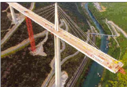
Fot. 28a. Ogólny widok wiaduktu Millau na autostradzie A75 łączącej Clermont-Ferrad z Béziers w południowej Francji; podpory – cienkościenne, żelbetowe; podwieszony pomost i pylony – cienkościenne stalowe
