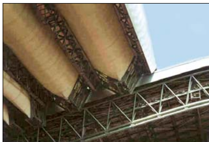
Fot. 21b. Szczegół fałdowanej konstrukcji dachu stadionu Toyoty podczas rozsuwania
