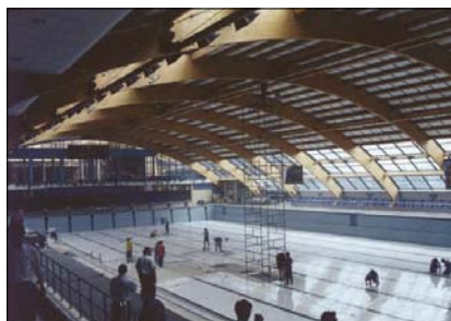
Fot. 37. Drewniane łuki nad pływalnią Warszawianki – podczas budowy
