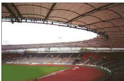
Fot. 16. Dach membranowy nad stadionem w Stuttgarcie
