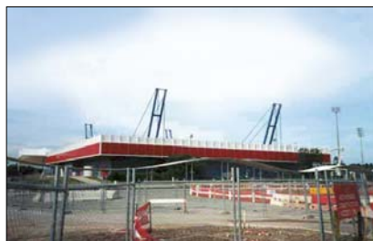
Fot. 11. Wielofunkcyjna hala sportowa w głównej wiosce olimpijskiej w Sydney – dach podwieszony na czterech słupach
