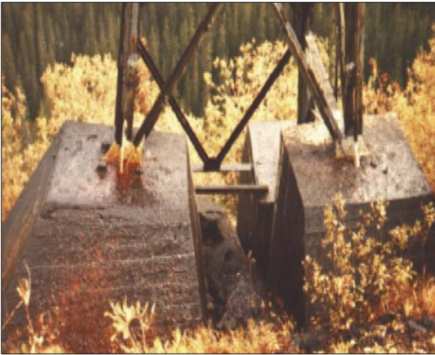
Fot. 2. Stopy fundamentowe pod słupy kolei
