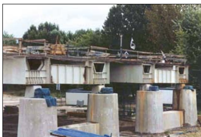
Fot. 30b. Podpory żelbetowe i cienkościennie dźwigary stalowe mostu Siekierskiego
