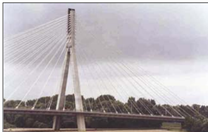
Fot. 29. Pylon, system lin i przyczółek podwieszonoego mostu Syreny w Warszawie
