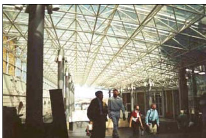
Fot. 8. Konstrukcja dachu nad biblioteką w Watykanie
