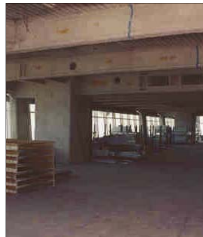
Fot. 22c. Taipei 101 widoczne dwie z ośmiu superkolumn nośnych na 88 piętrze i konstrukcja stalowa stropu
