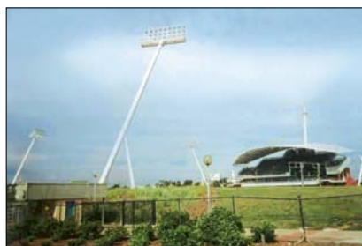
Fot. 12. Zadaszenie nad niewielką trybuną, podwieszane na jednym słupie, w głównej wiosce olimpijskiej w Sydney
