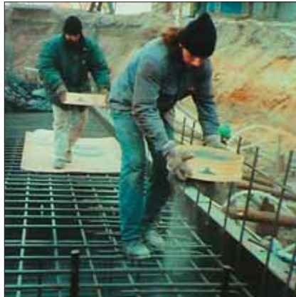
Spód płyty fundamentowej uszczelnionej Hydrostopem
