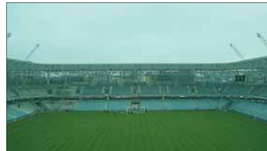
Korona stadionu uszczelniona Hydrostopem
