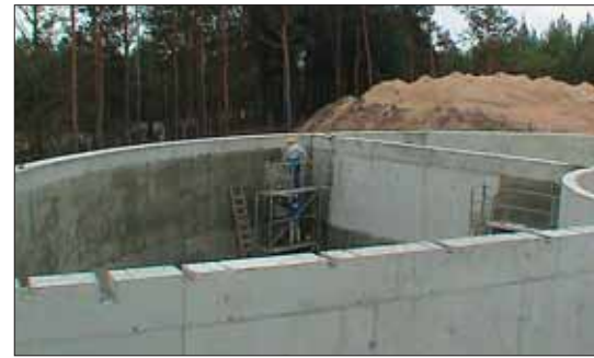
Zbiorniki oczyszczalni ścieków w trakcie uszczelniania
