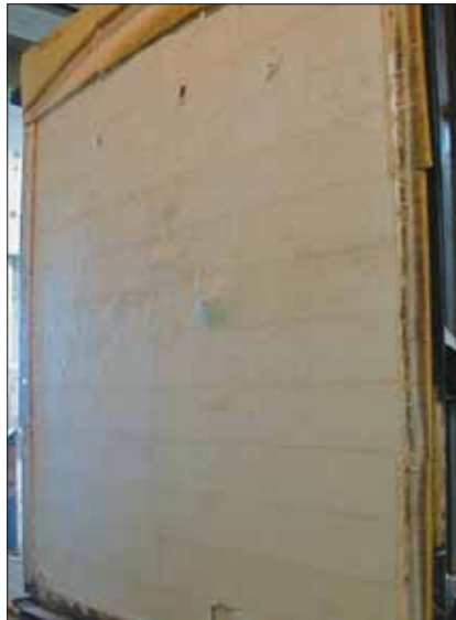
Ściana po 4 godzinach pożaru
