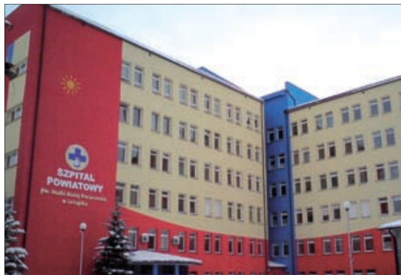
Fot. 3 | Zastosowanie farb silikonowych w budownictwie użyteczności publicznej (archiwum Silikony Polskie)
