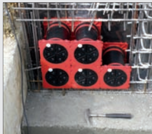
Fot. 1 | Przykład: przepusty HSI 150 łączone w bloki – odległość między osiami wynosi 208 mm
