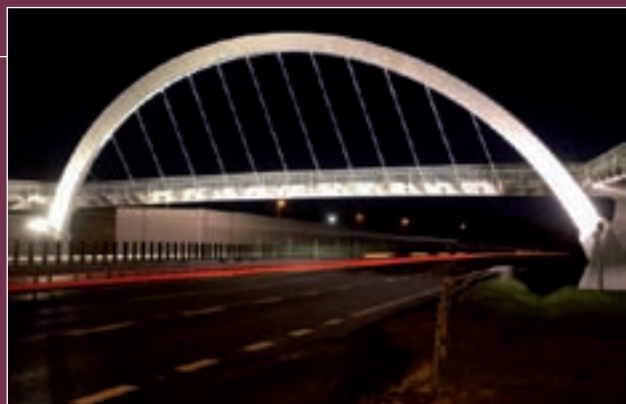
Fot. Droga ekspresowa S11 Poznań – Kórnik
