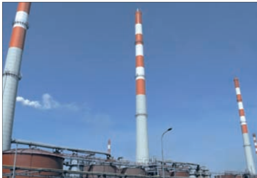
Fot. 2 | Zakłady Chemiczne Police koło Szczecina – remont czterech kominów. Powierzchnia zewnętrzna kominów została zabezpieczona akrylową farbą (część poniżej białoczerwonych pasów ostrzegawczych). Komin to budowla, która ze względu na swoją funkcję musi być projektowana z wielką starannością. Jednym z elementów właściwego zaprojektowania nowego lub projektu remontu już oddanego kominu jest właściwy dobór powłoki zabezpieczającej, zapewniającej wymaganą trwałość w środowisku spalin przemysłowych.
