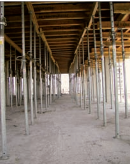
Fot. 1 | Szalunki stropowe wsparte na podporach
