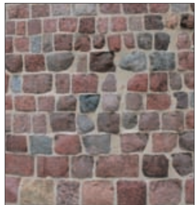
Fot. 2 | Fugenmörtel ECC
