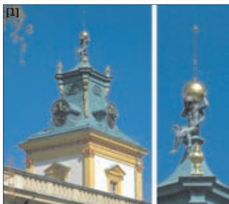
Fot.: 1 – Pałac i Park w Wilanowie, 5 akceleratorów SE-15 z licznikami Rp 107m, od 2004 r.; 2 – Budynek mieszkalny W-wa ul. Wiejska 20, akcelerator SE-15, od 2008 r.; 3 – PSP – CDK w Ostrowcu Św., akcelerator SE-09 z licznikiem, Rp 70m, od 2001 r.
