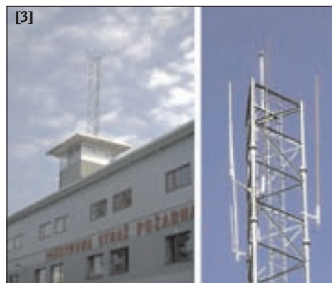
Fot.: 1 – Pałac i Park w Wilanowie, 5 akceleratorów SE-15 z licznikami Rp 107m, od 2004 r.; 2 – Budynek mieszkalny W-wa ul. Wiejska 20, akcelerator SE-15, od 2008 r.; 3 – PSP – CDK w Ostrowcu Św., akcelerator SE-09 z licznikiem, Rp 70m, od 2001 r.
