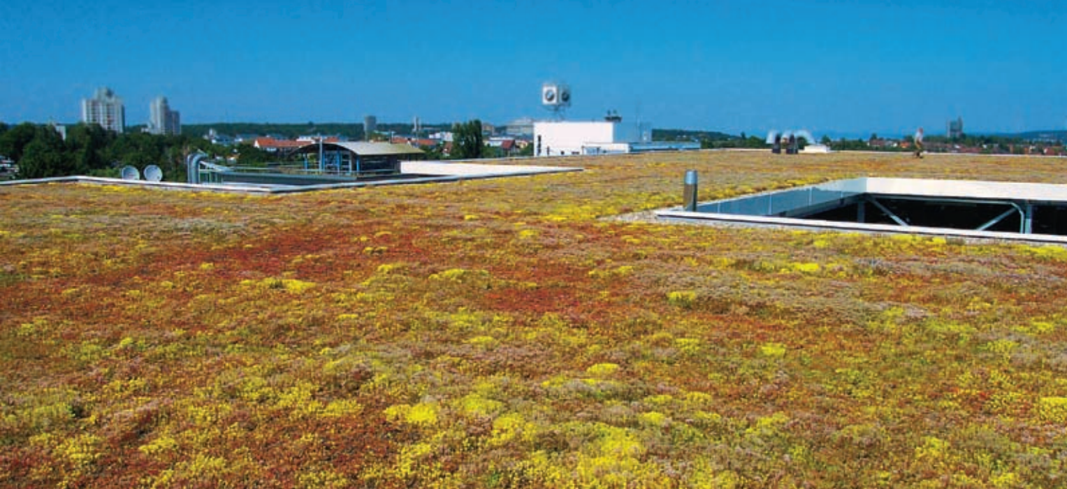
Fot. 1 | Dach ekstensywny na budynku fabryki BMW w Stuttgarcie; źródło: Optigrün International AG
