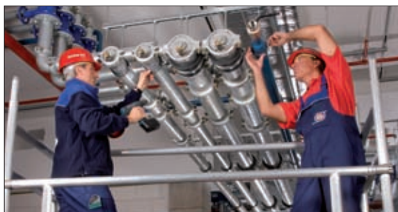
Montaż instalacji przy użyciu systemu SaMontec
