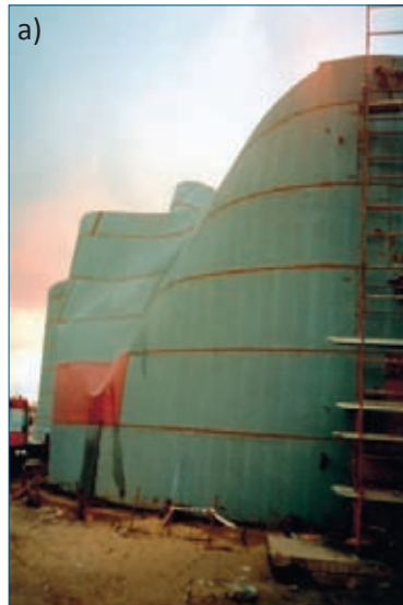
Fot. 5 | Płaszcz uszkodzonego zbiornika dwupłaszczowego: a) po awarii, b) po pierwszym etapie naprawy
