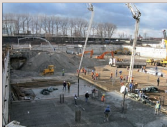
■ Izolowanie Hydrostopem i betonowanie
