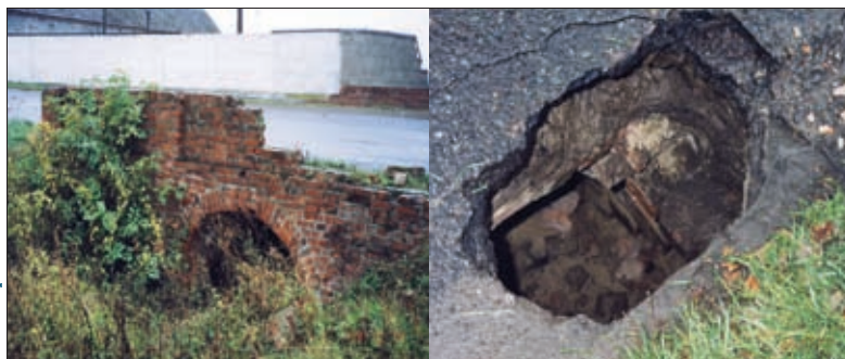
Fot. 2 | Skutki braku bieżącego utrzymania przepustu drogowego
