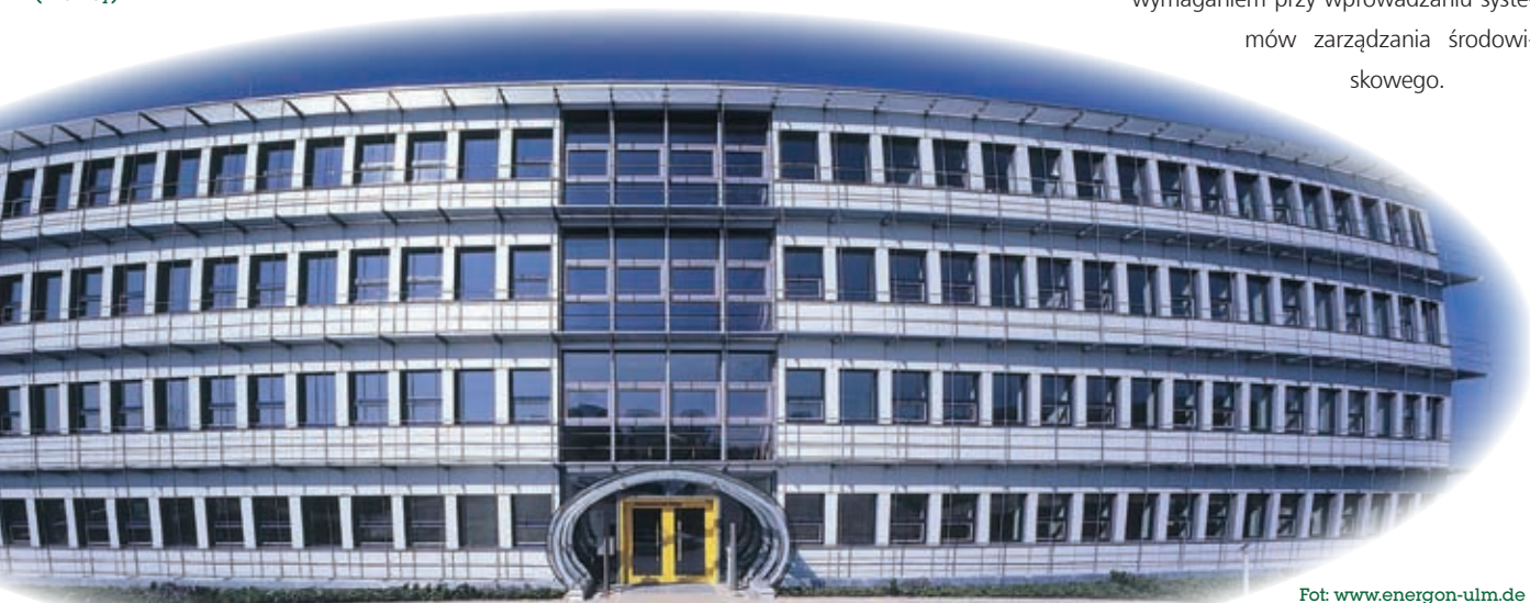
Budynek biurowy Energon wybudowany w standardzie budownictwa pasywnego w 2002 r. w Ulm (Niemcy)
