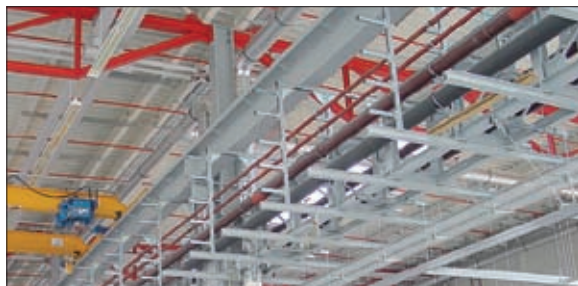
Montaż rusztu medialnego przeznaczonego do zamocowania instalacji
