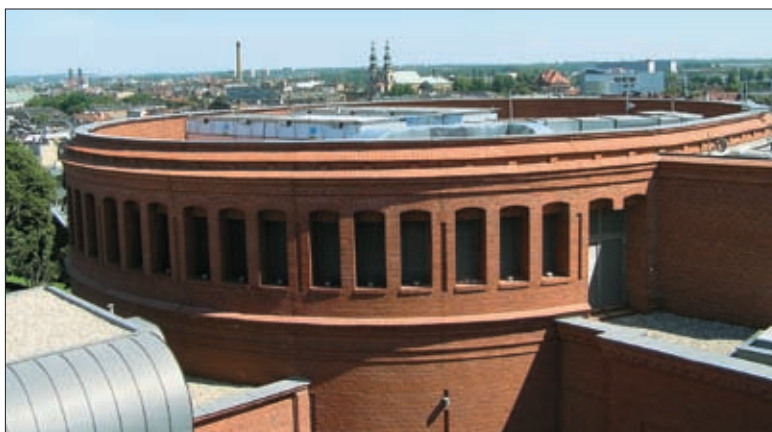
Fot. 1 | Wybudowana w I etapie rotunda z widocznymi ochronionymi wieżami chłodniczymi
