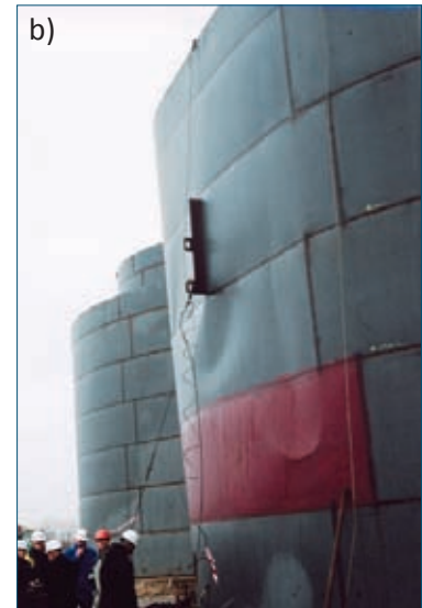
Fot. 5 | Płaszcz uszkodzonego zbiornika dwupłaszczowego: a) po awarii, b) po pierwszym etapie naprawy
