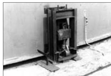
Fot. 2 | Płaszcz zbiornika uniesiony dźwignikami hydraulicznymi
