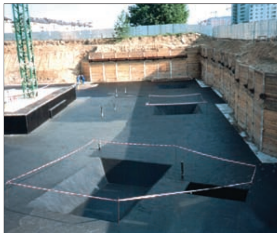
Hydroizolacja płyty dennej
