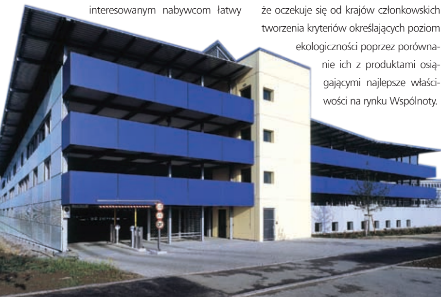
Parking przy budynku Energion (Ulm, Niemcy); źródło www.energion-ulm.de
