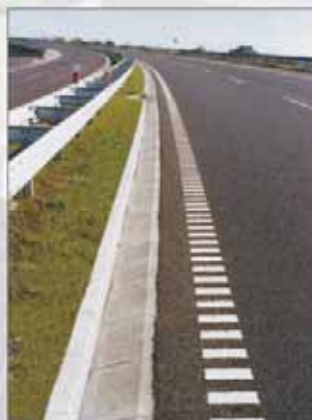
Płyta ściekowa typ trójkątny
