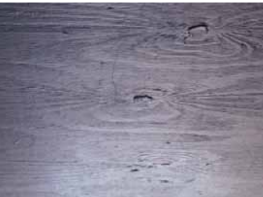
Fot. 3. Odzworowanie tekstury deskowania na powierzchni betonu
