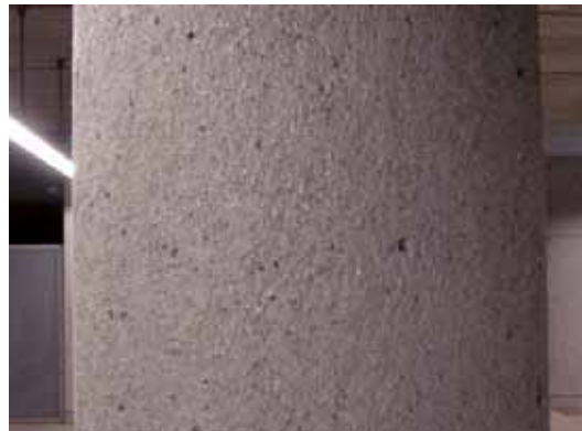
Fot. 2. Nowa faktura betonu powstała w skutek usunięcia jego wierzchniej warstwy
