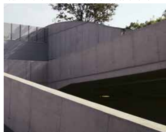
Fot. 11. Planowanie rozmieszczenia deskowania
