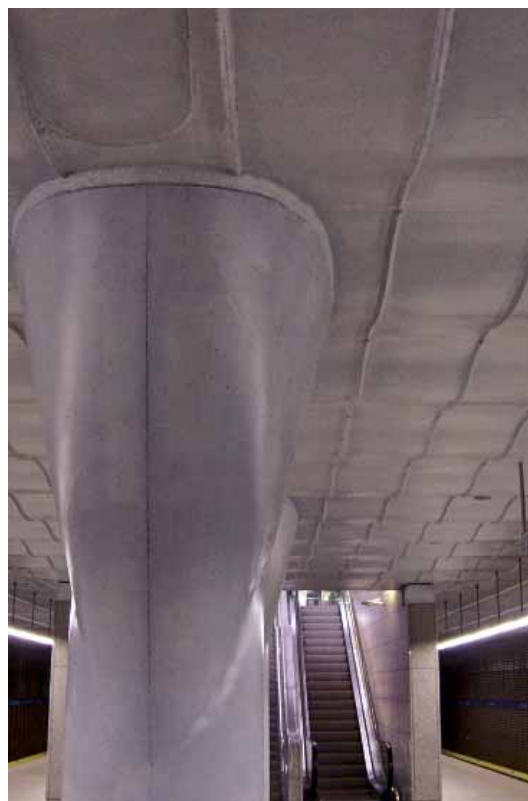
Fot. 1. Beton pokryty kolorową powłoką
