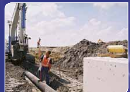
● Prace liniowe i kanalizacyjne
