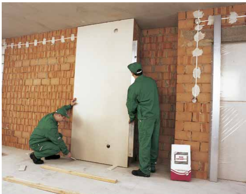
Fot. 1. Montaż płyt gipsowo-kartonowych z użyciem kleju gipsowego
