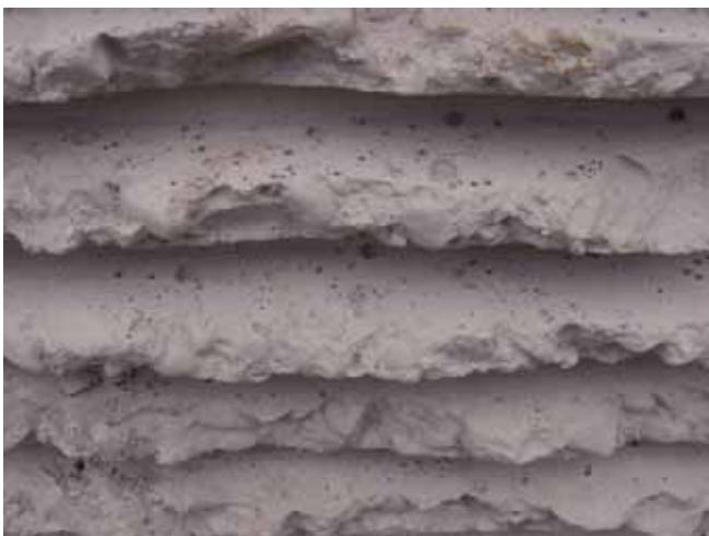
Fot. 6. Problem z odpowietrzeniem przy poziomym głębokim fakturowaniu matrycy
