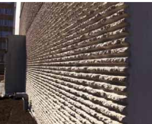
Fot. 5. Przykład ściany wykonanej z zastosowaniem matryc
