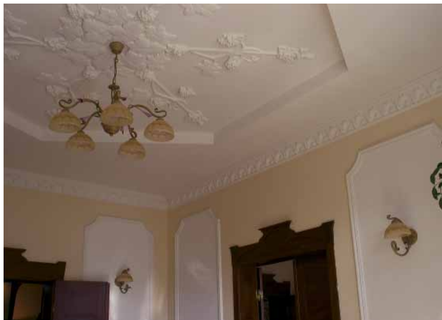
Fot. 2 Wnętrze rezydencji wykończone sztukaterią gipsową przyklejaną klejem gipsowym
