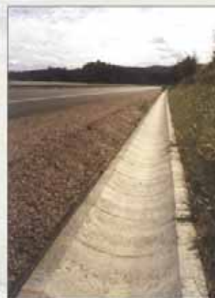
Płyta ściekowa typ korytkowy
