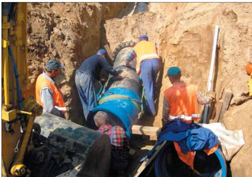
Fot. 3. Montaż trójnika na budowie magistrali dostarczającej wodę dla miasta
