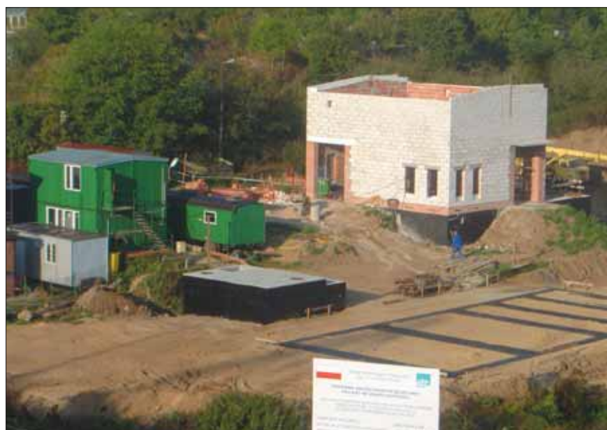
Fot. 1. Budynek pompowni Białowieska, jednej z dużych pompowni, dzięki której ścieki będą transportowane do oczyszczalni Pomorzany
