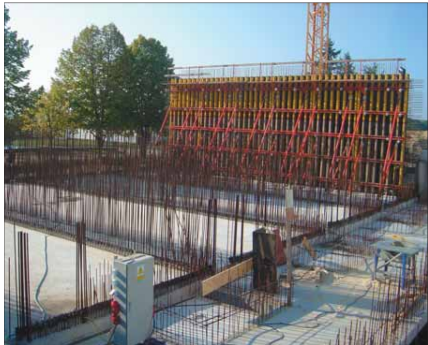
Fot. 4. Budowa stacji filtrów
