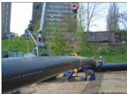
Fot. 2. Rurociąg tłoczny z tworzywa HDPE, który będzie doprowadzał ścieki do pompowni Białowieska
