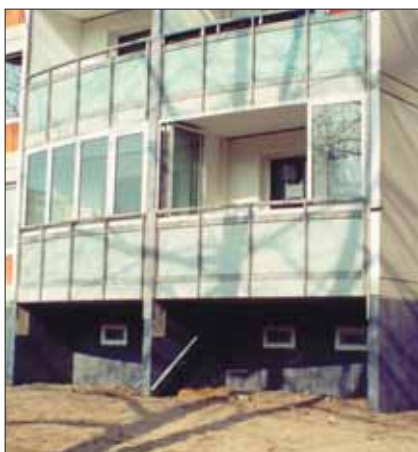
Fot. 2. Budynki w Berlinie, w których modernizacja objęła również wymianę balkonów
