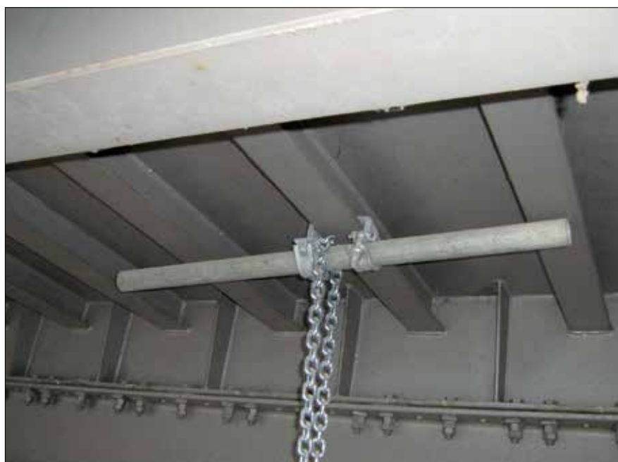
Fot. 6. Przykład złącza do podwieszeń – podwieszenie łańcucha do dwuteownika za pośrednictwem złącza hakowych (fot. autor)
