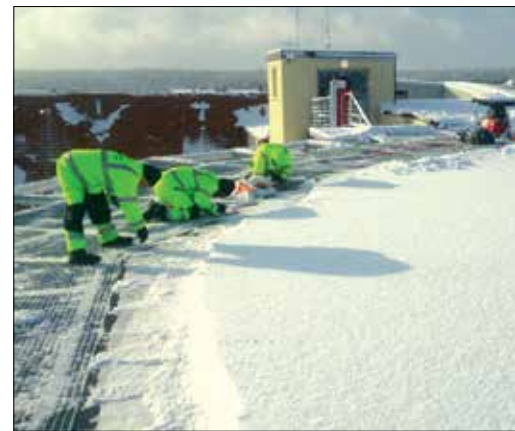
Fot. 6. Lądowisko w ławie w trakcie rozruchu systemu ogrzewania płyty kompozytowej
