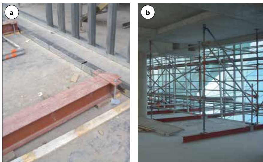
Fot. 3. Sposoby zamocowania wysuwnic rusztowania: a) zamocowanie wspornikowe, b) rozparcie o stropy (Multiserwis)
