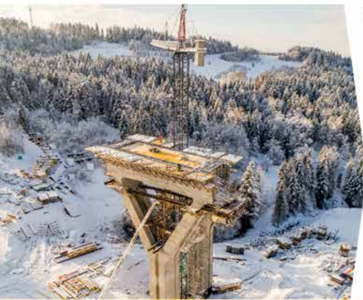
System samowznoszący ATR na budowie obiektu 21 w ciągu drogi ekspresowej S7
