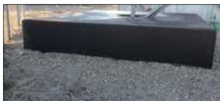
Fot. 4. Użycie materiałów bitumicznych do izolacji fundamentów (archiwum firmy Compact-Project)
