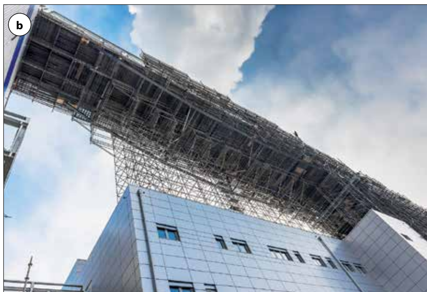
Fot. 5. Pomost podwieszony na łańcuchach: a) szczegóły zamocowania do konstrukcji koparki, b) rusztowanie częściowo podwieszane pod taśmociągiem (Multiserwis)
