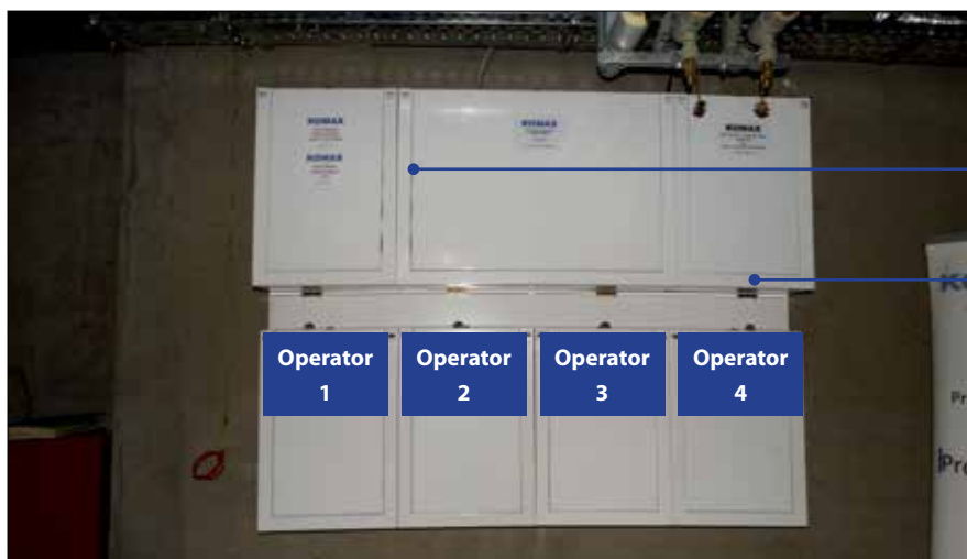
Fot. 5. Szafki punktu styku o szerokości 1600 mm, wysokości 1300 mm, głębokości zaledwie 200–250 mm oraz szafki dla czterech operatorów telekomunikacyjnych. W estetyczny sposób na ścianie w garażu można umieścić szafki i zakończyć kable z lokali mieszkalnych oraz zainstalować urządzenia aktywne instalacji zbiorowej TV naziemnej i satelitarnej TV-2sat.
