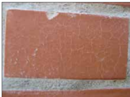
Fot. 3. Przykład niszczącego skutku krystalizacji rozpuszczalnych soli mineralnych w klinierze, stanowisko in situ badań murów licowych (fot. autor)
