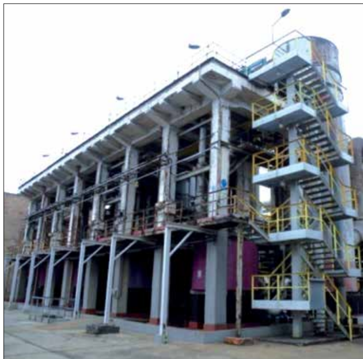
Fot. 2. Żelbetowe pomosty robocze i wanna ochronna
