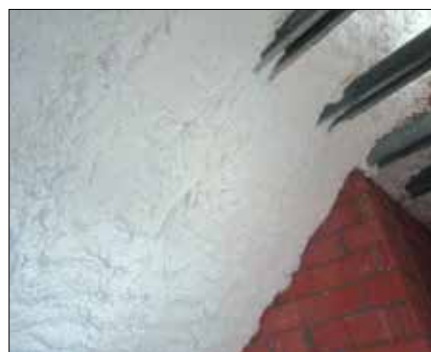
Fot. 6. Poddasze ocieplone pianą otwartokomórkową (archiwum firmy Compact-Project)
