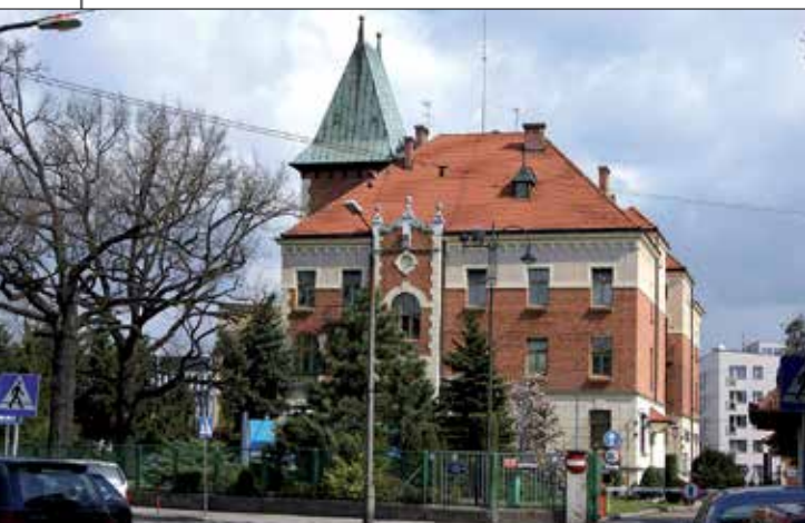
Biuro Miejskiego Przedsiębiorstwa Wodociągów i Kanalizacji S.A. w Krakowie (fot. Zygmunt Put Zetpe0202, Wikipedia)
