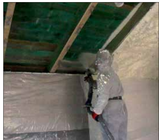
Fot. 12. Natrysk piany PUR (archiwum firmy Compact-Project)
