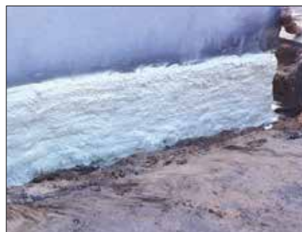
Fot. 7. Fundamenty ocieplone pianą zamkniętokomórkową (archiwum firmy Compact-Project)
