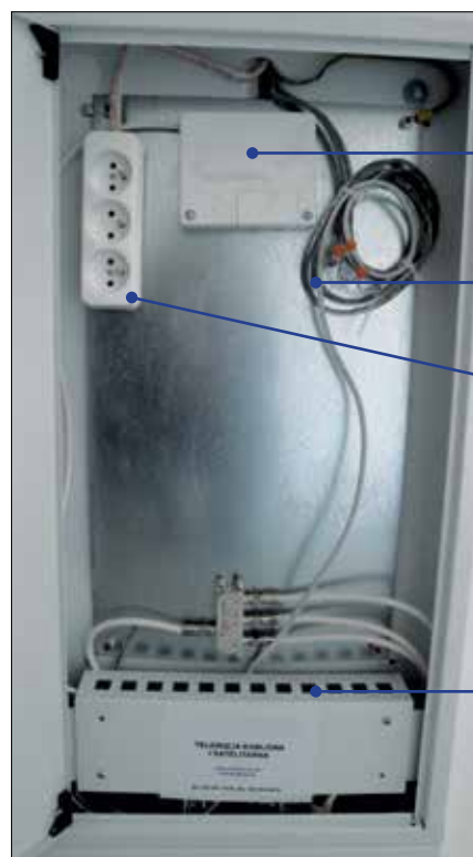
Fot. 2. Szafka natynkowa lokalowa TSM 350/700/90 mm (odpowiednio szerokość/wysokość/głębokość)
