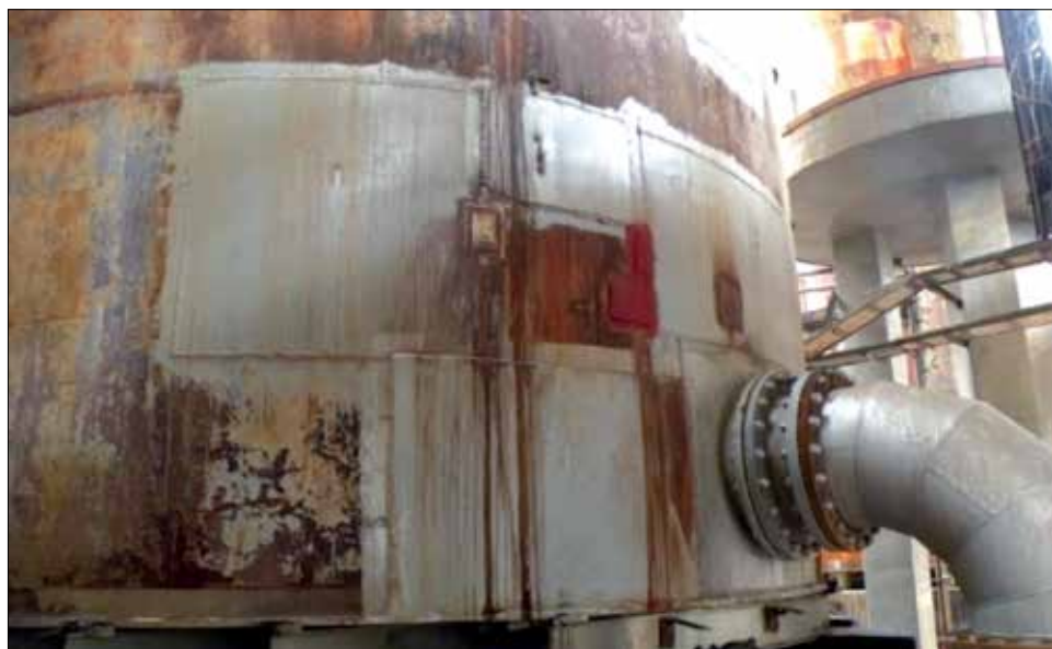
Fot. 3. Naprawy płaszcza wieży
