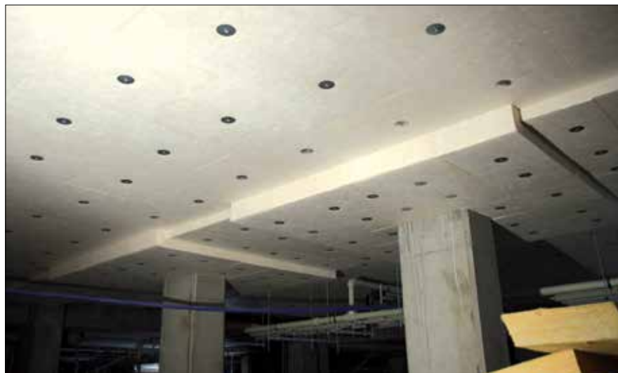
Izolacja sufitu garażu podziemnego z wykorzystaniem płyty ISOVER Stropmax 31
