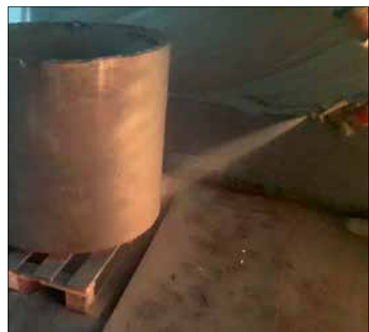
Fot. 13. Natrysk polimocznika (archiwum firmy Compact-Project)
