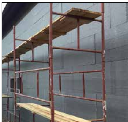
Fot. 1. Użycie styropianu do izolacji termicznej ścian (archiwum firmy Compact-Project)
