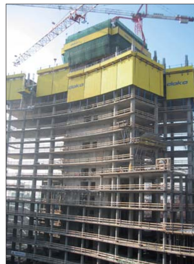
Oslona wiatrowa Doka zabezpieczająca budowę i dźwig do przestawiania sprzętu TLS
