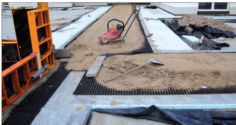
Fot. 3 | Wykonanie chodnika na dachu odwróconym
