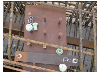
Fot. 4 Klamra przymocowana do zbrojenia ścianki zapleczonej zapewniająca stateczność dźwigara na oczepie
