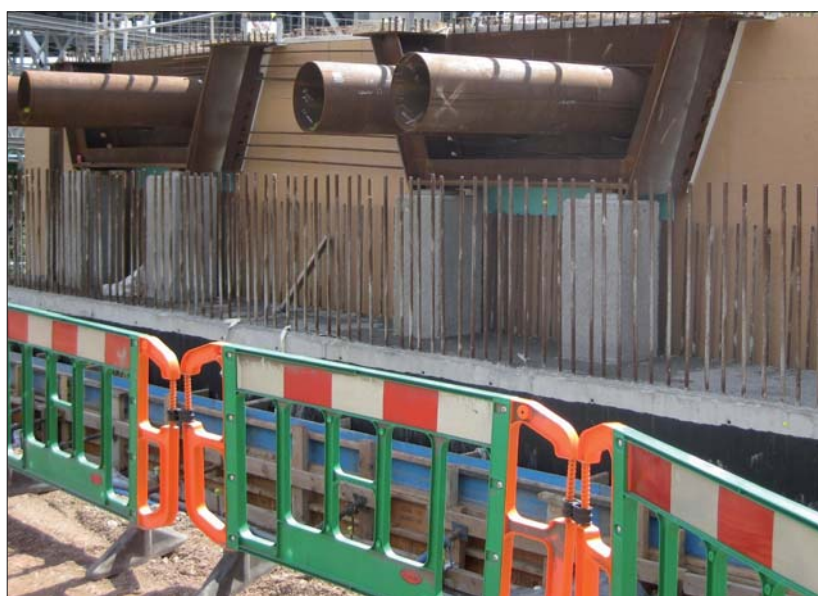
Fot. 2 | Przygotowanie do zbrojenia ścianki zaplecza – dźwigary na tymczasowych ciosach podłożyskowych
