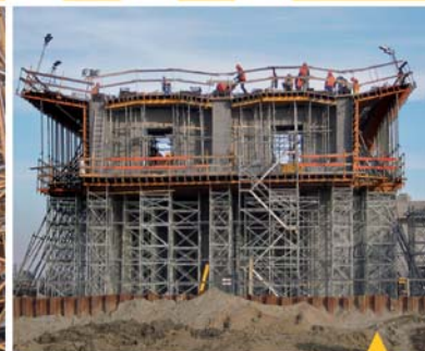
Estakada E118 w ciągu A4
