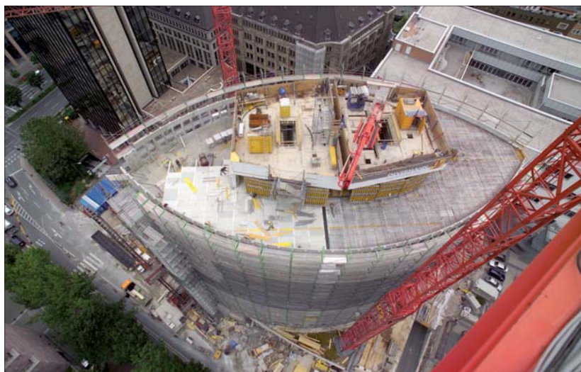
Szalunki dźwigarowe Top50 na trzonie budowanym razem z poniższym stropem
