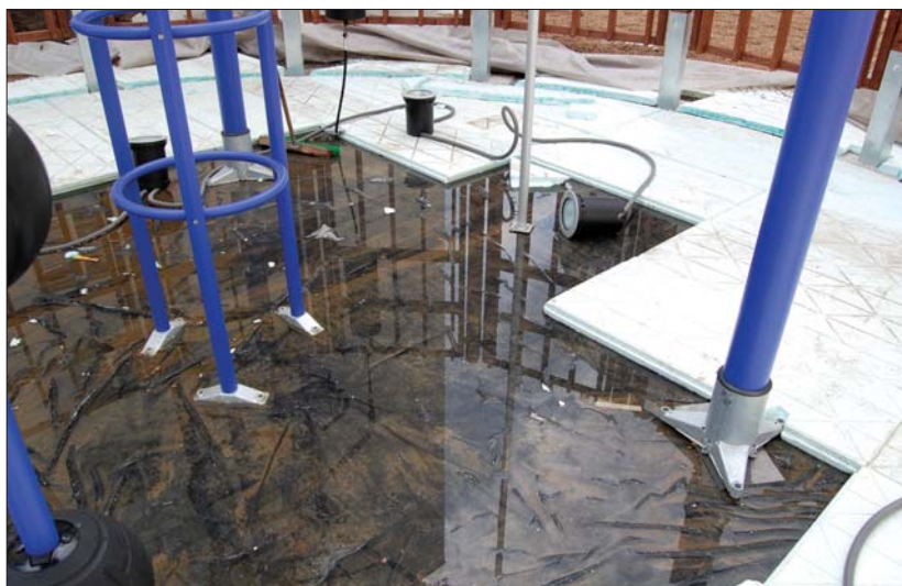
Fot. 4 | Dach odwrócony w trakcie realizacji, po deszczu
