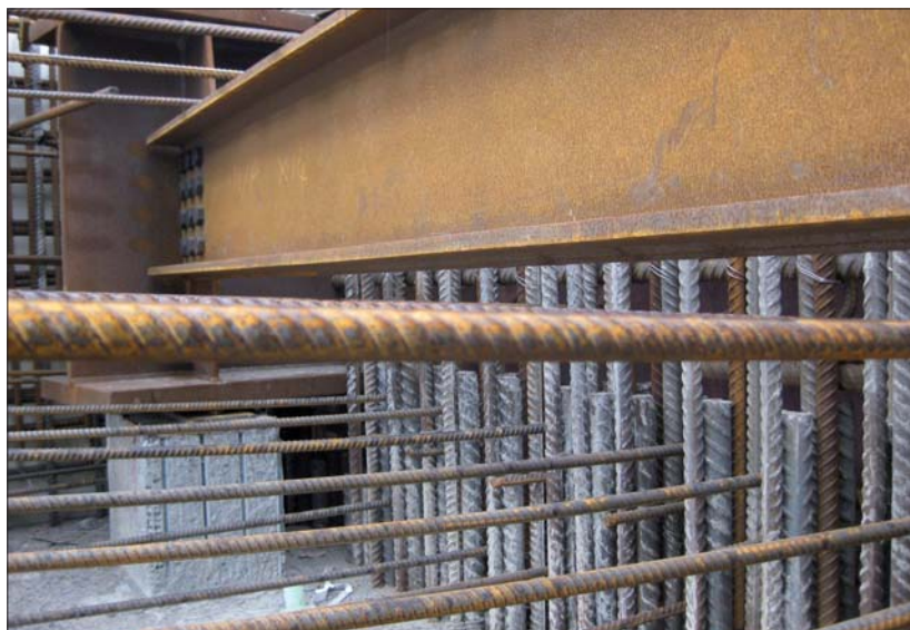
Fot. 5 | Poprzecznicę ceowa zapewniającą usztywnienie poprzeczne w czasie betonowania
