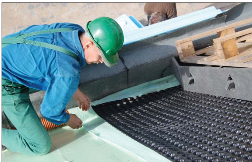
Fot. 2 | Dach zielony skośny na dachu odwróconym
