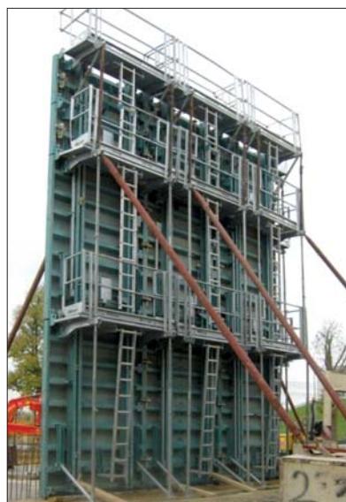
Fot. 1 Fragment zadeskowanej ściany przy użyciu deskowania ramowego wielkowymiarowego NOE-mega
