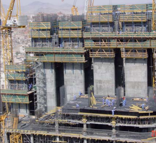
Szalunki ramowe Doka i rusztowanie samowspinające na trzonie budowanym z wyprzedzeniem
