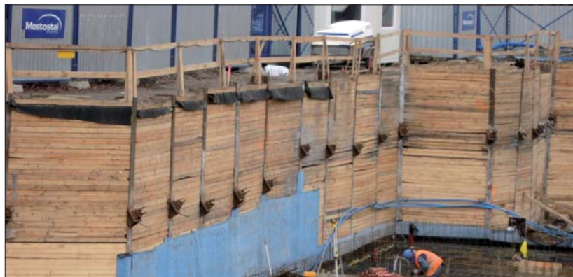
Fot. 2 | Ściana kotwiona w jednym poziomie. Pojedyncze kotwy dla każdego kształtownika. Widoczna łatwość w kształtowaniu ścianki w planie.
