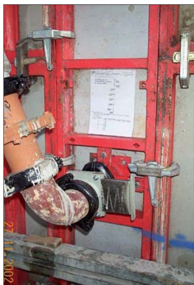
Fot. 2 Podłączenie rurociągu pompy do króćca tarczy SCC (Meva-StarTec)
