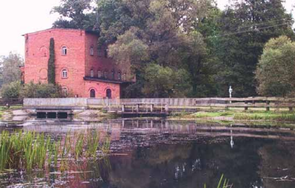
Fot. Elektrownia wodna Piła Młyn
