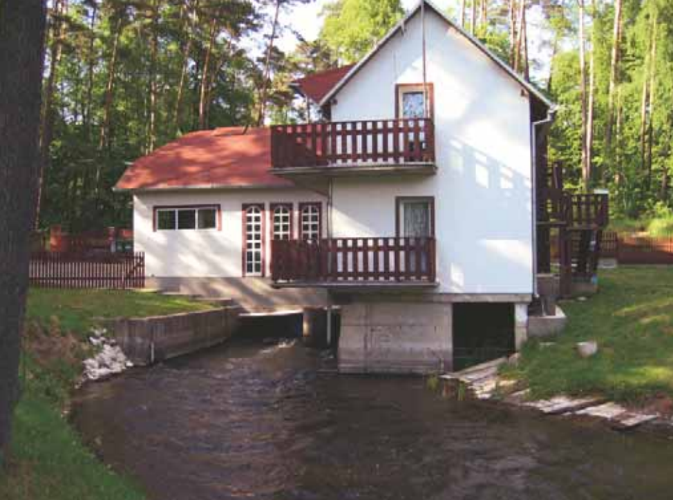
Fot. Elektrownia wodna Zielonka
