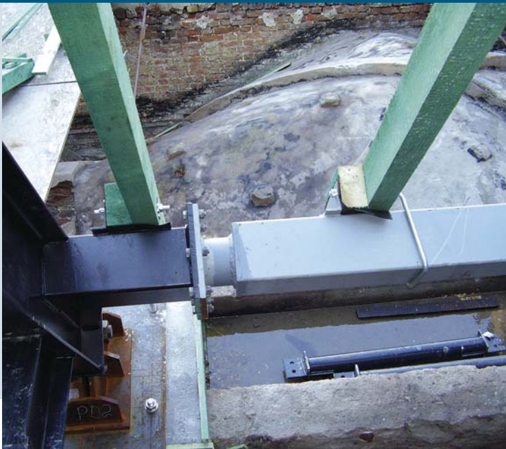
Fot. 3 Łączenie stalowej konstrukcji wieży odbywało się na dachu
