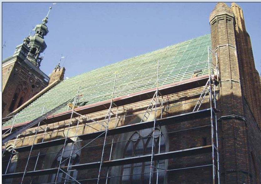
Fot. 1 Tymczasowe zadaszenie nad nawą główną od strony północnej
