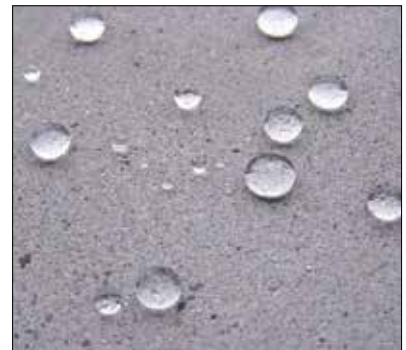
Fot. 1 | Powierzchnia betonu zabezpieczona metodą impregnacji hydrofobizującej – widoczny tzw. efekt perlenia
