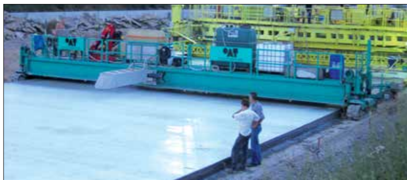
Fot. 5 | Spryskanie środkiem opóźniającym hydratację cementu w górnej warstwie nawierzchni (źródło: J. Patitz, RP Karlsruhe)
