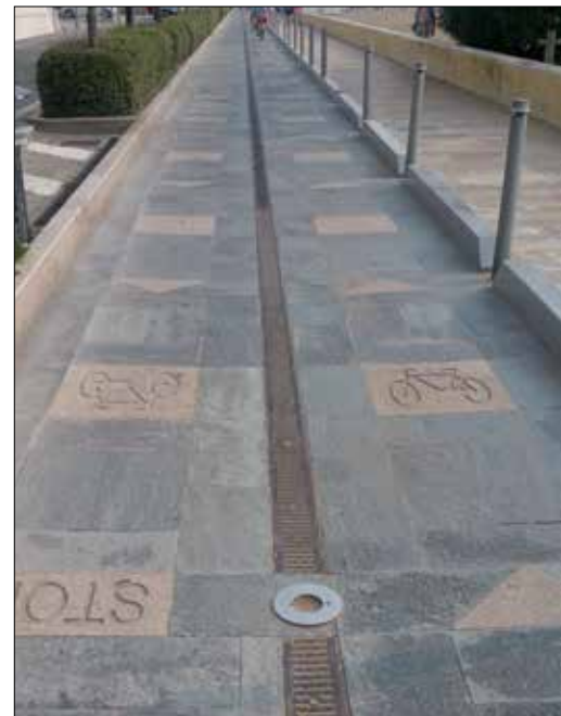
Fot. 7 | Kamienne płyty brukowe
