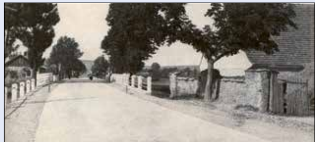
Fot. 2 Droga krajowa o nawierzchni z betonu cementowego w pobliżu Skoczowa, 1935 r. [4]
