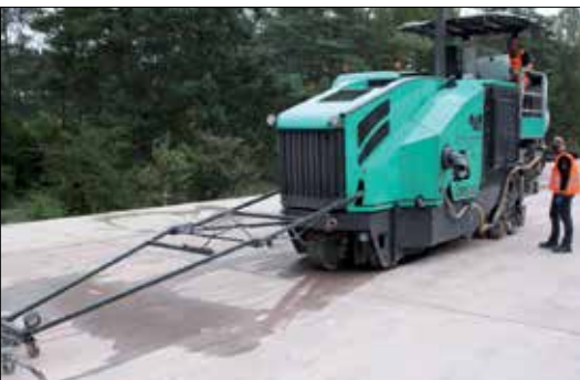
Fot. 9 | Główna maszyna do teksturowania nawierzchni metodą Grinding (źródło: OAT GmbH)
