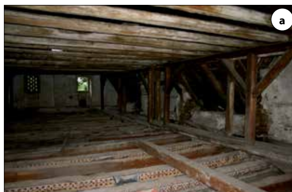
Fot. 3 | Uszkodzenia wywołane zawilgoceniem oraz działaniem grzyba domowego białego
