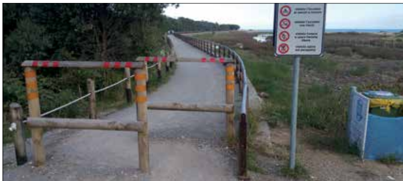
Fot.9 | Nawierzchnia z kłija kamiennego
