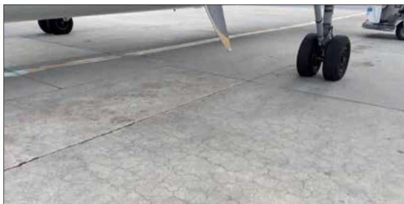
Fot. 2 | Zabezpieczona metodą impregnacji hydrofobizującej zarysowana powierzchnia lotniskowej płyty postojowej
