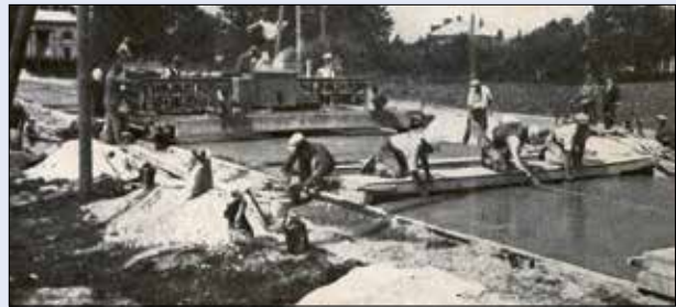
Fot. 1 Budowa drogi o nawierzchni betonowej na odcinku drogi krajowej Warszawa – Modlin, 1935 r. [4]
