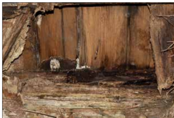
Fot. 3 | Uszkodzenia wywołane zawilgoceniem oraz działaniem grzyba domowego białego
