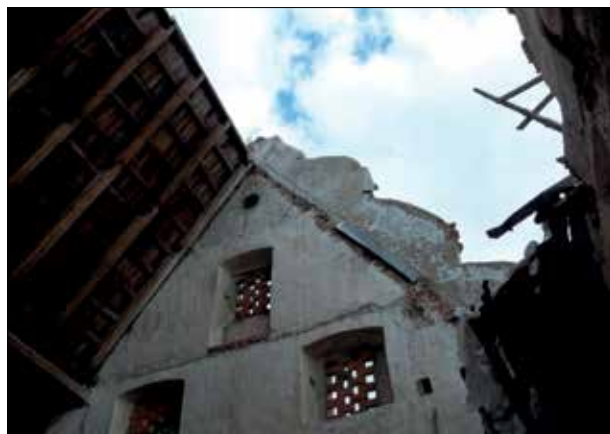
Fot. 6 | Zniszczenia w centralnej części budynku wywołane zawaleniem się dachu
