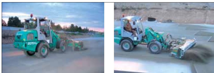
Fot. 6 | Usuwanie szczotką mechaniczną niezwiązaną zaprawę (źródło: inż. T. Alte-Teigeler, OAT GmbH, Neuss)
