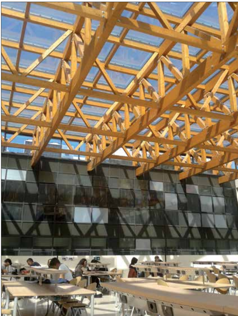
Fot. 1 Widok na więźbę dachową podtrzymującą szklany dach – uniwersytet w Trydencie, Włochy
