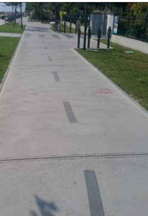
Fot. 2 | Betonowa nawierzchnia ścieżki rowerowej
