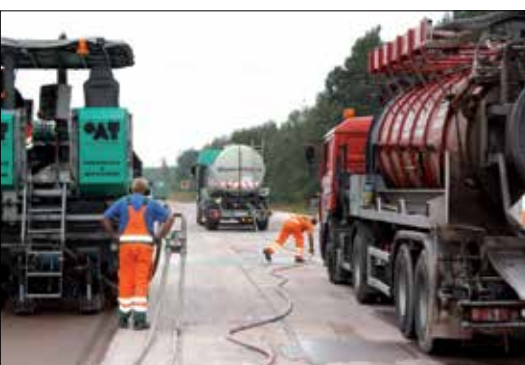
Fot. 10 | Maszyna główna wraz z innymi maszynami z zestawu urządzeń do teksturowania nawierzchni betonowych metodą Grinding (źródło: OAT GmbH)
