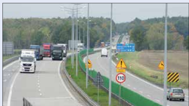
Fot. 4 Widoczny efekt po 20 latach eksploatacji autostrady (fot. Marek Stańczyk, 2015 r.)
