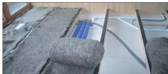
Fot. 5. Wełna owcza jako izolacja podłogi [4]
