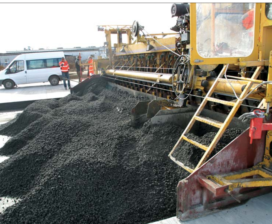
Fot. 2 | Maszyna układająca mieszankę betonową w nawierzchni
