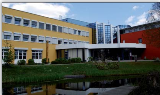
Poza poprawą wydajności energetycznej, w ramach renowacji można także odświeżyć wygląd budynku
