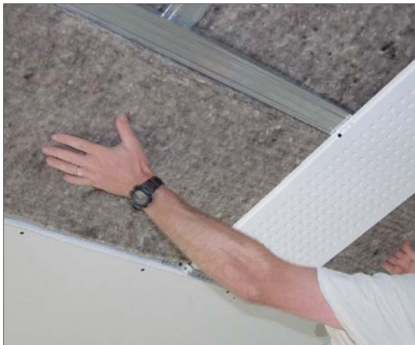
Fot. 7. Wełna owcza jako izolacja dachu skośnego [4]
