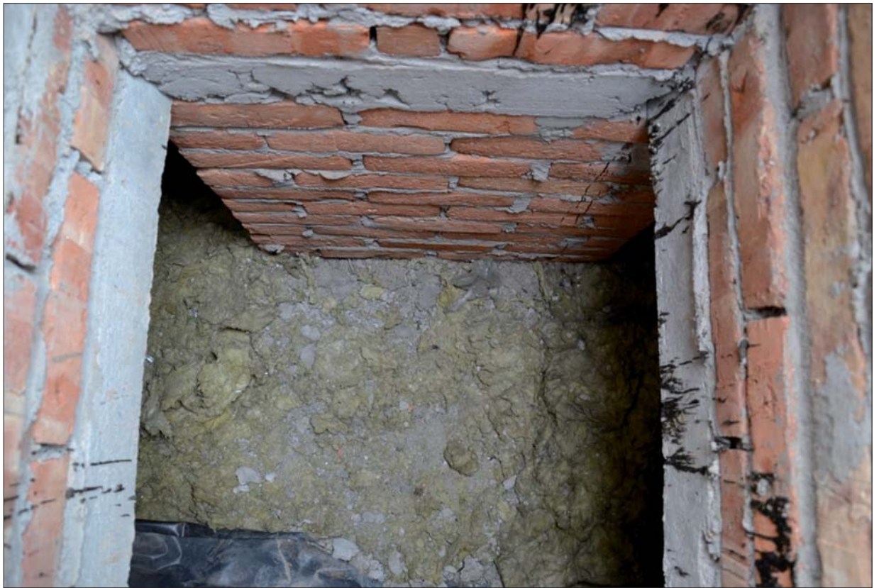
Fot. 9. Ułożenie miękkiej waty szklanej przy wejściu w stropodach wentylowany przełazowy
