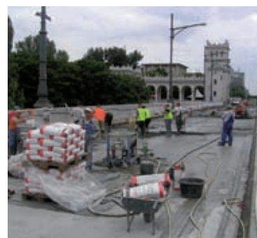
Stanowisko mieszania StoCrete TG 202.
