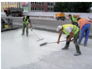
Nakładanie epoksydowego mostka szcpeznego StoPox IHS-PK pod warstwę wyrównawczą płyty pomostu.
