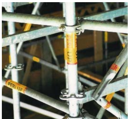
Fot. 2. Typowe rusztowania modułowe
