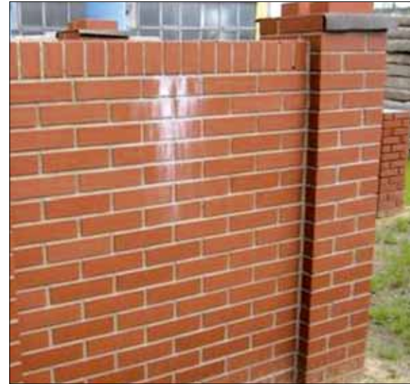
Fot. 2. Stosowanie domieszek nie zapobiega pojawieniu się wykwitów solnych
