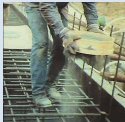
Wykonywanie posypki pod płytę fundamentową wieżowca Żaba Tower w Warszawie.
