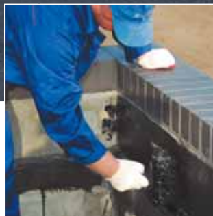
Gruntowanie Siplast Primerem®
