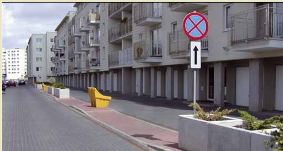
Fot. 1. Budynek z cofniętym parterem i podparciem słupami
