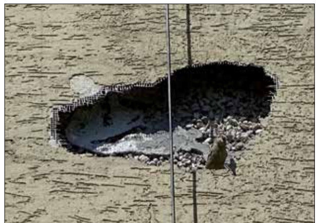
Fot. 7 | Uszkodzenia systemów ETICS – zerwane docieplenie, ptaki gniazdujące w dociepleniu (2016 r.)
