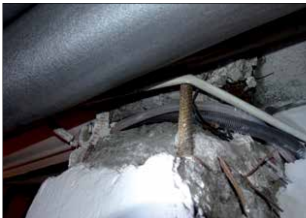
Fot. 3 | Zbrojenie odsłonięte i częściowo wycięte w trakcie prac instalacyjnych (2016 r.)
