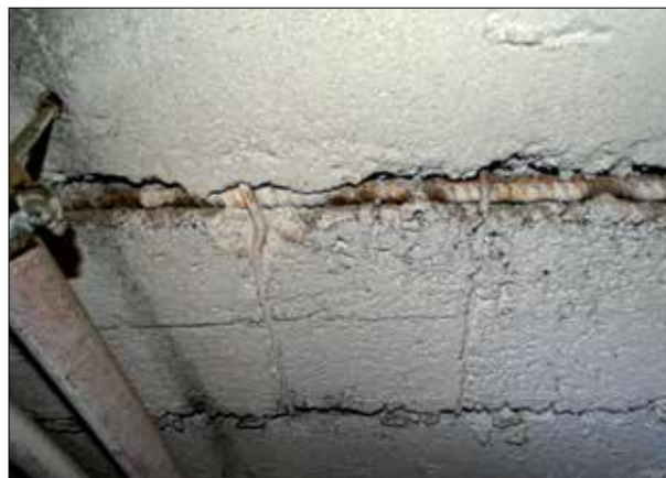
Fot. 4 | Strop docieplony i strop z odkrytym zbrojeniem pomalowanym farbą z gipsem (2016 r.)
