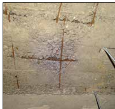
Fot. 2 | Zbrojenie w belce i w stropie niezabezpieczone od momentu wybudowania (2016 r.)
