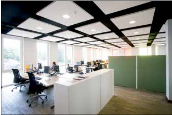
Rys. 3 | Wolno wiszące panele z wełny szklanej grubości 40 mm. Na wykresie podano chłonność akustyczną pojedynczej płyty 1200/1200 mm przy różnych wysokościach podwieszenia (od dołu: 200, 400 i 1000 mm)
