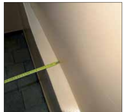
Fot. 1 | Nieosiowy i nierównoległy montaż płyt widoczny na klatkach schodowych (2016 r.)
