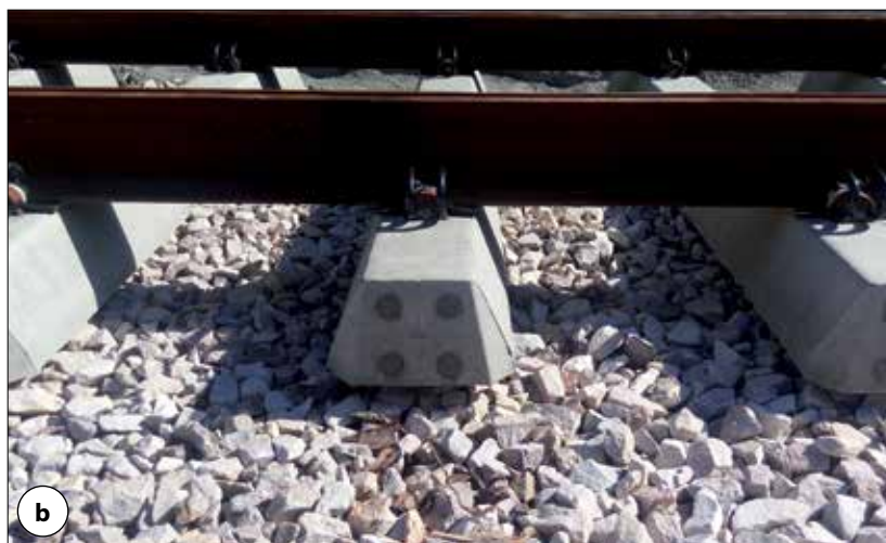
Fot. 1 | Fragment rusztu torowego z podkładem PT49 po lewej i PST11 po prawej stronie
