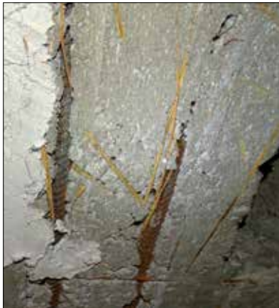
Fot. 5 | Brak korozji na części powierzchni zbrojenia (2016 r.)
