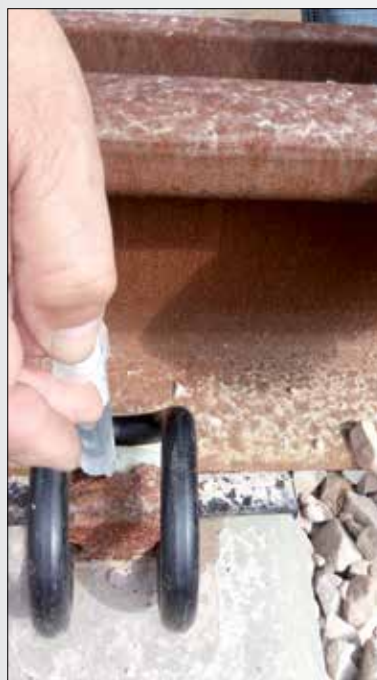
Fot. 2 | Dozowanie 10 ml wody w prze- strzeń między kotwę a wkładkę izolacyjną sprężystego przytwier- dzenia typu SB
