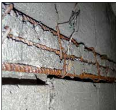
Fot. 2 | Zbrojenie w belce i w stropie niezabezpieczone od momentu wybudowania (2016 r.)
