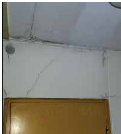
Fot. 6 | Budynek wzmocniony ściągami i bliźniaczy z licznymi zarysowaniami (2016 r.)
