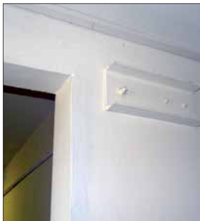
Fot. 6 | Budynek wzmocniony ściągami i bliźniaczy z licznymi zarysowaniami (2016 r.)
