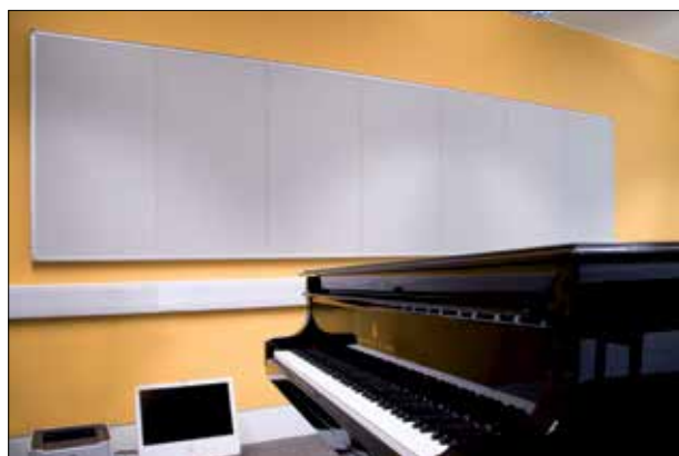
Rys. 5 | Panele ściennie z wełny szklanej grubości 40 mm montowane bezpośrednio na ścianie. Na wykresie podano wartości praktycznego współczynnika pochłaniania dźwięku \alpha_p
