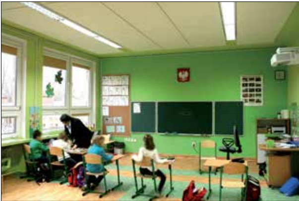
Rys. 1 | Dźwiękochłonne okładziny stropu grubości 40 mm wykonane z wełny szklanej. Na wykresie podano wartości praktycznego współczynnika pochłaniania dźwięku \alpha_p
