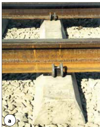
Fot. 1 | Fragment rusztu torowego z podkładem PT49 po lewej i PST11 po prawej stronie
