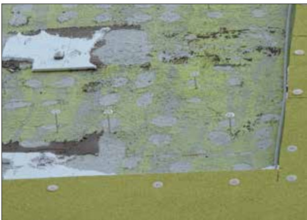
Fot. 7 | Uszkodzenia systemów ETICS – zerwane docieplenie, ptaki gniazdujące w dociepleniu (2016 r.)
