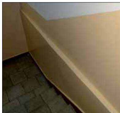
Fot. 1 | Nieosiowy i nierównoległy montaż płyt widoczny na klatkach schodowych (2016 r.)
