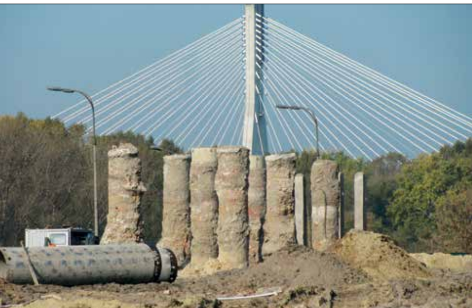
Fot. 1 | Przykład dużej budowy, gdzie wykonano bogaty program badań testowych, służących optymalizacji i potwierdzeniu przydatności poszczególnych technologii palowania
