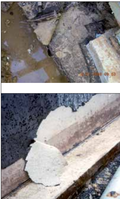
Fot. 3 | Skutki położenia masy KMB na źle przygotowanym podłożu; opis w tekście (fot. Weber-Deitermann)
