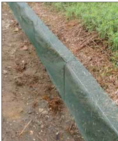
Fot. 1 | Przykład prawidłowo wykonanego tymczasowego ogrodzenia naprowadzającego
