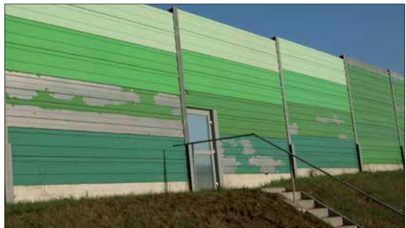
Fot. 9 i 10 | Delaminacja powłok malarskich spowodowana niewłaściwym przygotowaniem podłoża
