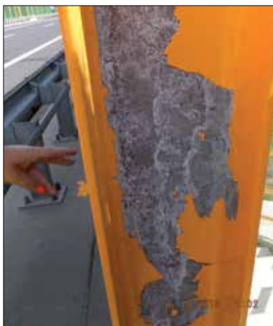
Fot. 9 i 10 | Delaminacja powłok malarskich spowodowana niewłaściwym przygotowaniem podłoża
