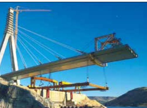
Fot. 2 | Przedłużone belki podsownicowe podwieszane do pomostu
