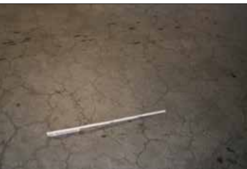
Fot. 3 | Siatka mikrorys powierzchniowych na posadzce
