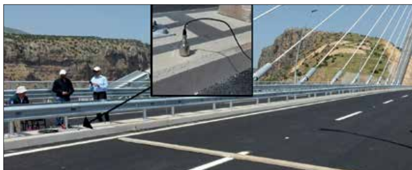
Fot. 6 | Dynamiczne obciążenia próbne
