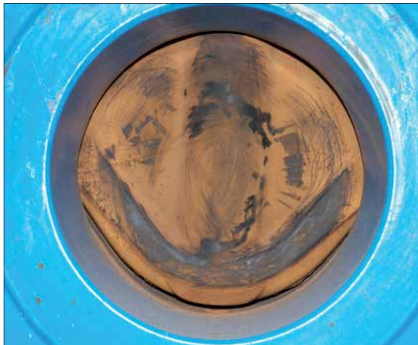
Fot. 1 | Oryginalny stopień otwarcia zasuw DN150 stosowanej do redukcji ciśnienia o 1,0 bar (fot. autora)
