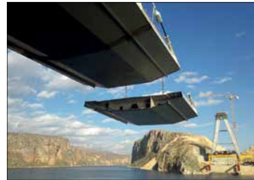
Fot. 1 | Typowy stalowy segment przęsła głównego w czasie podnoszenia
