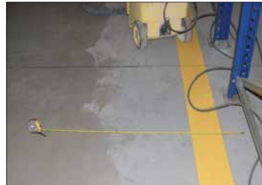
Fot. 1 | Nierównomiernie rozprowadzona warstwa utwardzająca
