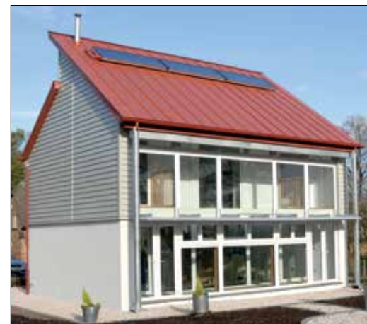
Fot. 2 Niskoenergetyczny budynek w angielskim Nottingham – pokrycie dachowe zabezpieczone powłoką zawierającą pigment odbijający promieniowanie słoneczne (fot. BASF)
