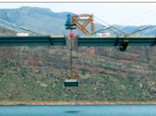
Fot. 3 | Podnoszenie ostatniego segmentu przęsła głównego
