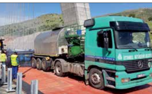
Fot. 4 | Układanie nawierzchni jezdni na pomoście pokrytym izolacją
