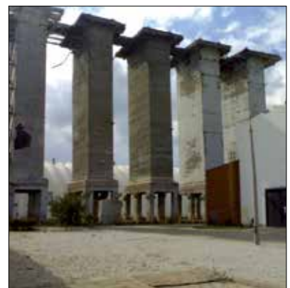
Fot. 2 | Wyburzanie wież granulacyjnych moczniaka w sąsiedztwie budynku kompresora CO 2
