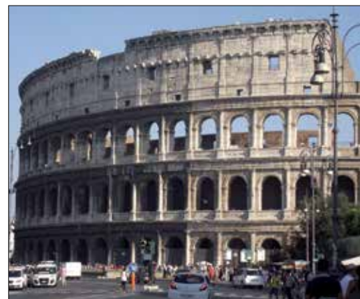
Fot. 6 | Koloseum w Rzymie – jeden z najwspanialszych przykładów architektury antycznej zbudowany na zaprawach hydraulicznych zawierających tuf wulkaniczny z okolic Wezuwiusza
