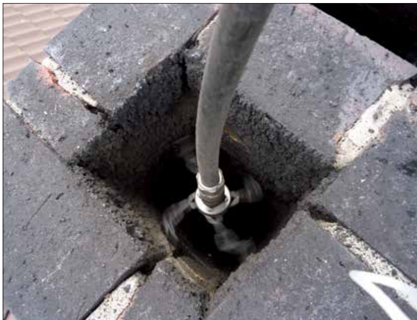
Fot. 1 | Głowica w czasie czyszczenia przewodu kominowego
