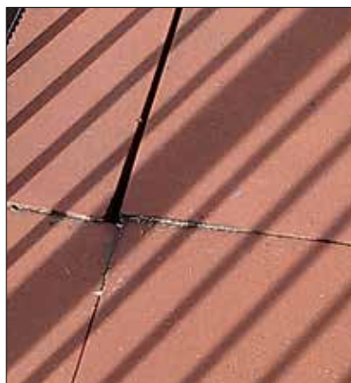
Fot. 4, 5 | Wariant drenażowy z płytami ułożonymi luzem (fot. autor)
