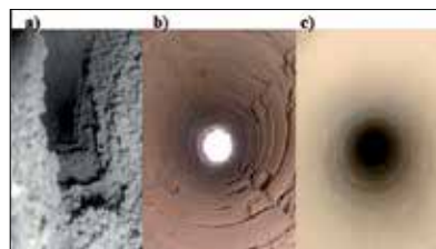
Fot. 2 | Etapy frezowania kominu: a) przed frezowaniem, b) po frezowaniu, c) komin po frezowaniu zabezpieczony wkładem ceramicznym (źródło: Jawar)
