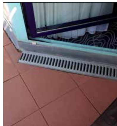
Fot. 4, 5 | Wariant drenażowy z płytami ułożonymi luzem (fot. autor)
