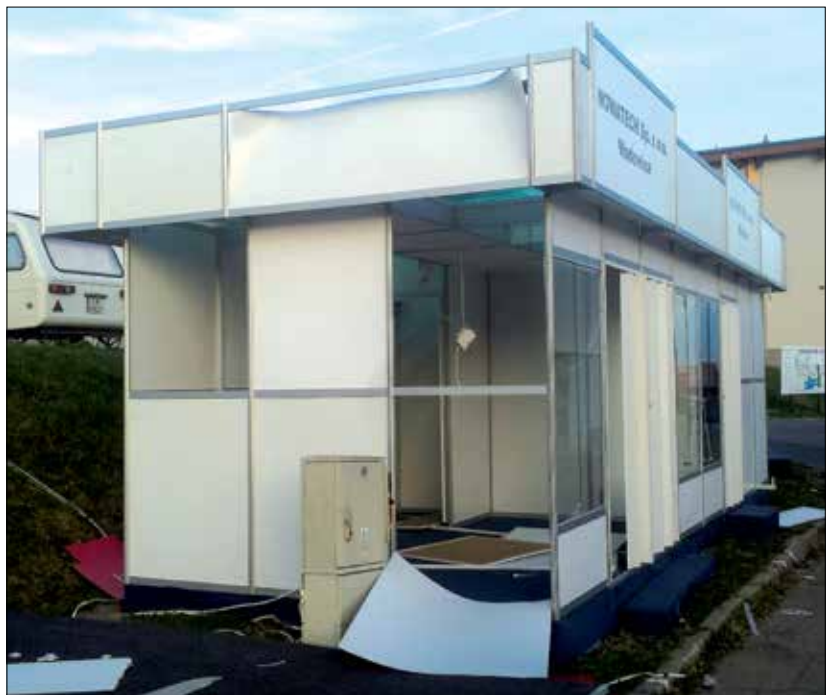
Fot. 2 | Pawilon wystawienniczy PHU Timex po przejściu wiatru halnego o prędkości powyżej 20 m/s
