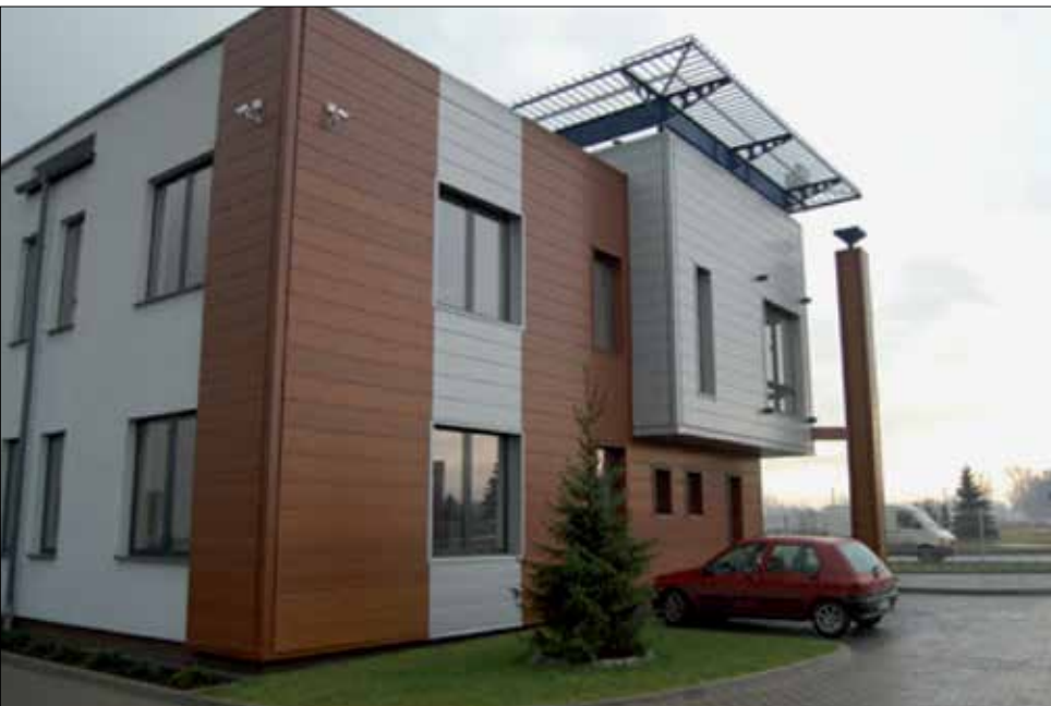
Fot. 3 | Fasada z panelem linearnym z powłoką drewnopodobną
