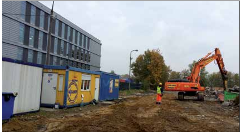
Fot. 1 | Wyburzanie fundamentów betonowych w sąsiedztwie budynku biurowego
