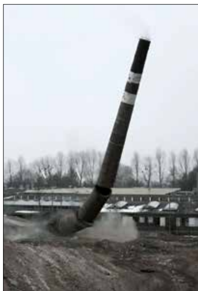
Fot. 4 | Złamanie komina ceglanego w czasie obalania
