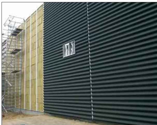
Fot. 4 | Fasada na kasetach stalowych i blachach falistych
