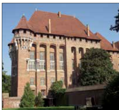
Fot. 7, 8 Pałac Wielkich Mistrzów na zamku krzyżackim w Malborku (fot. archiwum Hufgard-Optolith) oraz dawna przędzalnia fabryki I.K. Poznańskiego w Łodzi – przykłady współczesnej renowacji z wykorzystaniem kompleksowej technologii zapraw wapienno-trassowych, m.in. zapraw murarskich, fugowych, do reprofiliacji cegły oraz iniekcji szczelin i pustek w murze
