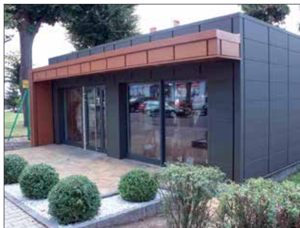
Fot. 5 | Przykład renowacji starego obiektu handlowego z wykorzystaniem stalowej fasady wentylowanej
