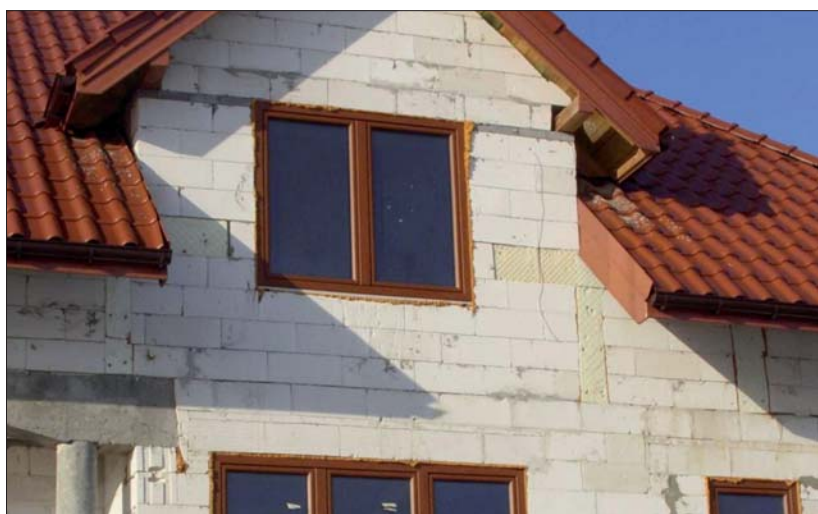
Ściana budynku ze słupkami osłoniętymi styropianem
