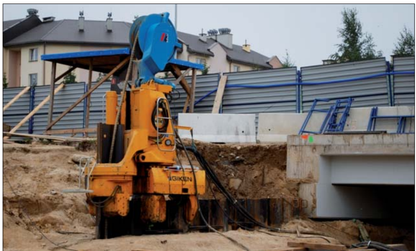
Fot. 1 | Weiskarka hydrauliczna pograżająca grodzice
