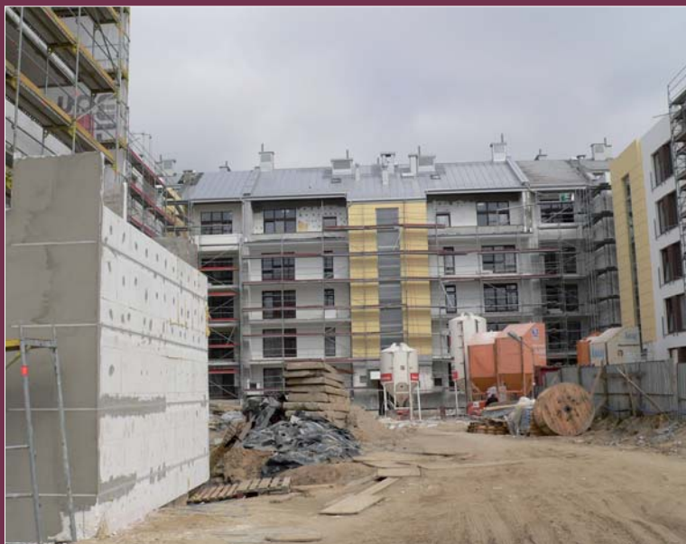
Budowa w Warszawie przy ul. Batalionów Chłopskich
