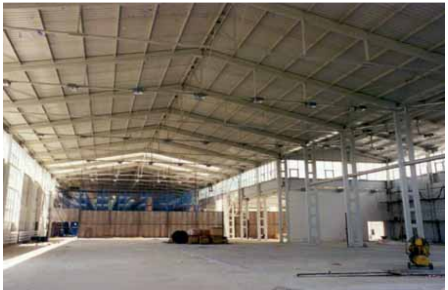
Fot.1. Widok konstrukcji systemowej hali produkcyjno-magazynowej
