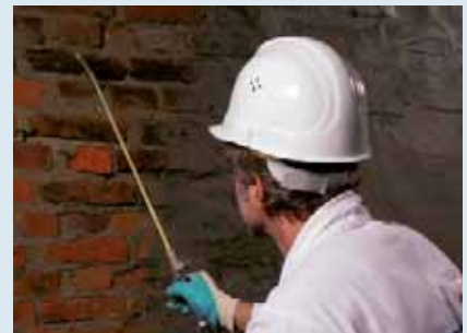
Fot. 2. Gruntowanie powierzchni muru preparatem Kiesol z wodą 1:1
