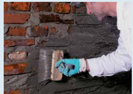
Fot. 4. Nakładanie materiału Sulfatexschlämme jako izolacji wewnętrznej w piwnicy
