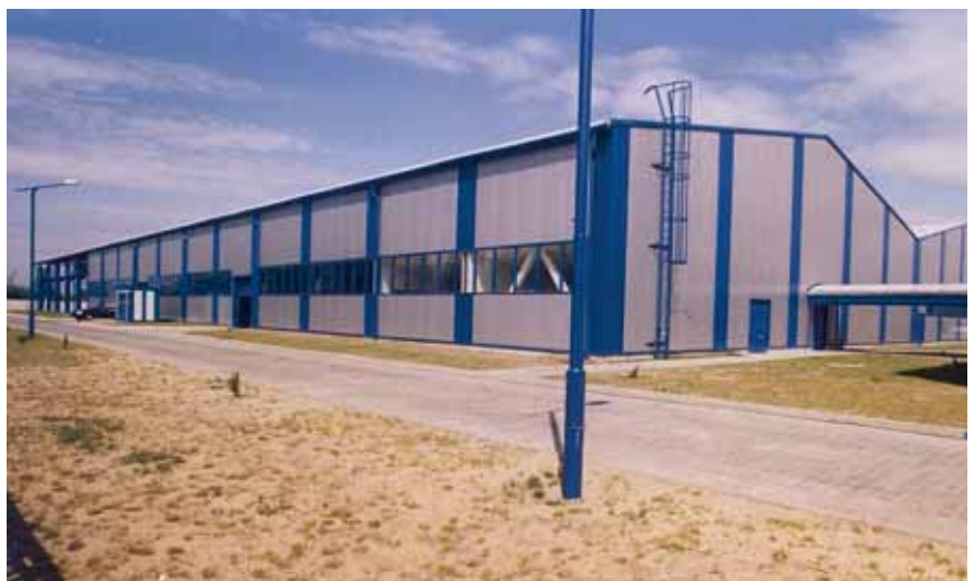
Fot. 2. Widok konstrukcji systemowej hali ze ściągami
