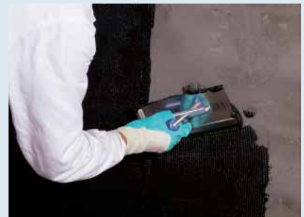
Fot. 3. Nakładanie masy bitumiczno-polimerowej Profi-Baudicht 1K
