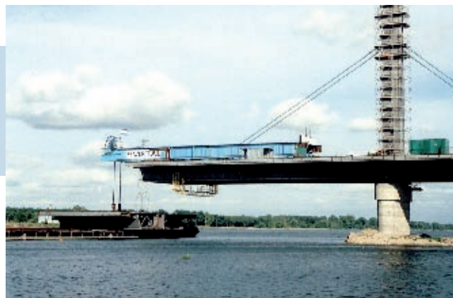
Fot. 4. Podnoszenie scalonego fragmentu konstrukcji (fot. A. Berger)
