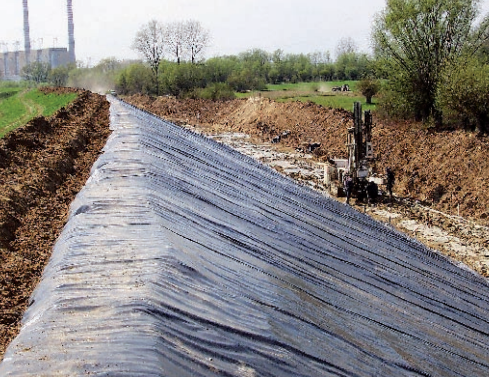
Wał przeciwpowodziowy w trakcie modernizacji, Fot. Archiwum Instytutu Melioracji i Użytków Zielonych
