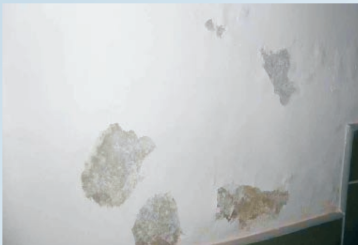
Fot. 3, 4. Przykład zastosowania farby uniemożliwiającej swobodną dyfuzję wilgoci z osuszonych ścian
