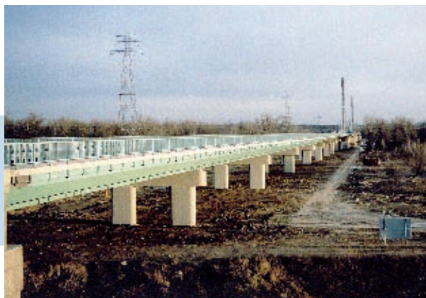
Fot. 1. Lewobrzeżny teren zalewowy – część belkowa mostu
