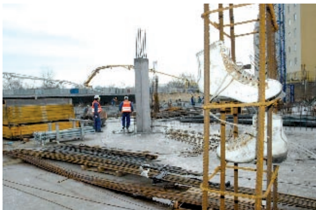
Budowa realizowana w Warszawie przez Budimex-Dromex fot. P. Baldwin
