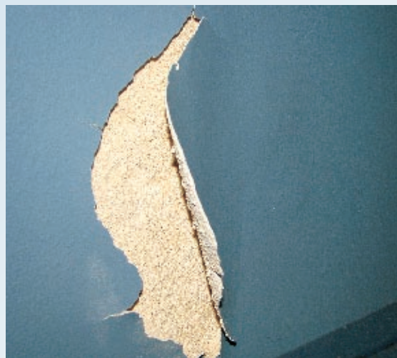
Fot. 3, 4. Przykład zastosowania farby uniemożliwiającej swobodną dyfuzję wilgoci z osuszonych ścian
