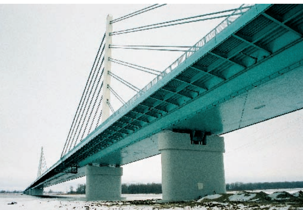
Fot. 8. Stan budowy po zakończeniu wszystkich robót (luty 2006)
