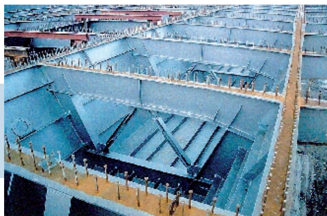
Fot. 2. Konstrukcja stalowa przed wykonaniem pomostu betonowego w części belkowej mostu
