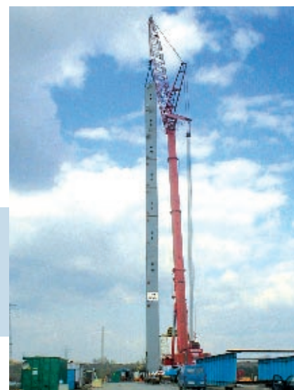
Fot. 5. Montaż pylonu od strony lewego brzegu z wykorzystaniem żurawia kołowego. Wysokość podnoszenia żurawia ponad 70 m (fot. P. Dawidowicz)
