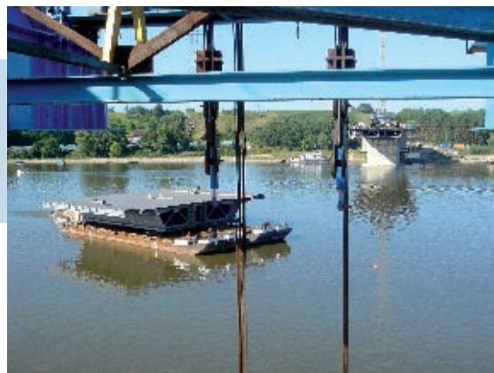
Fot. 7. Transport wodny segmentu przęsła głównego. Na przednim planie widoczne zawiesia w górnym położeniu
