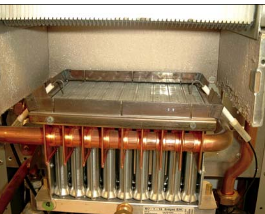
Fot. 1. Palnik inżektorowy w kotle wiszącym (WOLF)
