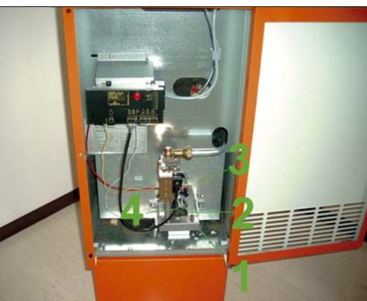
Fot. 2. Palnik inżektorowy w kotle stojącym (WOLF): 1 – kolektor, 2 – dysza gazowa, 3 – układ zapłonowy i kontroli płomienia, 4 – rura palnikowa
