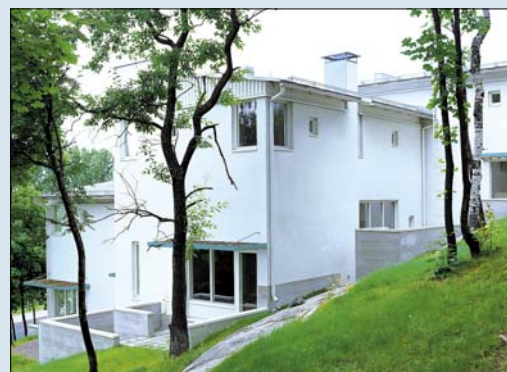
Elewacja budynku tymczasowo wykończona zaprawą maxit multi 290
