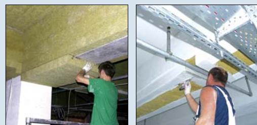
Przyklejanie wełny i szpachlowanie stropu garaży białą zaprawą maxit multi 290
