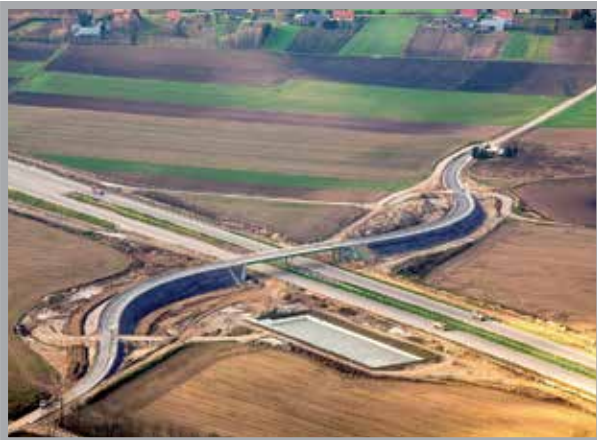
Nagroda SITK RP Oddział Rzeszów dla obiektów pozakonkursowych „Budowa autostrady A4 na terenie Podkarpacia” – nagroda I stopnia (fot. GDDKiA)
