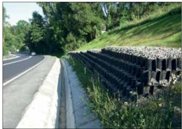
Fot. 8 | Konstrukcja wsporcza z systemu geokomórkowego
