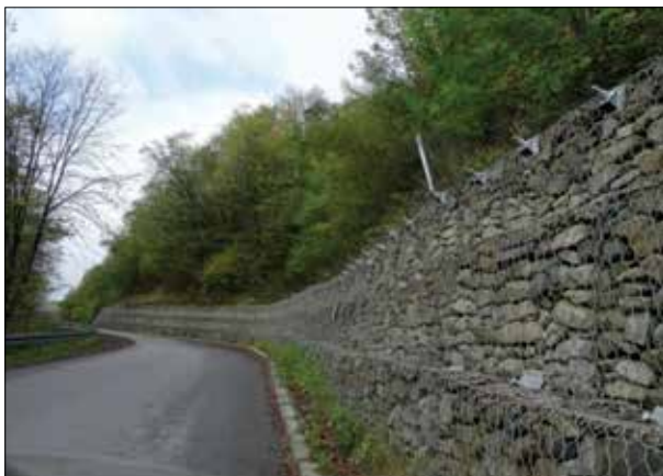
Fot. 6 | Konstrukcja gabionowa z gwoździami
