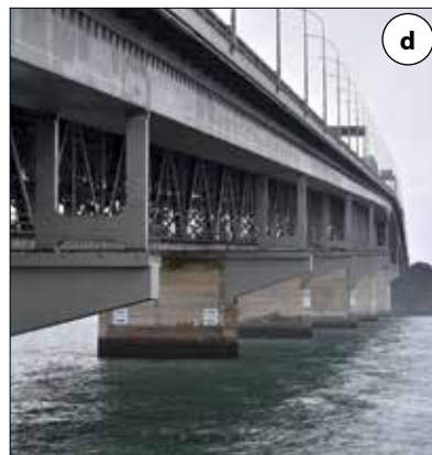
Fot. 7 | Most Auckland Harbour, Nowa Zelandia: a) poszerzony most, b) widok z boku na prześło główne, c) widok od spodu, d) poszerzone podpory (zdjęcia Fotolia: a) Rafael Ben-Air, b) carolemartygrant, c) Natalia, d) Danil Pohola)
