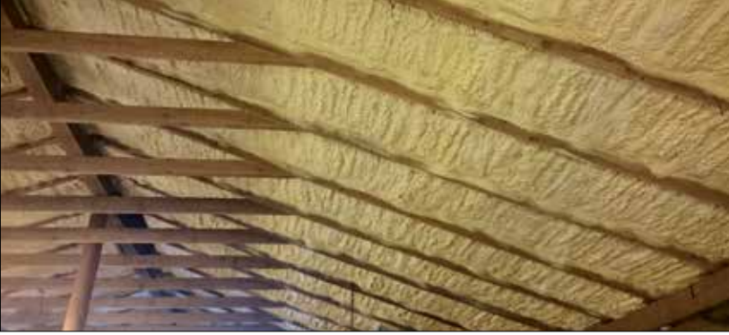
Fot. 3 | Spód dachu – ocieplenie natryskiwaną pianką poliuretanową
