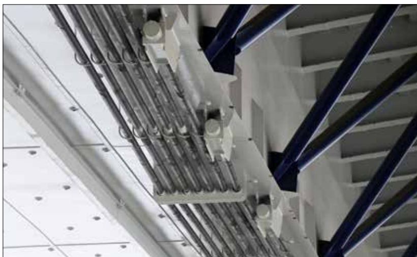
Fot. 5 | Most im. gen. Stefana Grot-Roweckiego – zakotwienia kabli sprężających (fot. A. Kasprzak)
