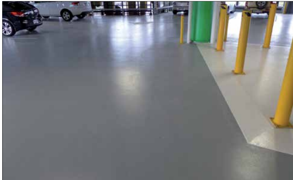
Fot. 2 | Posadzki w garażu wielokondygnacyjnym [13]
