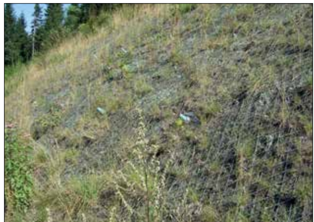
Fot. 7 | Konstrukcja osłonowa zbocza z siatki i gwoździ
