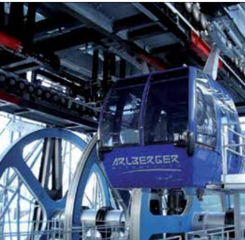
Fot. 4 | Kolej typu Funitel Galzigbahn – St. Anton w Austrii
