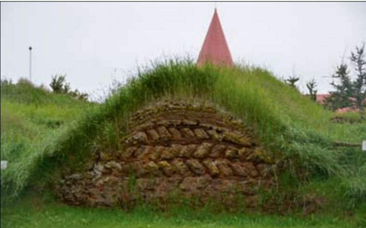
Fot. 2 | Budynki z torfu, układ w jodelkę, Skagafjörður
