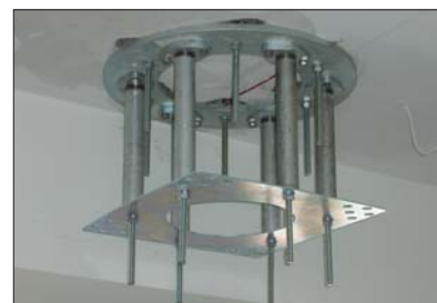
Fot. 8 | Sposób montażu kolumn w stropach
