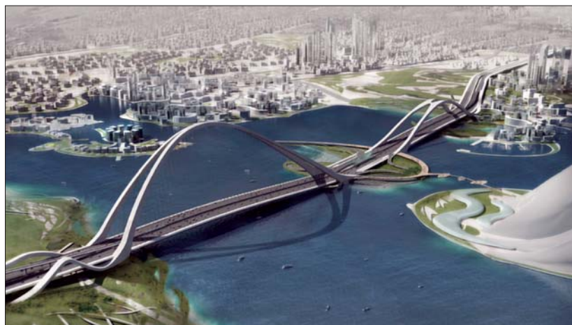
Fot. 3 | Najwyższy most łukowy na świecie budowany obecnie w Dubaju o wysokości łuku 205 m
