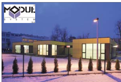
Przedszkole Targówek Moduł System S.A. – wykonawca przedszkola
