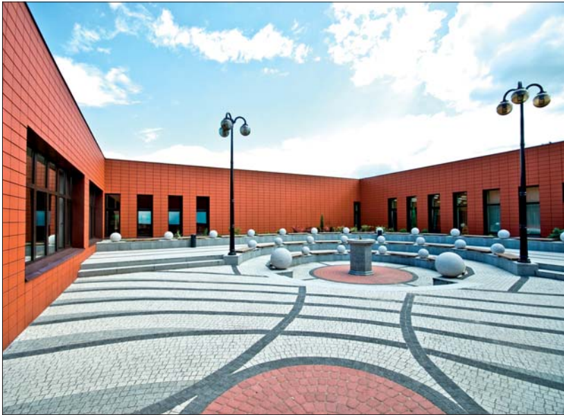
Fot. 3 | Elewacje wentylowane (archiwum firmy Euronit)
