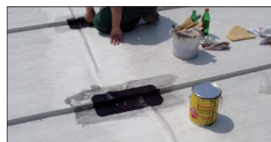
Fot. 10 | Naprawy styków zdeformowanego pokrycia
