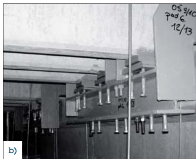
Fot. 8 | Wzmocnienia stref podporowych: a) maty kompozytowe, b) wsporniki stalowe
