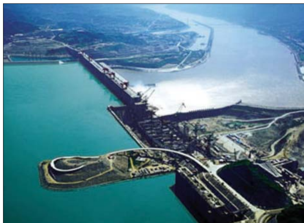
Fot. 2 | Tamca Trzech Przełomów na Jangcy o długości 2300 m i wysokości 185 m
