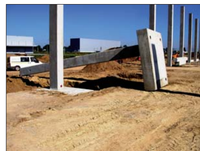
Fot. 2 | Montaż stopostupów
