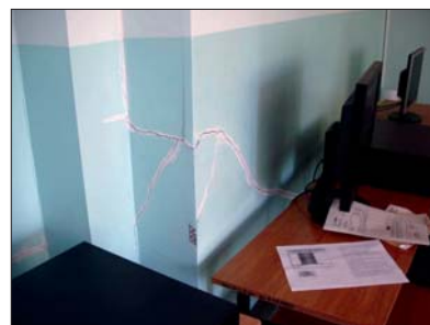
Fot. 11 | Przykłady spękań działowych ścianek od ugięć stropów
