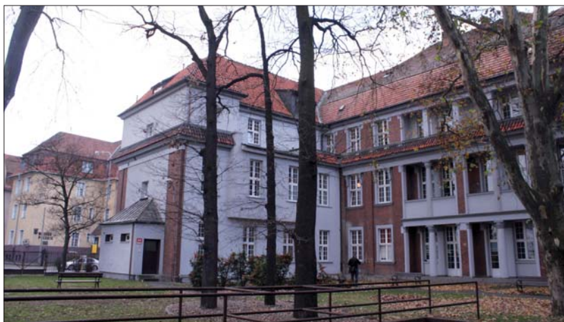
Fot. 1 | Ogólny widok budynku szpitala z wysokim poddaszem nieużytkowym
