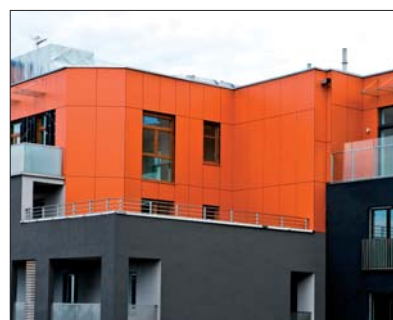
Fot. 1 | Elewacje wentylowane. (Archiwum firmy Euronit)
