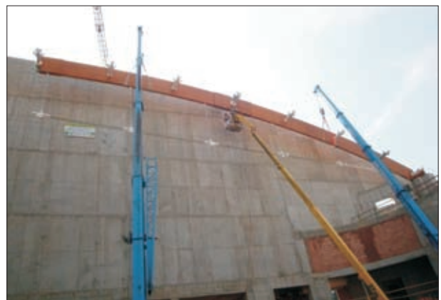
Fot. 5 | Scalone dwa segmenty podwieszane na dwóch żurawiach
