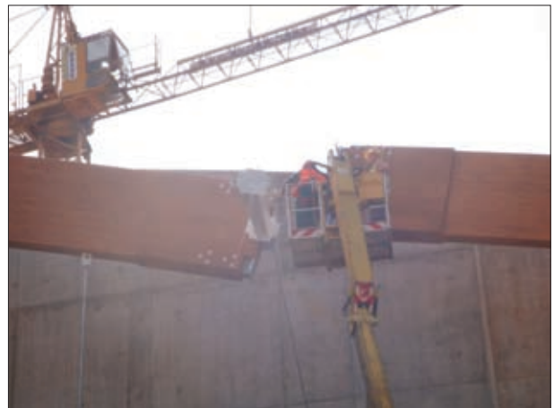
Fot. 4 | Scalanie segmentu skrajnego z segmentem środkowym
