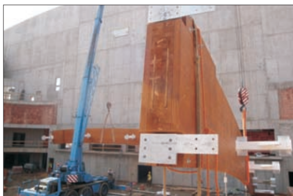
Fot. 2 | Podnoszenie pierwszego elementu dźwigara
