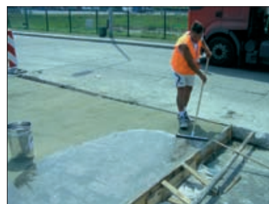
Fot. 1 | DPG Dorohusk. Układanie pielęgnującej i wzmacniającej żywicy epoksydowej StoPox FBS-LF na świeżym betonie nawierzchniowym
