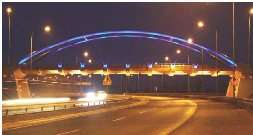
Fot. 1. Wiadukt B9 w ciągu drogi krajowej nr 7 w Nowym Dworze Gdańskim posadowiony na palach prefabrykowanych 400 x 400 mm, L = 15 i 16 m. Projektant: mgr inż. Adam Nadolny, Transprojekt Gdańsk
