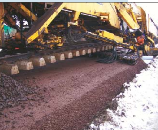
Fot. 4. Wybieranie warstwy podtorza i wbudowanie warstwy wzmacniającej (niżej)
