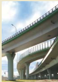
Na okładce: Warszawa, wiadukty węzła Trasy Siekierkowskiej i Wi- słostrazy; grudzień 2007 r. Fot. Paweł Baldwin
